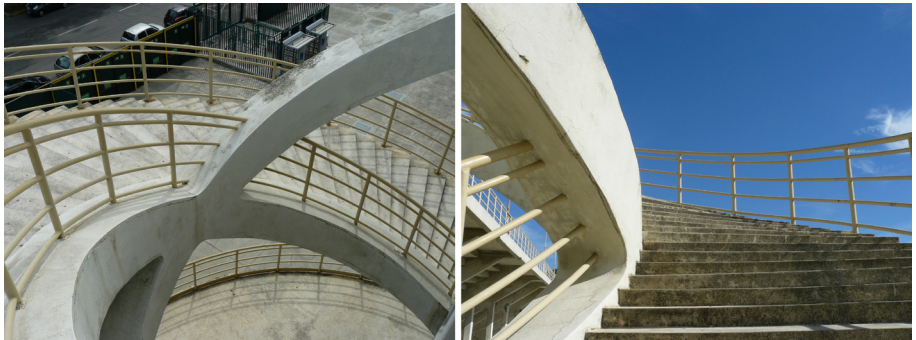
Figura 3.3.4 – Particolari dell’incrocio tra le due travi elicoidali.
