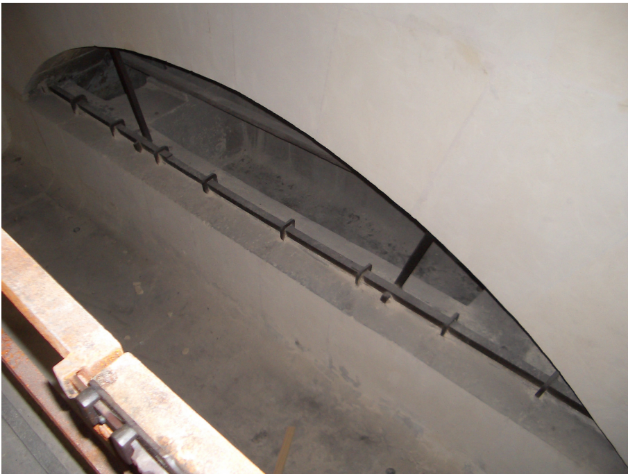
Figura 1.2.29 – La piattabanda armata del Panthéon.
