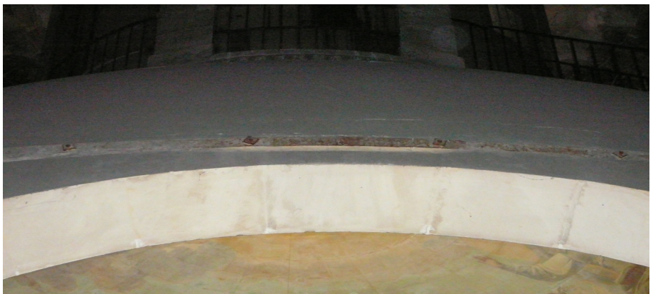
Figura 2.7.16 – Particolare della catena numero 4, che cinge la cupola intermedia.
