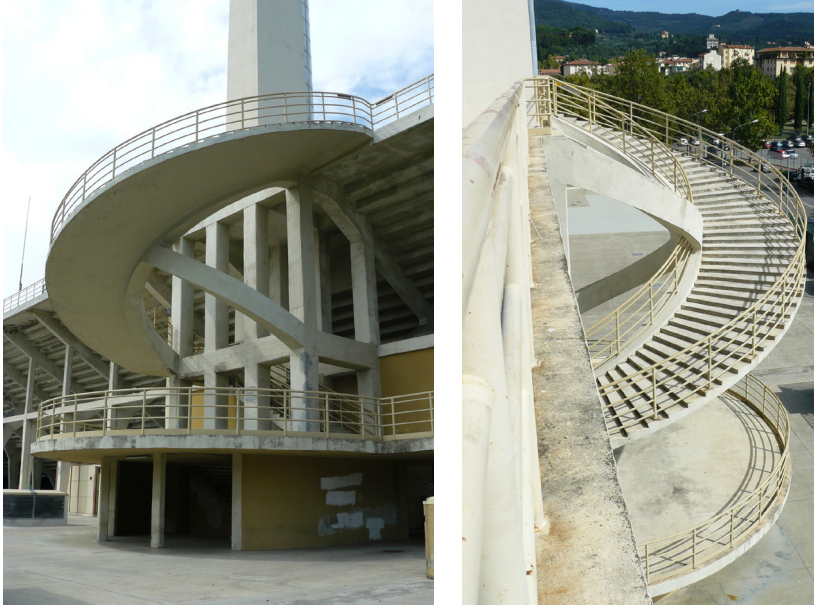
Figura 3.3.2 – Lo scalone elicoidale di accesso alle gradinate scoperte.
