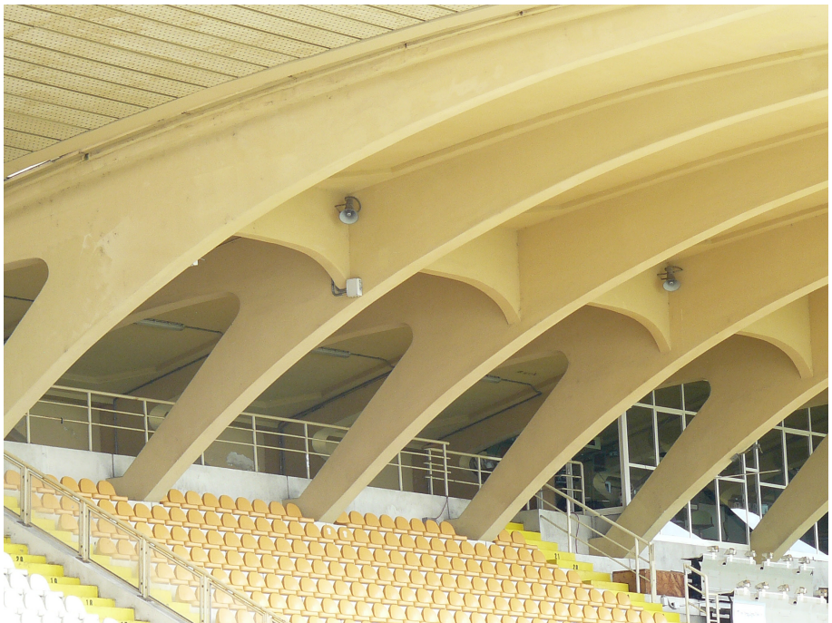
Figura 3.3.1 – La pensilina di copertura della tribuna d'onore.
