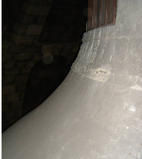
Figura 2.5.4 – Foto del raccordo smussato tra la cupola intermedia e la lanterna 39 .
