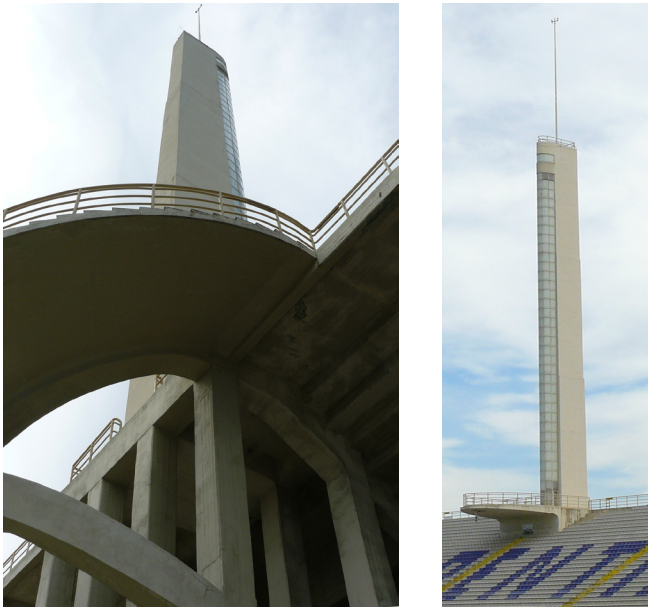
Figura 3.3.3 – La torre Maratona e la pensilina semiellittica orizzontale collocata alla sua base.
