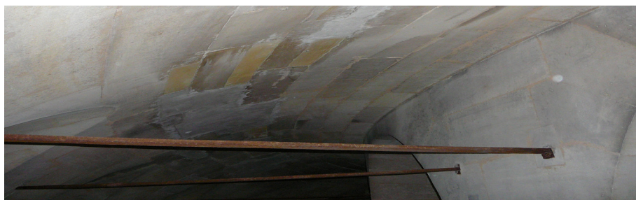
Figura 2.7.14 – Le catene radiali nella galleria superiore.
