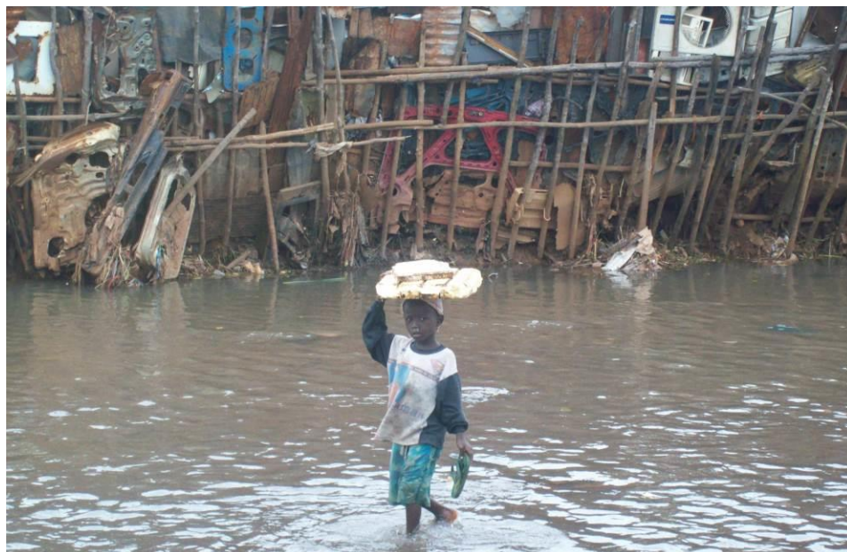
Figura 46 – Arginature autoconstruite di difesa dall'alveo del fiume
