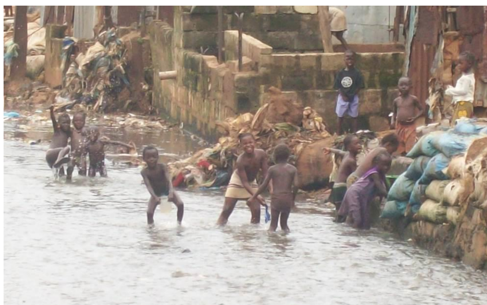
Figura 30 – Arginature autoconstruite dalla comunità dei residenti dello slum di Kroo bay
