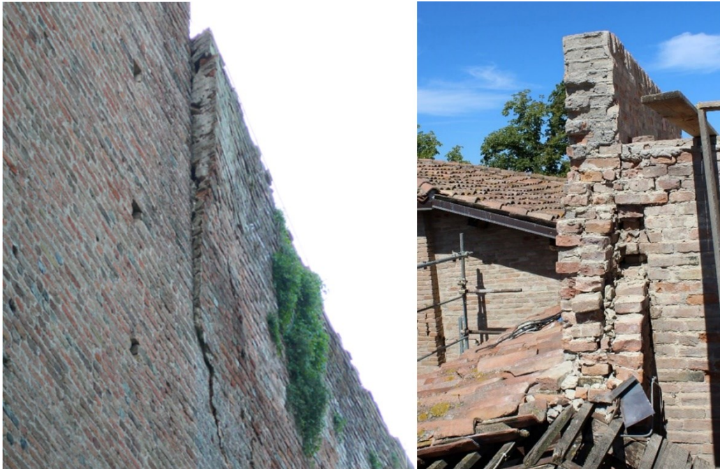
Figura 4 Due esempi di ribaltamento fuori dal piano del muro di cinta: a sinistra la Rocca di Reggiolo, a destra la Rocca estense a San Felice sul Panaro.
