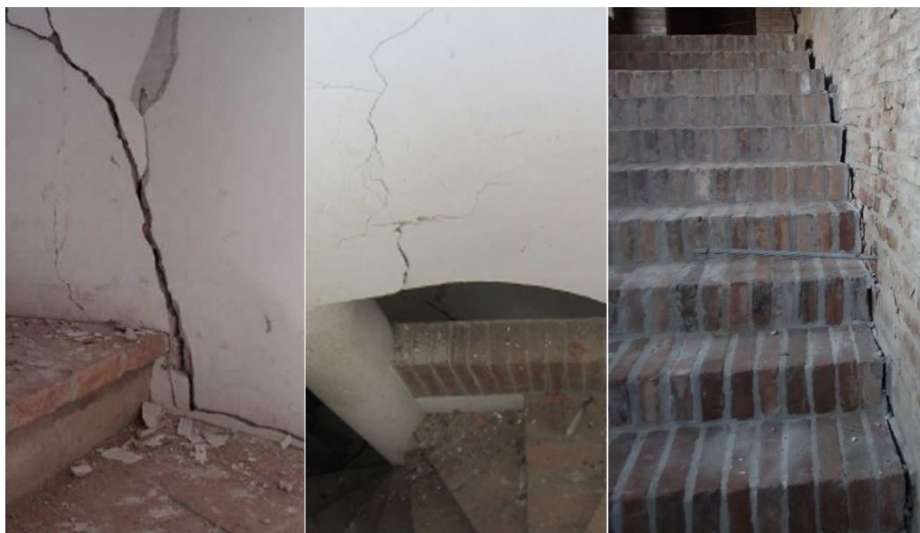
Figura 28 Danni alle scale della Rocca Stellata di Bondeno (Ferrara) e della Rocca di San Felice sul Panaro.
