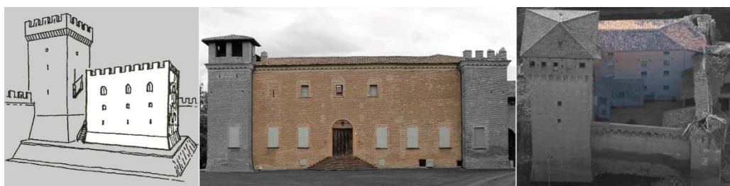
Figura 17 La struttura a più piani del palazzo spesso si colloca vicino a una o più torri e addossata al muro di cinta. A sinistra una rappresentazione schematica tratta da RIMONDINI G., PALLONI D. 2017, p.65; al centro: Rocca Isolani a Minerbio, Bologna; a destra: Rocca di San Felice sul Panaro, Modena.
