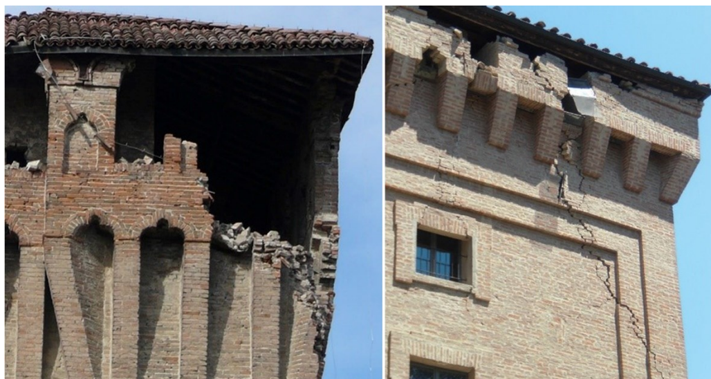
Figura 11 A sinistra espulsione del cantonale in una delle torri del Castello delle Rocche, Finale Emilia; a destra tipica lesione inclinata che evidenzia l'attivazione del meccanismo in una torre del Castello dei Ronchi a Crevalcore, nel bolognese.
