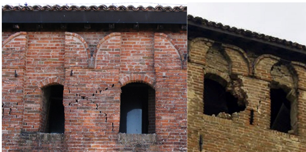
Figura 34 Tipiche lesioni da taglio incrociata a X. A sinistra merli del mastio della Rocca di San Felice sul Panaro; a destra merli di una delle torri della Rocca di Finale Emilia.
