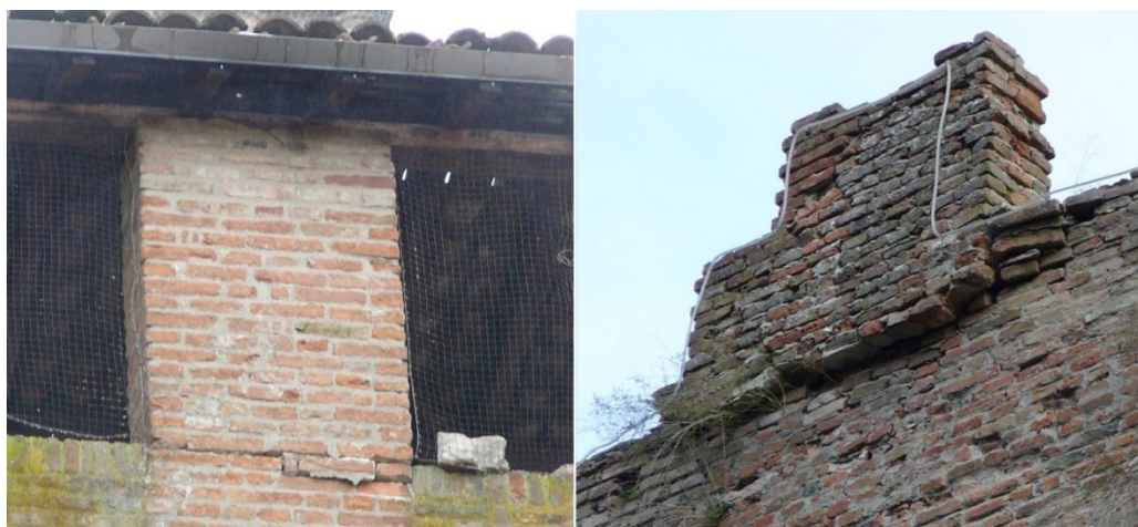
Figura 33 Due foto esemplificative del meccanismo, in cui risulta ben visibile il piano orizzontale di scorrimento alla base del merlo: a sinistra un merlo del muro di cinta della Rocca di San Felice soggetto alle spinte degli elementi copertura; a destra un merlo della Rocca di Reggiolo prossimo alla fase di ultimo spostamento al limite del crollo.
