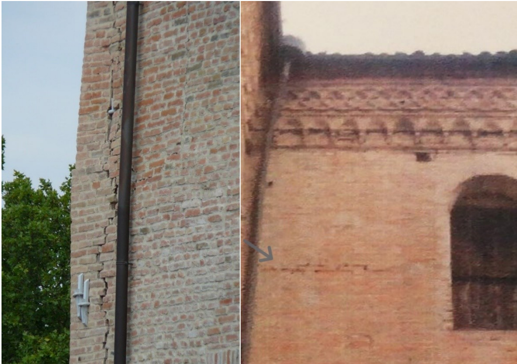
Figura 14 Due esempi di flessione verticale fuori dal piano. A sinistra Castello dei Pico a Mirandola, nel modenese; a destra Rocca Isolani, in provincia di Bologna.
