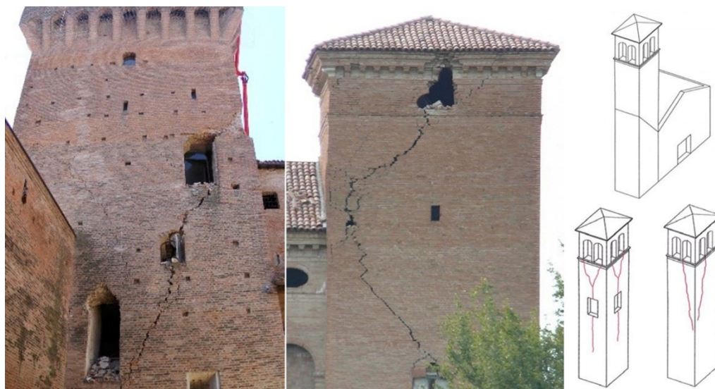
Figura 9 A sinistra lesioni a taglio che collegano le varie aperture del mastio della Rocca estense, San Felice sul Panaro; lesioni inclinate che hanno come fulcro la quota in cui la torre diviene svettante rispetto al resto del corpo di fabbrica (Castello delle Torri a San Prospero, Modena). A destra il meccanismo del campanile (M27 da Scheda chiese Modello A-DC), che consiste in rotazioni e deformazioni nel piano e che può avere alcune analogie con il cinematicismo delle torri qui descritto.
