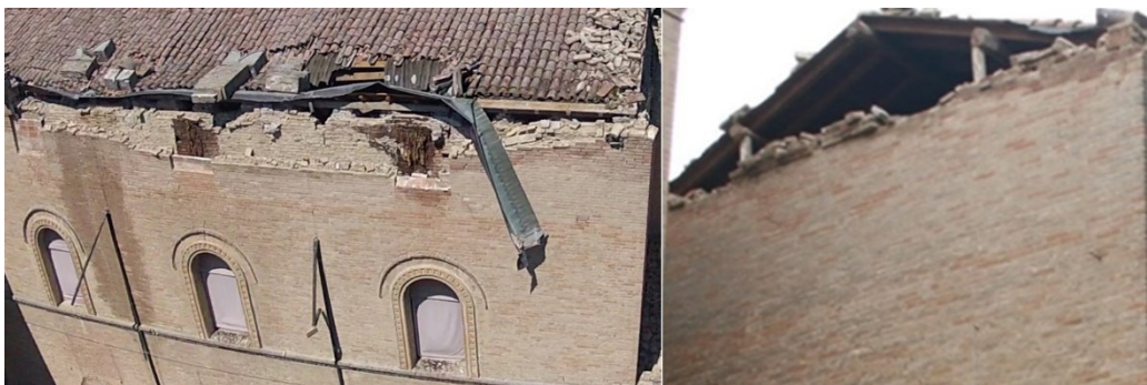
Figura 17 Castello di Galeazza Pepoli a Crevalcore: il ribaltamento fuori dal piano una porzione di muratura nella fascia alta del fabbricato (a sinistra) o del timpano (a destra).
