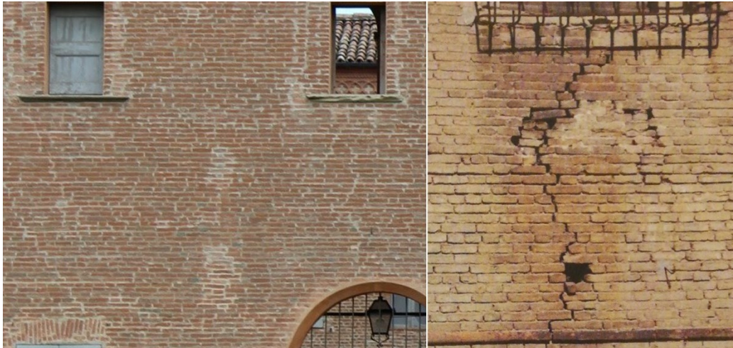
Figura 19 Tipiche lesioni a taglio delle fasce murarie: a sinistra Rocca Isolani a Minerbio; a destra Rocca dei Gonzaga a Novellara.
