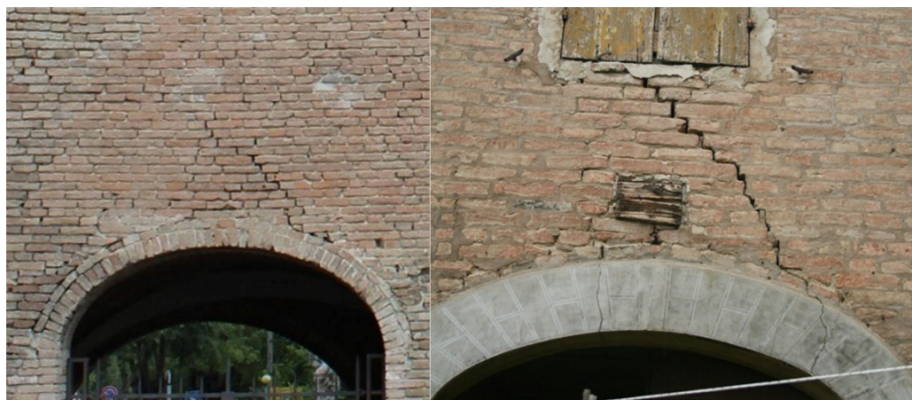
Figura 25 Cedimento dell'arco e della relativa volta a botte per allontanamento di uno dei due piedritti. A sinistra Castello delle Rocche a Finale Emilia; a destra Castello Galeazza Pepoli.
