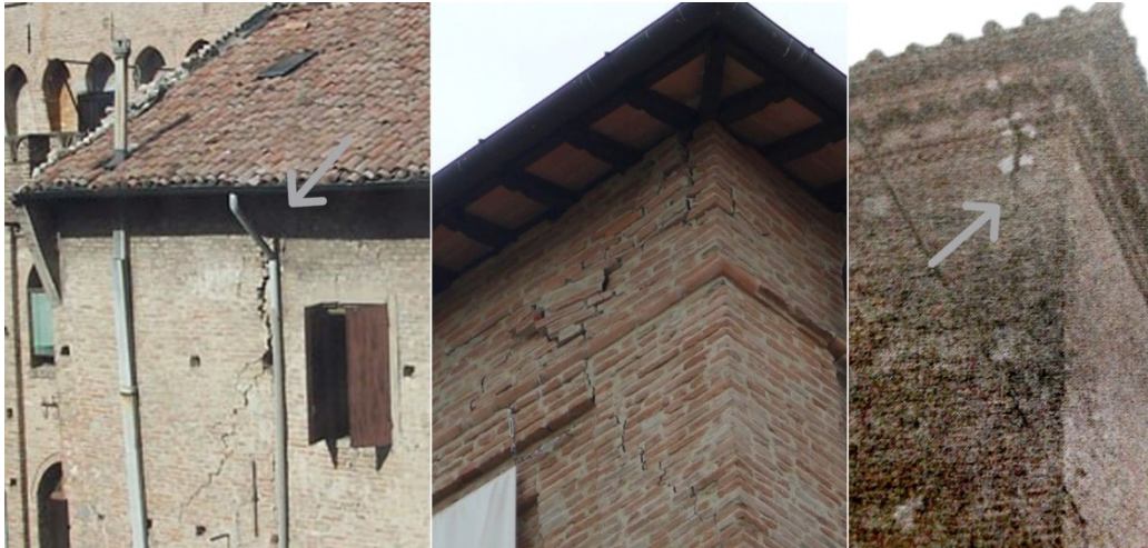
Figura 16 lesioni tipiche del meccanismo di espulsione del cantonale. Da sinistra: due foto del castello dei Pico a Mirandola e il Castello dei Bentivoglio.
