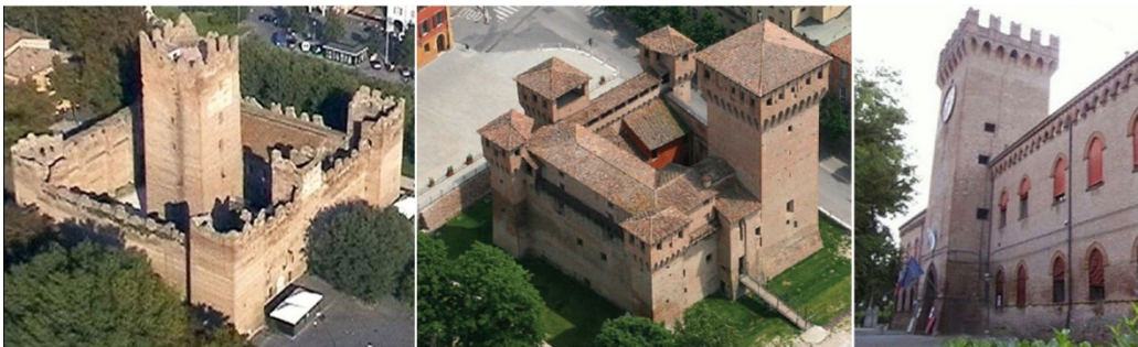
Figura 16 Alcuni esempi di diverse disposizioni delle torri nei complessi castellani. Da sinistra: Torre centrale isolata, torre inglobata e torri ad angolo aperte nella Rocca di Reggiolo, Reggio E.; Torri ad angolo
