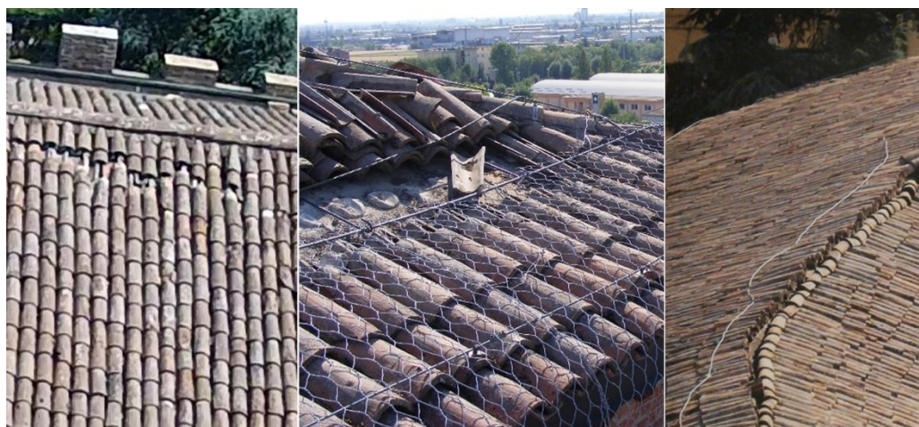
Figura 27 Scivolamento dei coppi. Da sinistra: Castello di Galeazza Pepoli, Mastio della Rocca di San Felice, Rocca di Cento.
