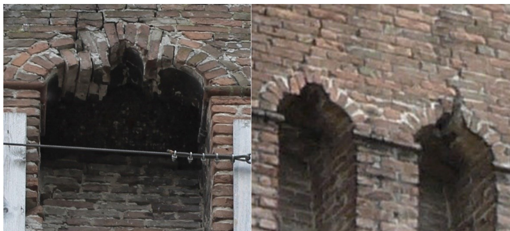
Figura 36 Classico meccanismo di dissesto dell'arco: l'allontanamento del piedritto, in questo caso del beccatello, determina minori forze di compressione tra i conci dell'arco e quindi il loro scivolamento. A sinistra un dettaglio di una delle torri della Rocca di Finale Emilia; a destra un dettaglio del mastio del Castello di Galeazza Pepoli.
