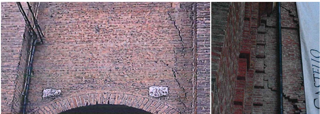
Figura 22 Irregolarità di forma possono generare fenomeni di martellamento tra strutture non ben ammortate: a sinistra Castello estense di Ferrara; a destra Castello dei Pico a Mirandola.
