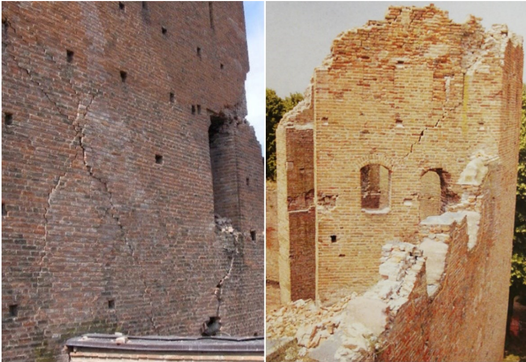
Figura 10 Le lesioni da taglio nella parte svettante della torre possono manifestarsi incrociate (Rocca estense, San Felice sul Panaro a sinistra) o singole e inclinate a 45° (Rocca, Reggiolo a destra).
