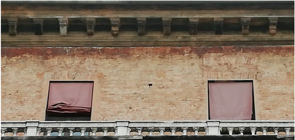
Figura 6 Cornice lignea del Castello estense di Ferrara, che corre lungo tutto il perimetro dell'edificio (foto dell'autrice).
