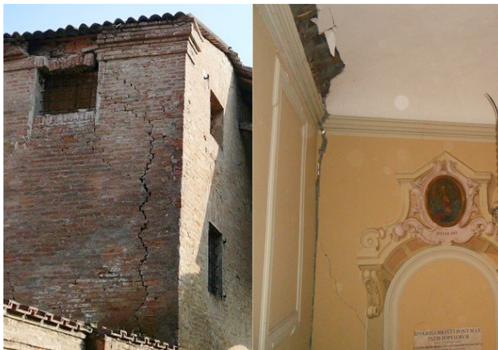
Figura 13 A sinistra lesione da ribaltamento nel Castello dei Ronchi a Crevalcore; a destra un muro della zona dello scalone del Castello Lambertini a Poggio Renatico, la cui snellezza e altezza interpiano elevata, in quanto privo di orizzontamenti intermedi, lo rendevano particolarmente vulnerabile a meccanismi fuori dal piano.
