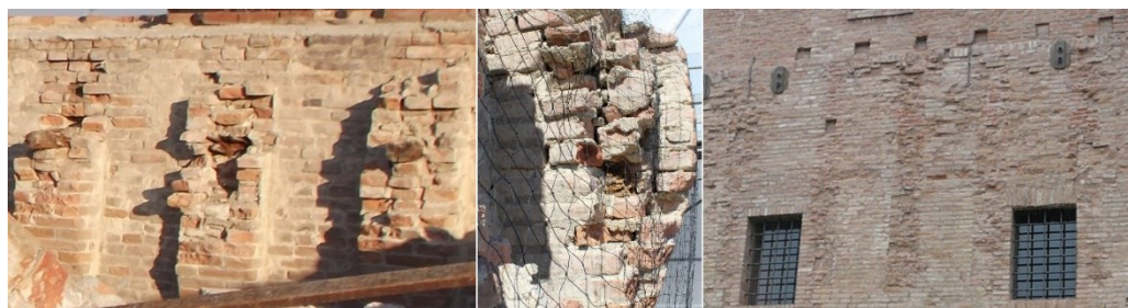
Figura 23 Ben visibili risultano da queste foto gli elementi lignei interni ai beccatelli (nelle due foto a sinistra Rocca di San felice sul Panaro); a destra le buche pontate per l'alloggio degli elementi lignei in corrispondenza dei beccatelli non più in essere, Rocca di Finale Emilia.
