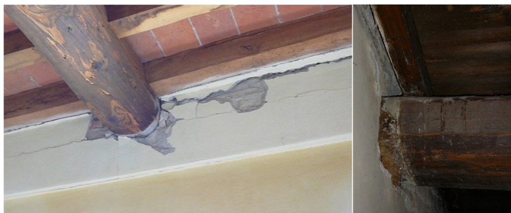
Figura 23 Due esempi di sfilamento della testa delle travi, congiunti a fenomeni di martellamento che hanno danneggiato la muratura. A sinistra Castello dei Pico a Mirandola; a destra Rocca estense di San Felice.
