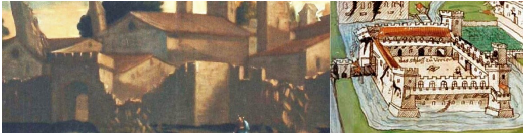
Figura 2. A sinistra: Terremoto di Argenta di C. Ricci, XVII sec: particolare delle mura della città con l'attivazione di meccanismi di flessione orizzontale (a sinistra) e ribaltamento fuori dal piano dei merli (a destra); a destra Ferrara distrutta dal terremoto del 1570 di H. J. Helden, dettaglio del Castello estense di Ferrara danneggiato, con dissesti concentrati soprattutto nelle zone di contatto tra torre svettante e gli altri corpi di fabbrica.
