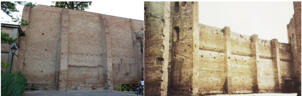
Figura 12 Due esempi di mura di cinta con contrafforti: da sinistra Rocca di Pieve di Cento, Rocca di Reggiolo.
