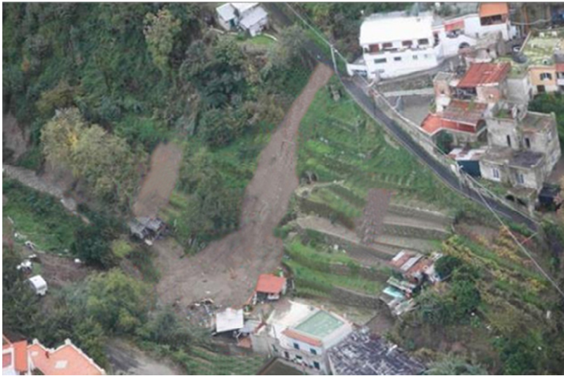
Figura 6. La frana che ha avuto luogo a Casamicciola Terme (Napoli).
