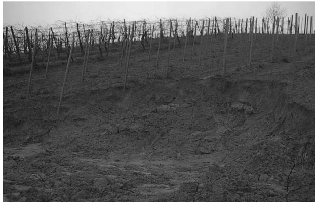
Figura 12. Uno dei soil slip accaduti nell'Oltrepo Pavese il 26/11/2000. (Meisina e Scarabelli, 2007).
