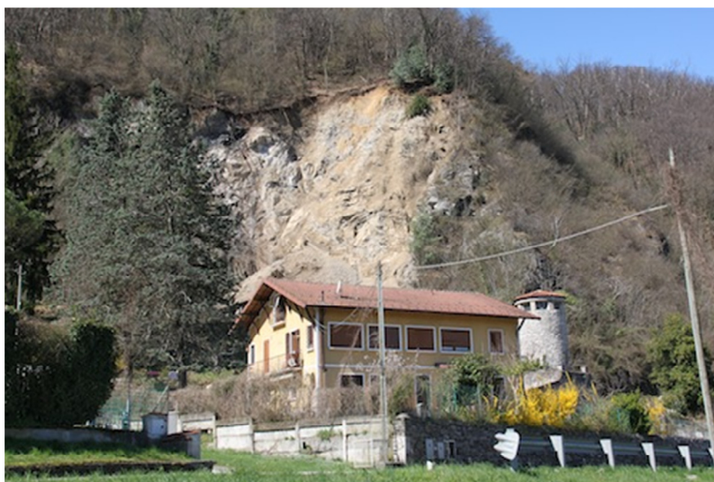
Figura 18. La frana che ha avuto luogo a Germignaga (Varese).
