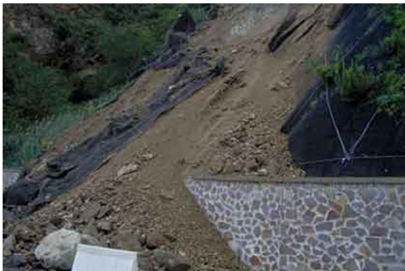
Figura 45. La frana che ha avuto luogo sulla Strada Statale 18 a seguito del nubifragio del 13 ottobre 2010 in Provincia di Reggio Calabria.
