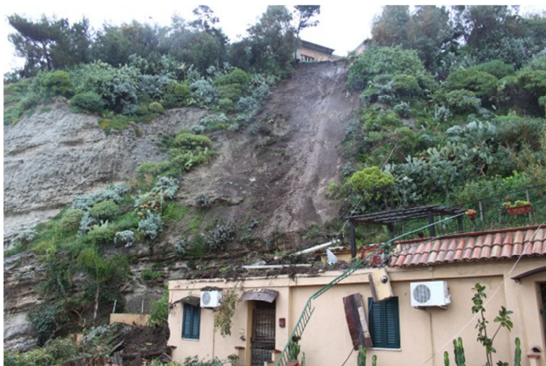
Figura 59. La frana che ha avuto luogo a Tropea, Provincia di Vibo Valentia, il 1° marzo 2011.
