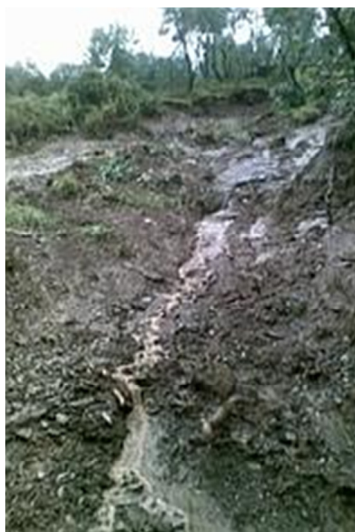
Figura 26. La frana che ha avuto luogo a Uscio (Genova).
