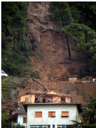
Figura 49. La frana che ha avuto luogo a Massa Carrara a seguito del nubifragio del 31 ottobre 2010.
