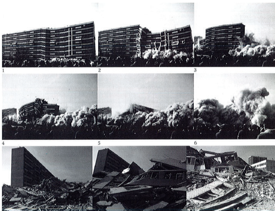
fig. 14 Demolizione della Barre Debussy nella Cité des Quatre Mile a La Corneuve, Francia, 1986
