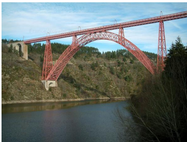
Figura 3.2: Viadotto di Garabit (1880-1884, luce 165 m).
