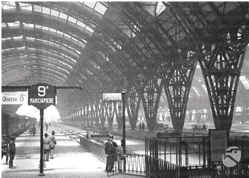
Figura 3.6: Copertura della stazione di Milano (1929).
