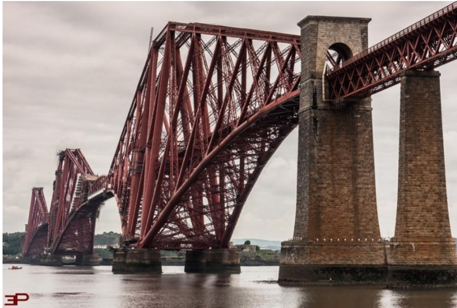
Figura 3.1: Ponte Cantilever sul Firth of Forth (1881, luce libera 521 m).
