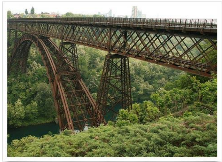
Figura 3.5: Ponte di Paderno sull'Adda (1887-1889, luce 150 m).
