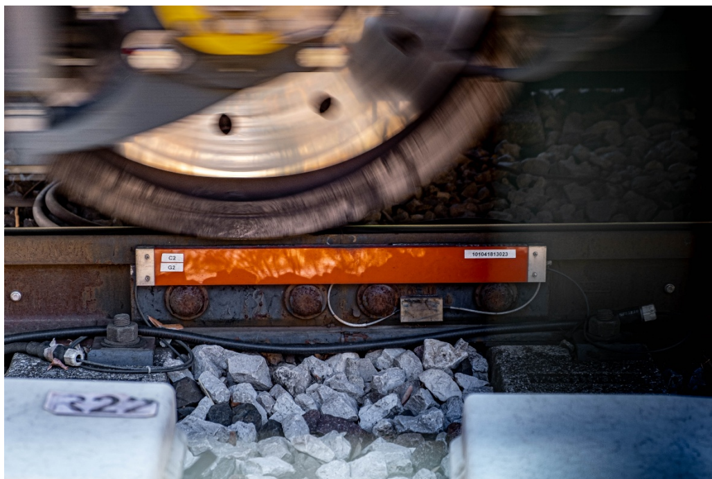
Figura 4-7 Sensori di spostamento installati su binari in esercizio a Crespellano (BO)
