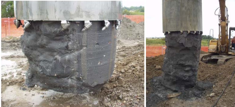
FIG. 7-21 - JET GROUTING – CAMPO PROVA A TERRA DI LIDO – FASI DI ESTRAZIONE DELLA COLONNA JGT8, SPEZZONE INFERIORE
