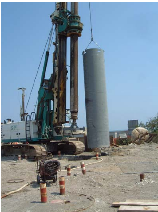
Fase di posizionamento del carotiere DN1500
