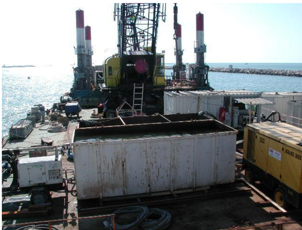
b) In primo piano, vascone per lo stoccaggio dell'acqua di pretaglio e dietro, sulla destra, la pompa per l'acqua di pretaglio, sul primo pontone ausiliario
