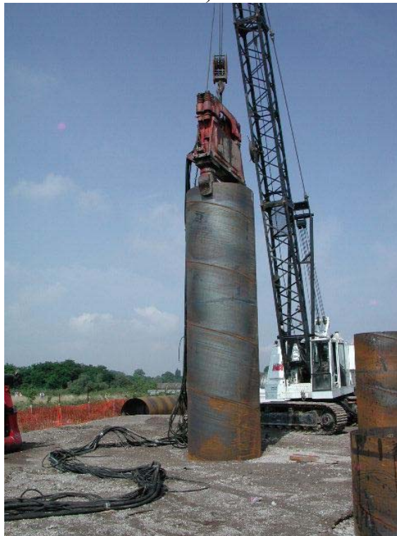
FIG. 7-5 - JET GROUTING – ESECUZIONE DELLE COLONNE A TERRA – A) RIVESTIMENTO FINO A QUOTA -6/-12.50 – B) INFISSIONE DEL RIVESTIMENTO
