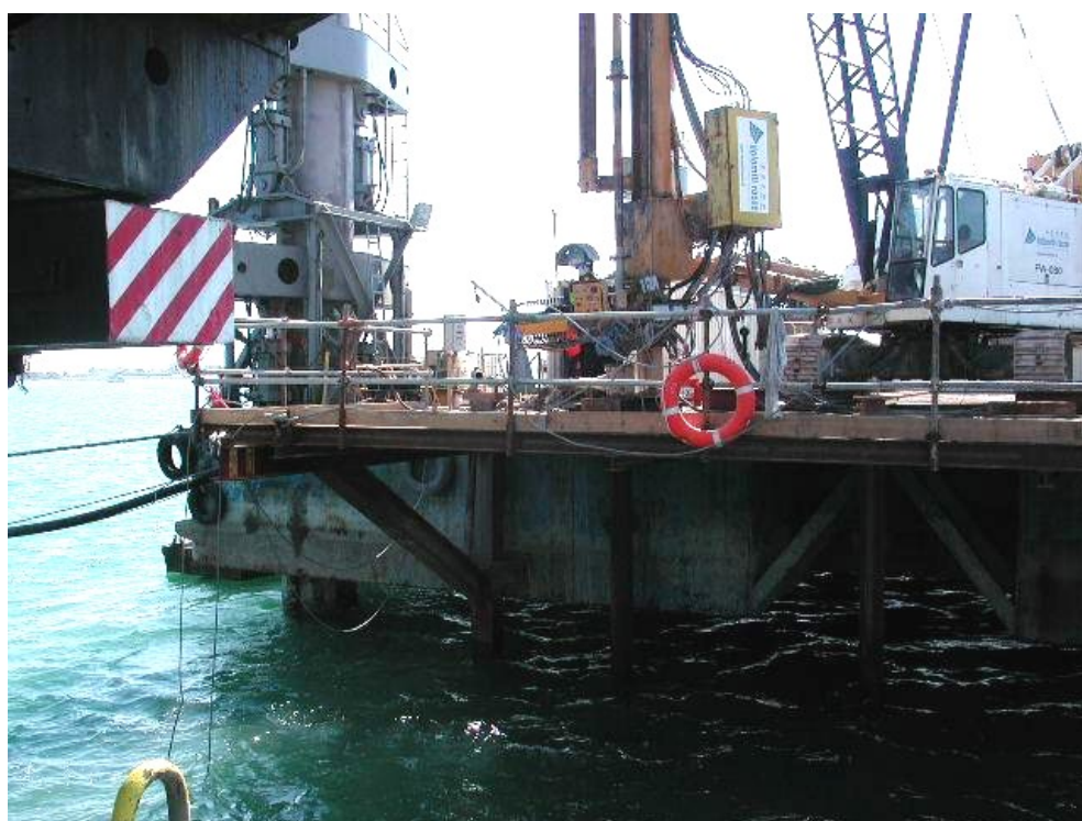
b) Sonda per gettiniezione in posizione sulla piattaforma autosollevante
