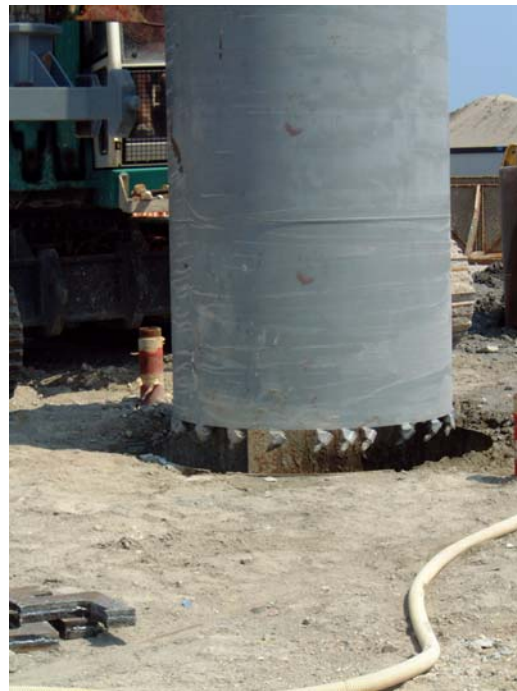
Inserimento del carotiere nel casing DN1800
