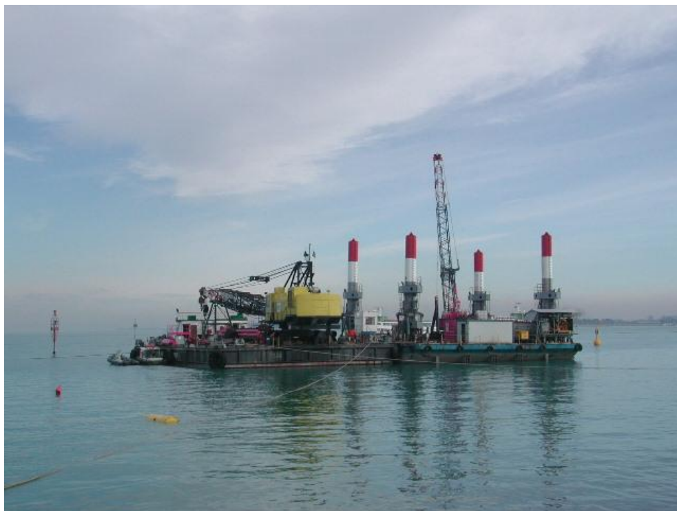
a) Piattaforma autosollevante e primo pontone ausiliario
