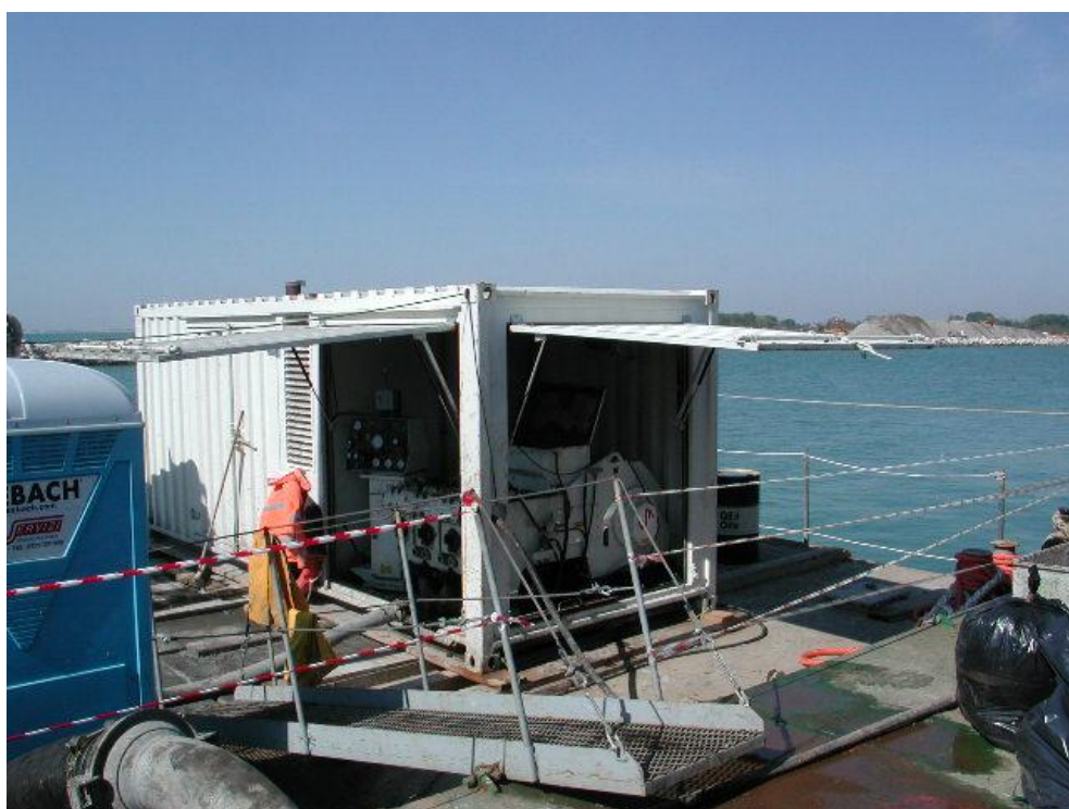
b) Pompa Metax alloggiata sul secondo pontone ausiliario per miscela
