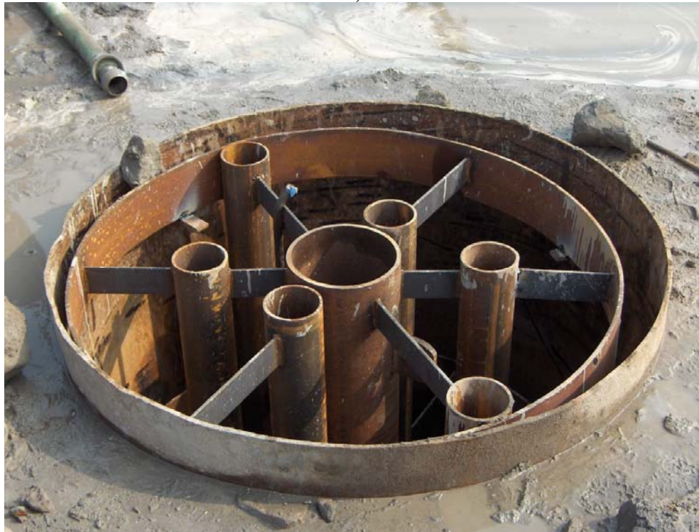
FIG. 7-6 - JET GROUTING – ESECUZIONE DELLE COLONNE A TERRA – A) DIMA PER POSIZIONARE IL MONITOR E CAROTAGGI – B) DIMA POSTA NEL RIVESTIMENTO
