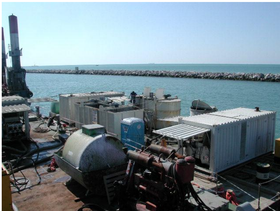
a) Secondo pontone ausiliario per l'alloggiamento delle pompe per miscela e mescolatori provvisori
