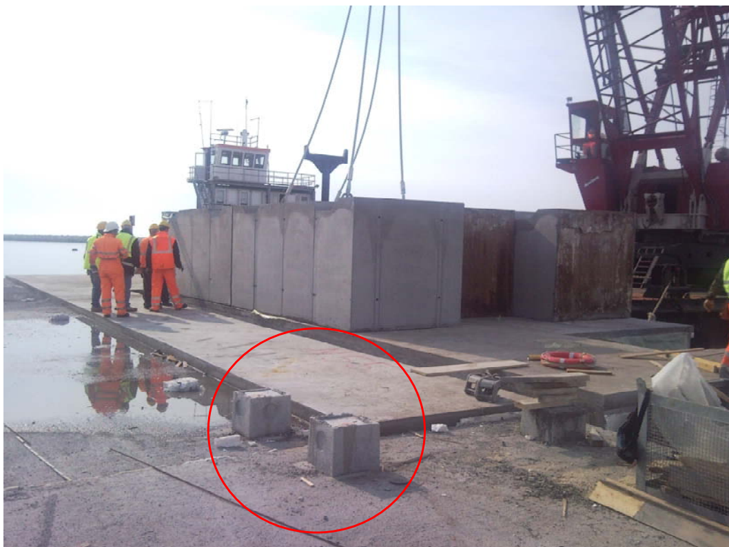
CAPOSALDI INSTALLATI SU POZZETTI PER IL MONITORAGGIO DEGLI SPOSTAMENTI DEI CASSONI
