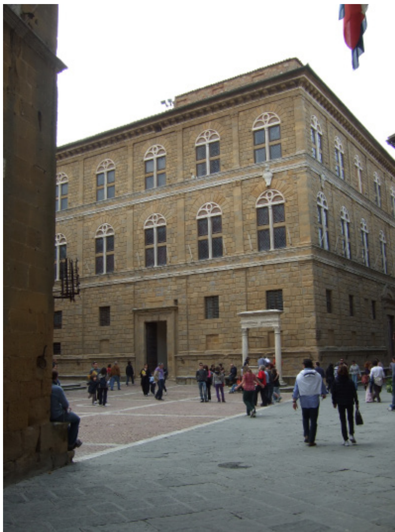
Figura 2.38: Vista del palazzo Piccolomini nella Piazza Pio II a Pienza, progetto di Bernardo Rossellino, XV secolo.
