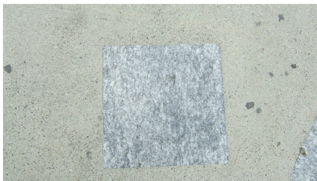
Figura 2.88: Particolare della pavimentazione in materiali lapidei e cemento della Piazza del Sole.
