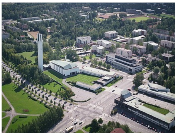
Figura 1.17: Veduta area del complesso polifunzionale di Seinajoki, Finlandia, progetto di Alvar Aalto, 1965.
