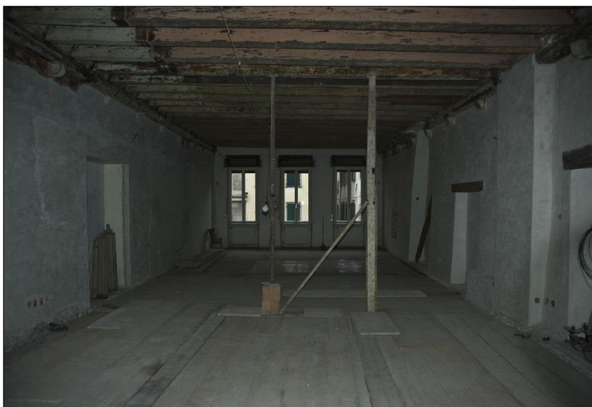
Fig. 4. Casa Vanni degli Onesti in via Mercatovecchio, interno del piano I (foto di Mirco Cusin).
