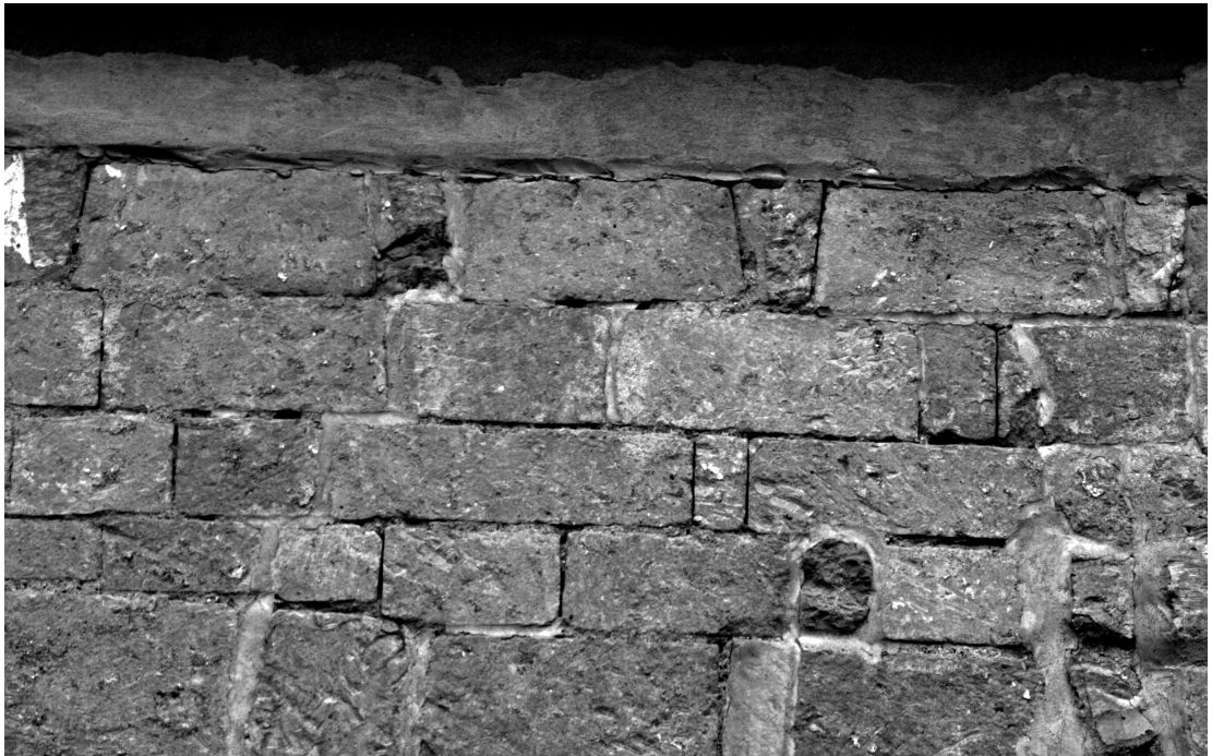
Fossano, Santa Maria, fianco settentrionale (in alto) e particolare dei peducci scalpellati dell'originario sistema di archetti pensili del culmine del fianco (in basso)
