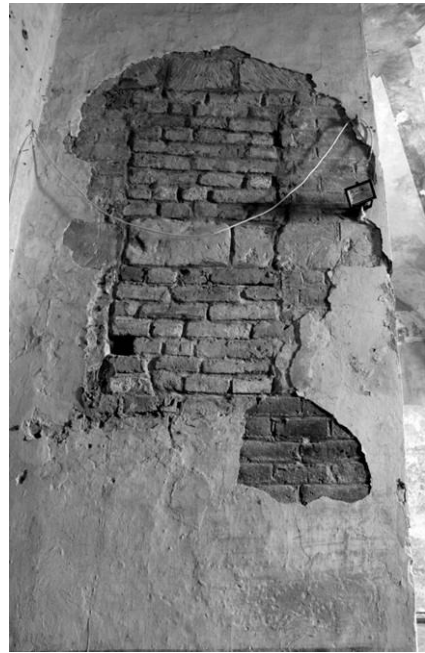
A sinistra: particolare della muratura della torre nell'intradosso della volta A destra: accesso tamponato alla torre nel fianco sud della stessa
