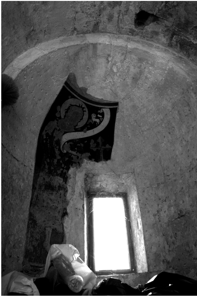
Campanile, vano absidato al piano terreno, catino absidale (a sinistra) e volta a botte (in basso)
