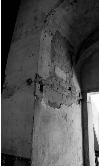
A sinistra: particolare della muratura della torre nell'intradosso della volta A destra: accesso tamponato alla torre nel fianco sud della stessa
