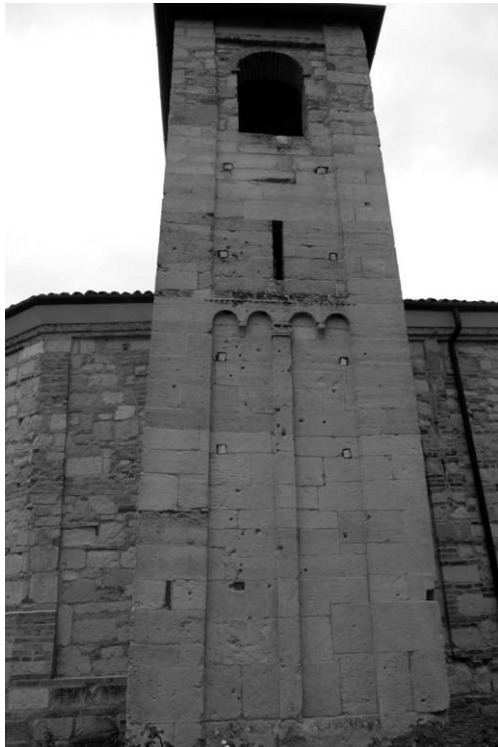
Olivola, San Pietro, campanile, fianco ovest (a sinistra), fianco sud (a destra), particolare della doppia coppia di archetti pensili del fianco ovest (in basso)
