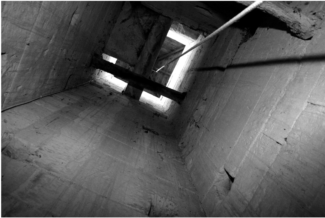
Interno del fusto del campanile
