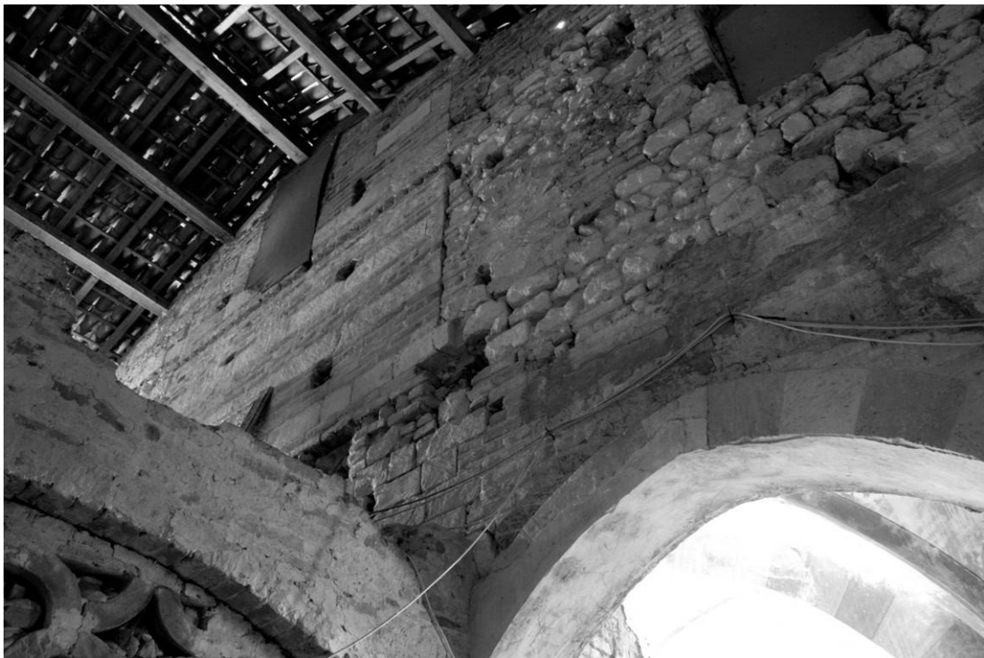
Fianco ovest della torre e facciata antecedente l'attuale
