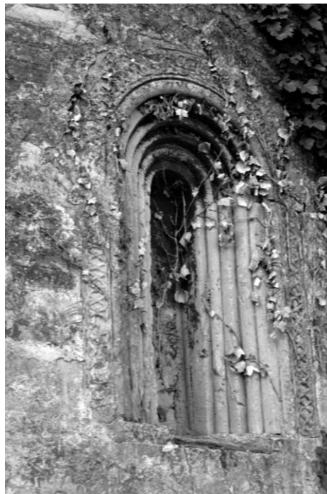
Occimiano, San Vitale, particolare della monofora tamponata della specchiatura centrale dell' abside (a sinistra) e monofora della specchiatura settentrionale (a destra)
