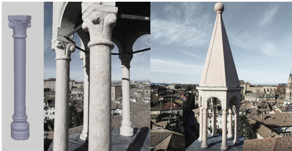
Figura 27 A sinistra ricostruzione digitale di una delle colonnine del pinnacolo nord-ovest del Battistero di San Giovanni Battista a Parma. Al centro e a destra il pinnacolo dopo i restauri.
