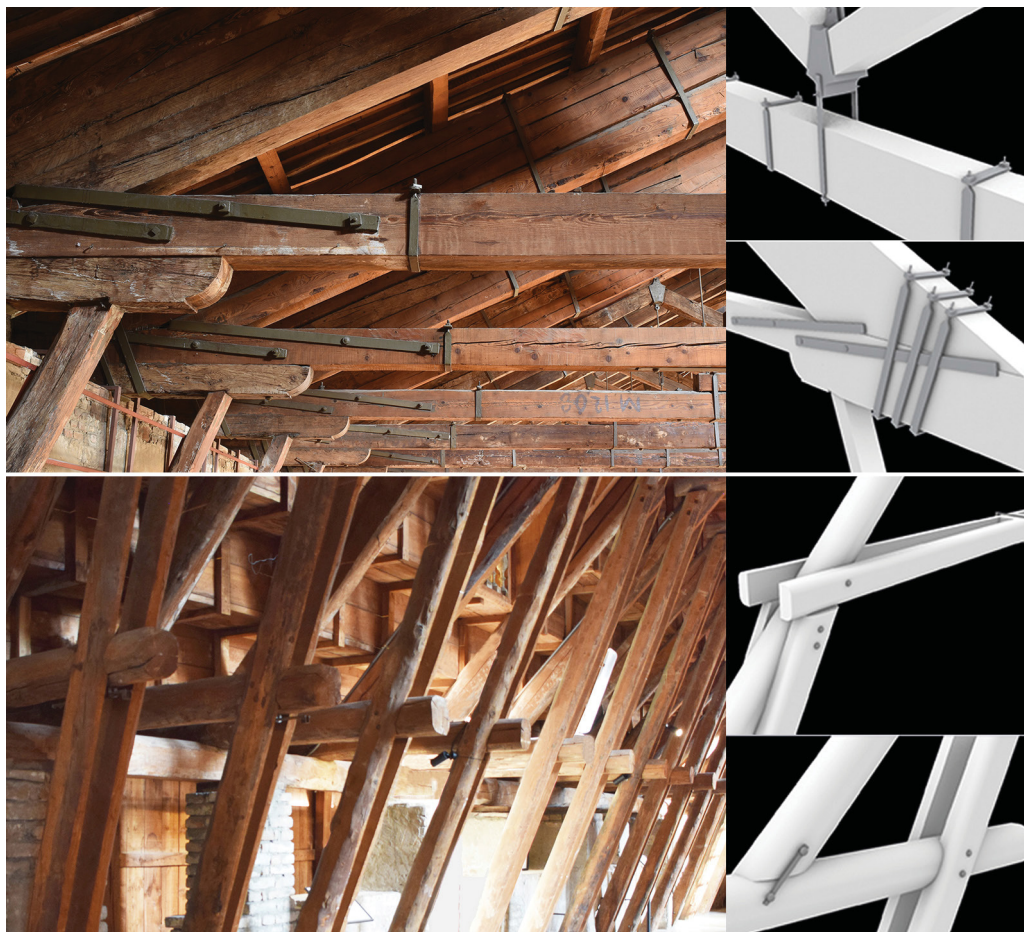
Figura 137 In alto il sistema di copertura del teatro (ricostruzione digitale e immagine fotografica). In basso il sistema strutturale di sostegno delle gradinate (ricostruzione digitale e immagine fotografica).
