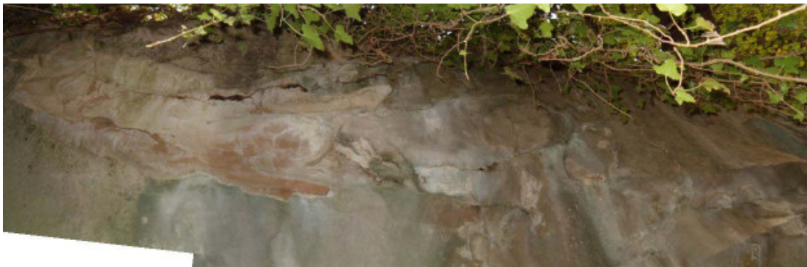
Figura 3.17. Visione panoramica della volta dell'imbocco secondario a N del pilastro n. 73.
