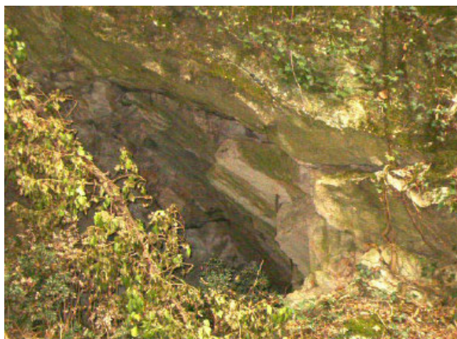
Figura 3.14. Blocchi instabili ribaltati presso il ponte in roccia.
