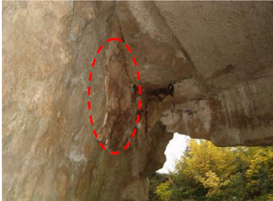
Figura 3.7. lastra sottile presso la parete di cava a W del pilastro 6; da tale parete si è probabilmente staccato il grosso masso adagiato sulla superficie di calpestio;
