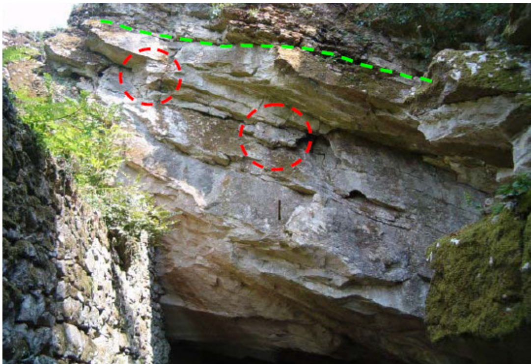
Figura 3.18. Vista panoramica frontale della parete sopra l'imbocco principale.
