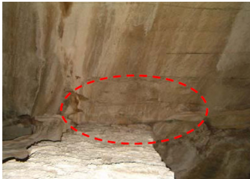
Figura 3.8. Area con più lastre a S del pilastro 3; la superficie media delle lastre è pari a circa 9000 cmq.
