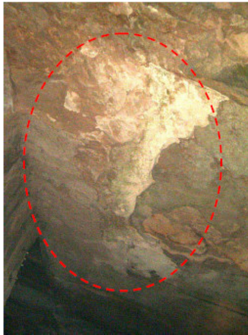
Figura 3.4. Area di circa 3 mq in cui è ben riconoscibile una lastra sottile a S del pilastro 69.
