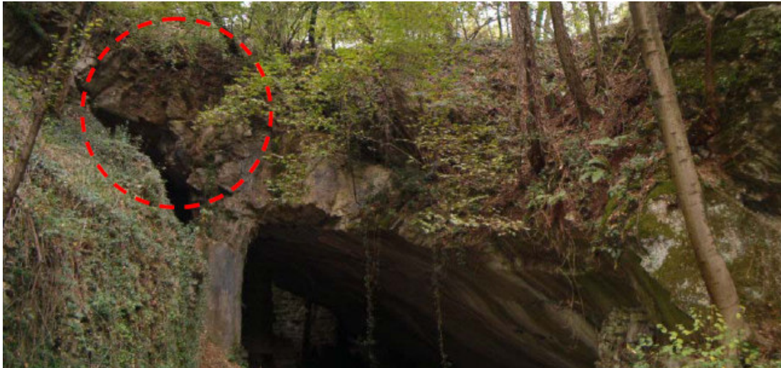
Figura 3.10. Vista d'insieme della zona di imbocco intermedia.
