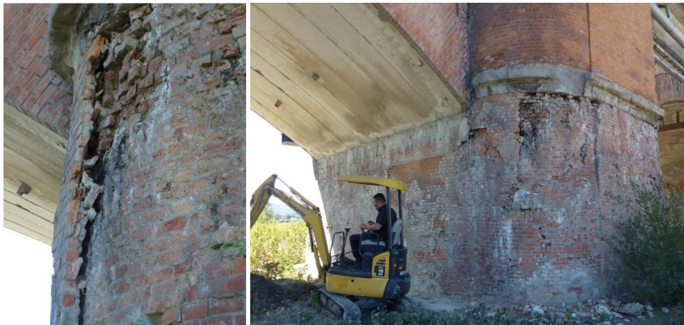
Figura 258 Pila spalla N°16 e dettaglio del rivestimento.
