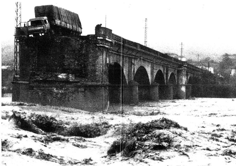
Figura 56 Il ponte subito dopo il crollo durante la piena del 1982.
