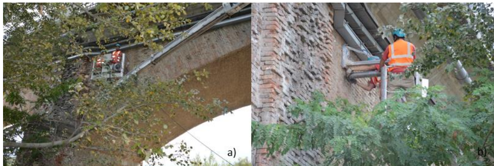
Figura 96 a), b) posizione ed esecuzione del foro N°9.
