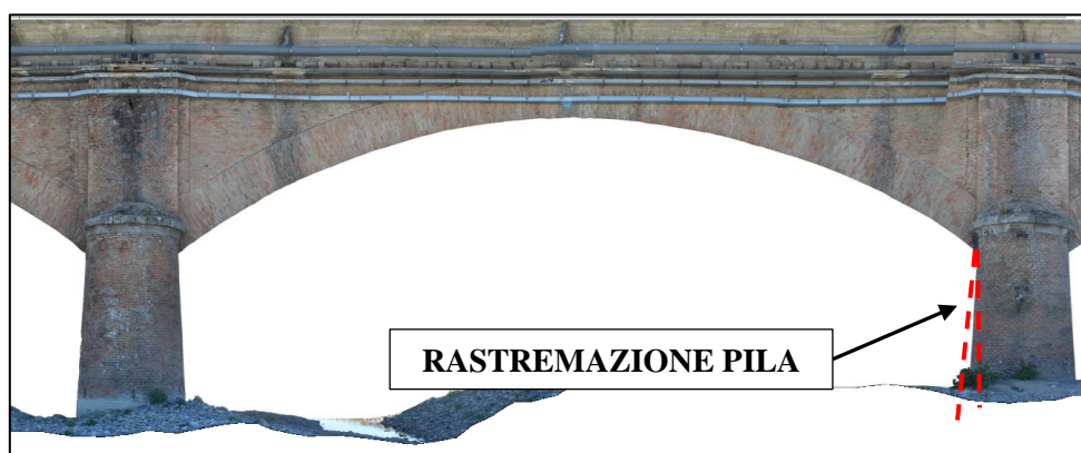
Figura 189 Sezione rastremata della pila, vista lato valle.
