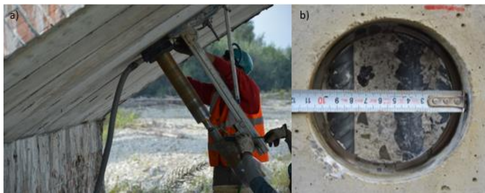
Figura 95 a) esecuzione del foro; b) barre di armatura.
