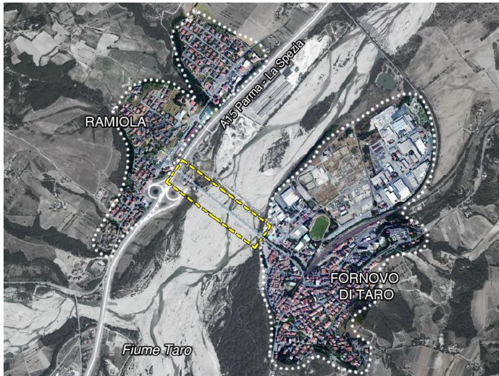
Figura 52 Vista aerea con indicazione del ponte oggetto di intervento.
