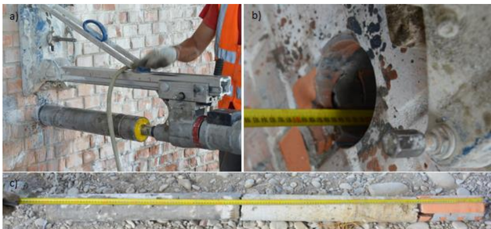
Figura 81 a) esecuzione del foro N°13C; b) foro N°13C; c) carota N°13C.
