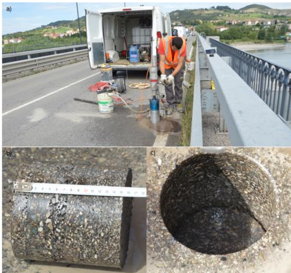
Figura 68 a) esecuzione del foro N°1 (diametro 150 mm); b) usura e binder del pacchetto stradale; c) foto del foro N°1.
