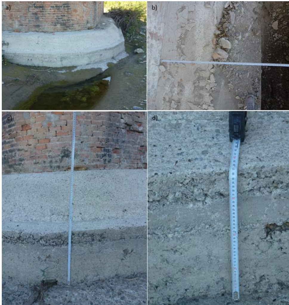
Figura 109 a) rostro di fondazione; b), c), d) misurazioni del rostro.
