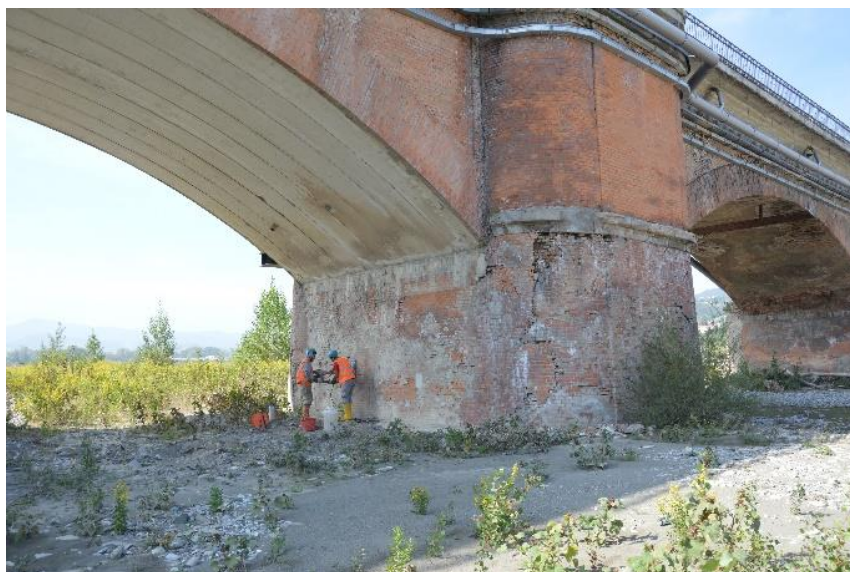
Figura 87 Pila spalla nella zona archi in c.a.
