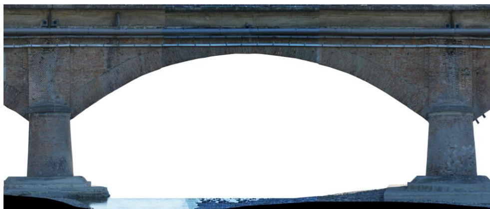
Figura 247 Vista lato valle campata N°15: rostri della pila N°14 e N°15.
