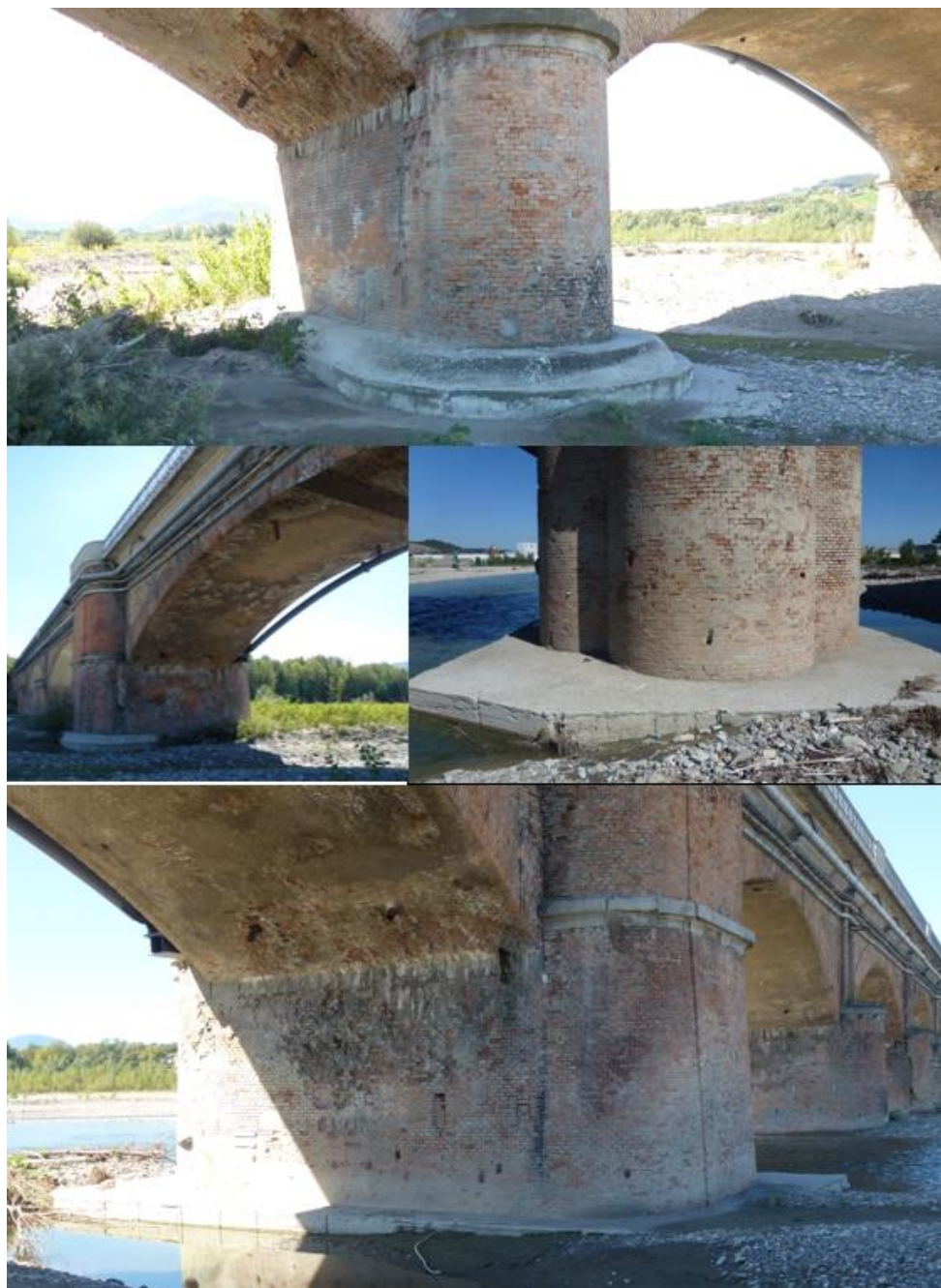
Figura 110 Rostrì delle pile dalla N°12 alla N°15.
