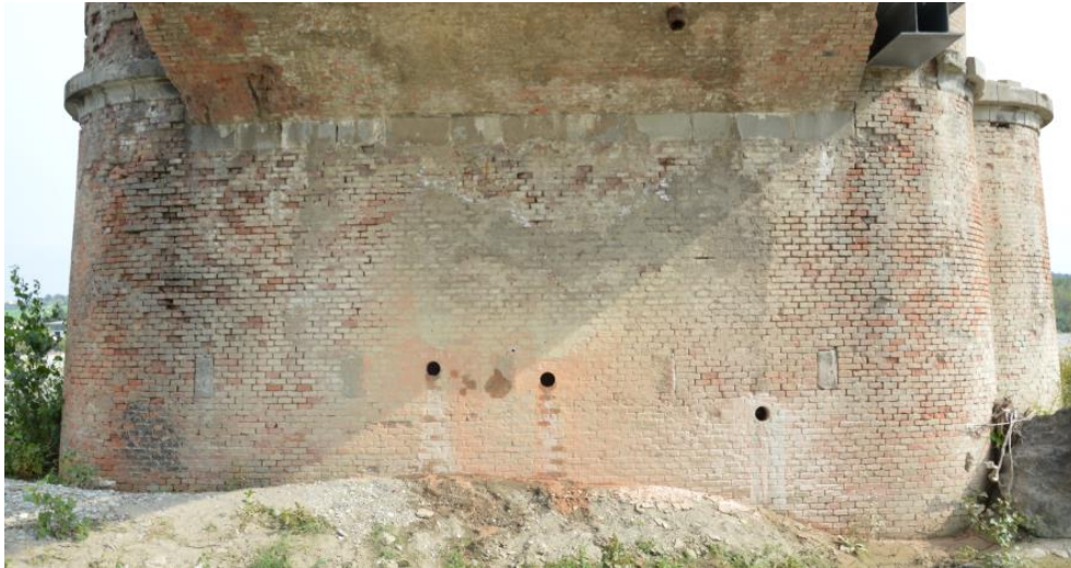
Figura 82 Posizione dei fori N°15A, N°15B e N°15C.
