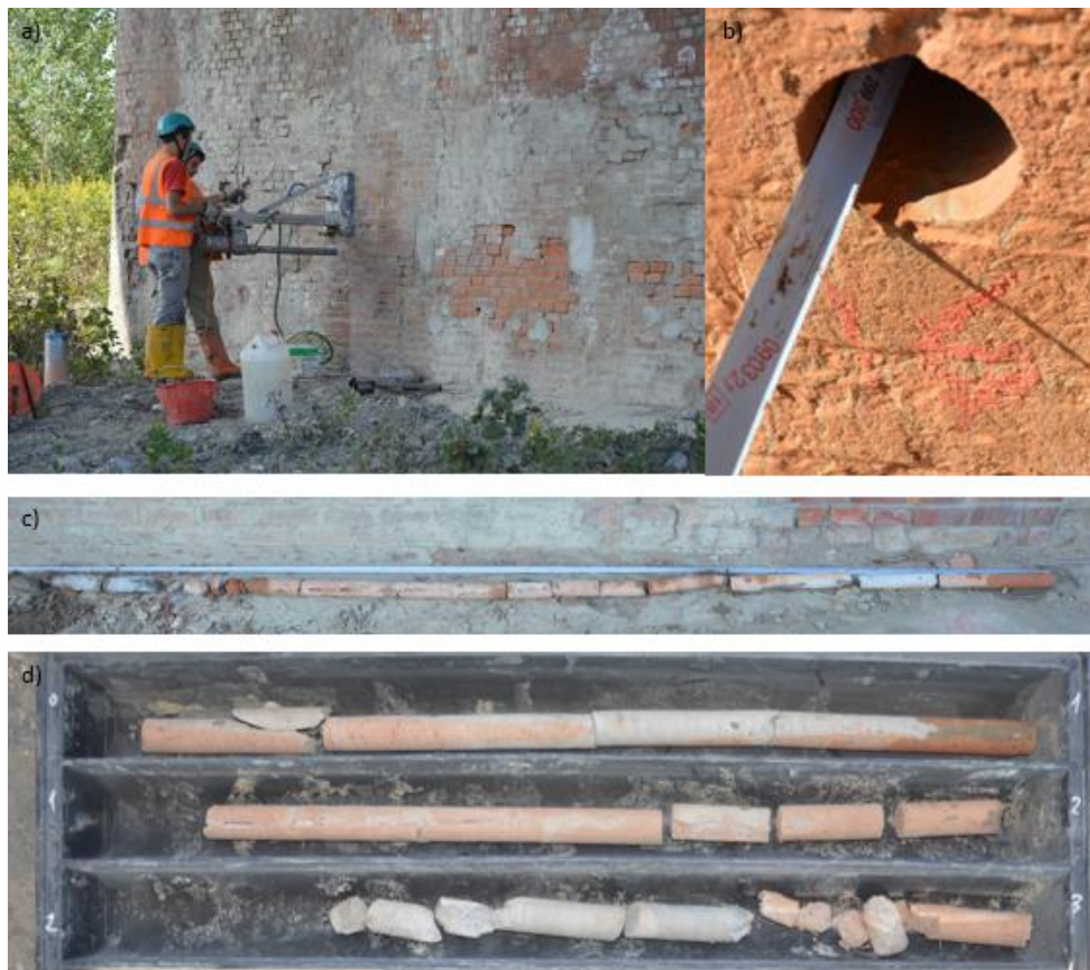
Figura 90 a) esecuzione del foro N°16; b) foro N°16; c), d) carota N°16.
