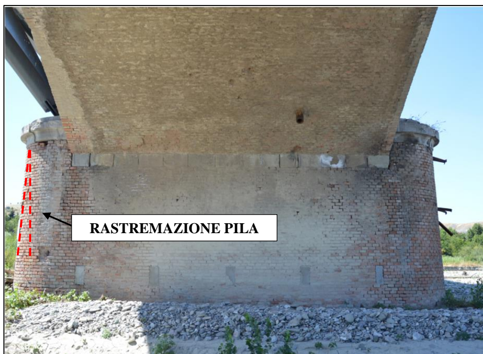
Figura 188 Sezione rastremata della pila da rilievo fotografico.
