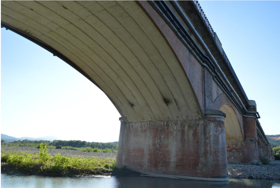
Figura 58 Rifacimento in cemento armato della volta dopo la piena del 1982.
