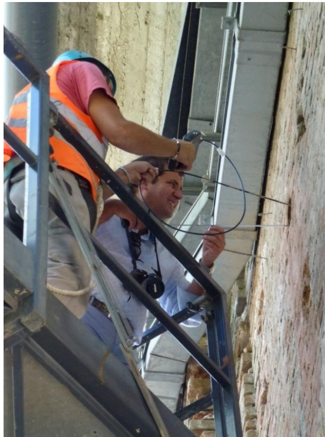
Figura 100 Ispezione con videoendoscopio in corrispondenza del timpano nel foro N°9.
