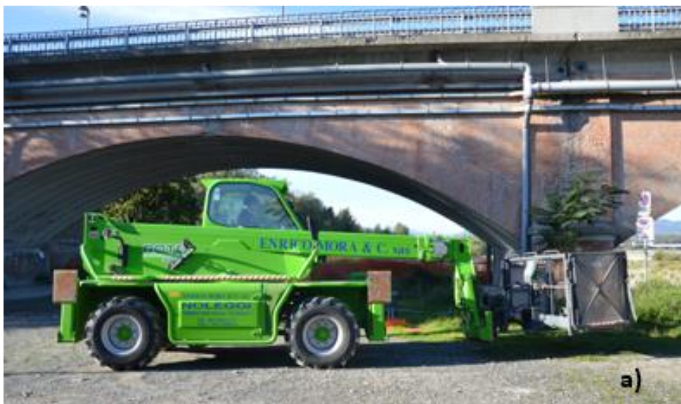
Figura 67 Piattaforma aerea utilizzata per l'esecuzione dei carotaggi.
