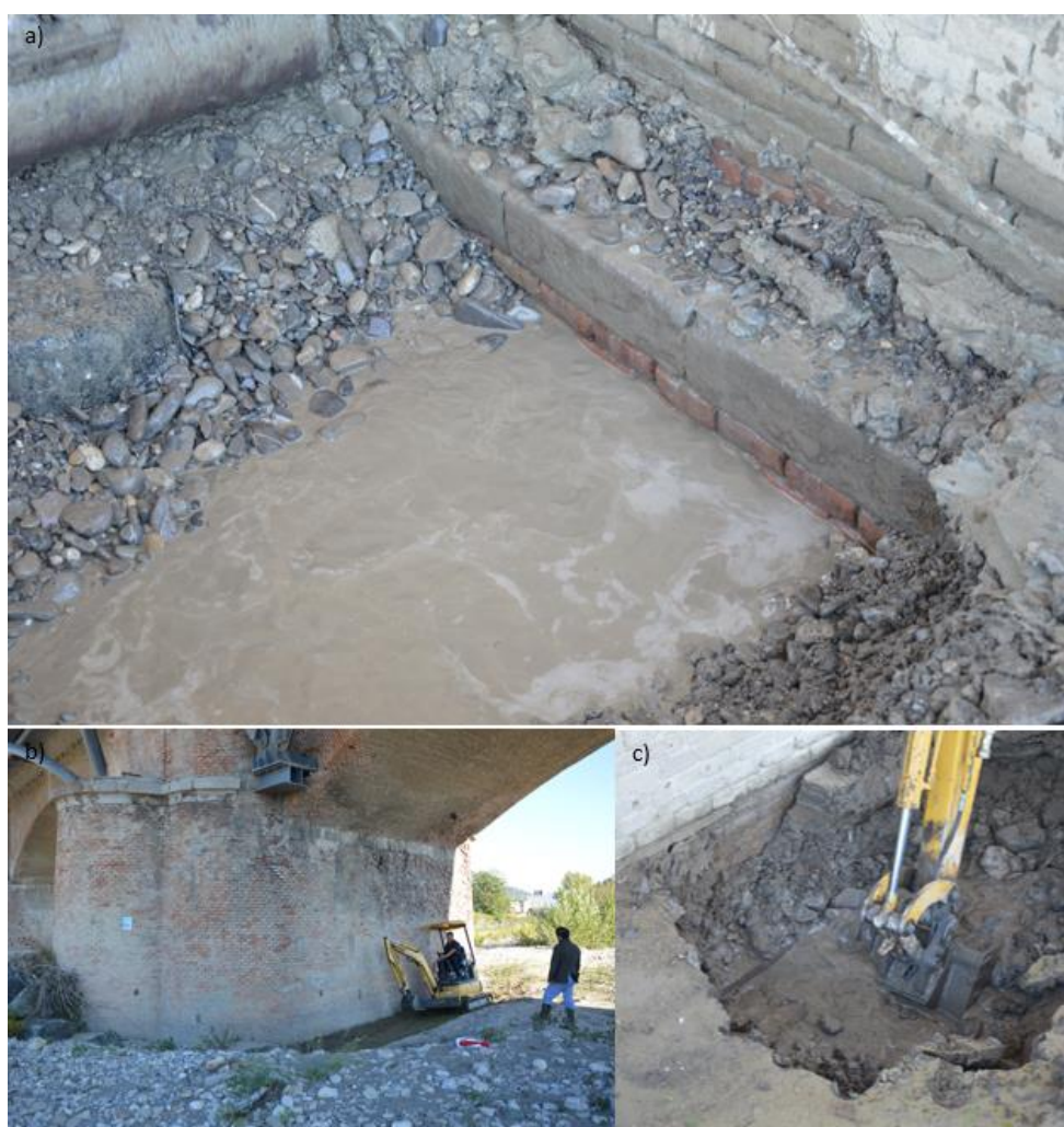
Figura 106 a) ispezione pila; b), c) ispezione pila spalla.
