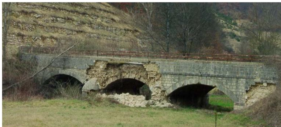
Figura 194 Meccanismo di ribaltamento locale fuori piano del timpano.
