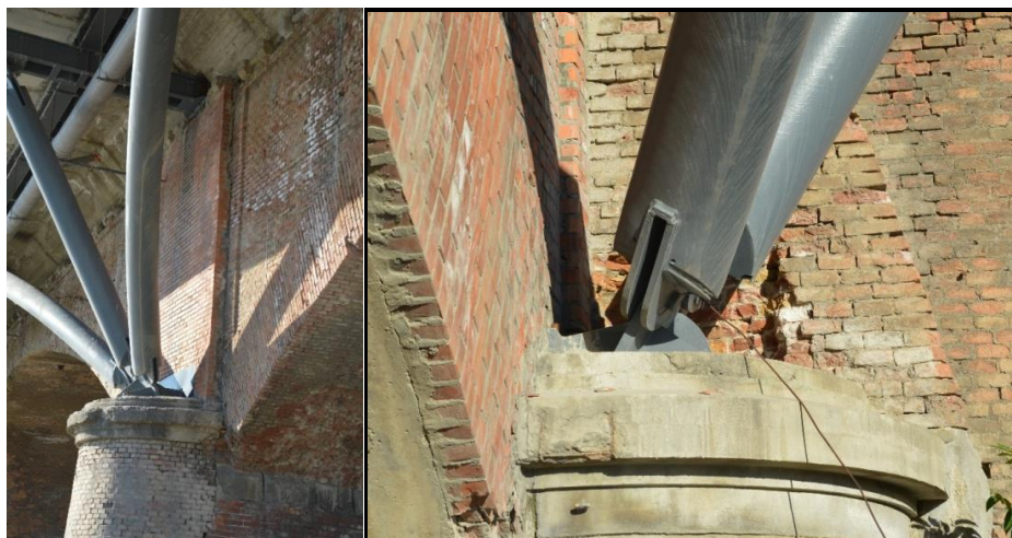
Figura 238 Zona di concentrazione degli sforzi: Innesco sezioni tubolari della pista ciclabile con le pile del ponte.
