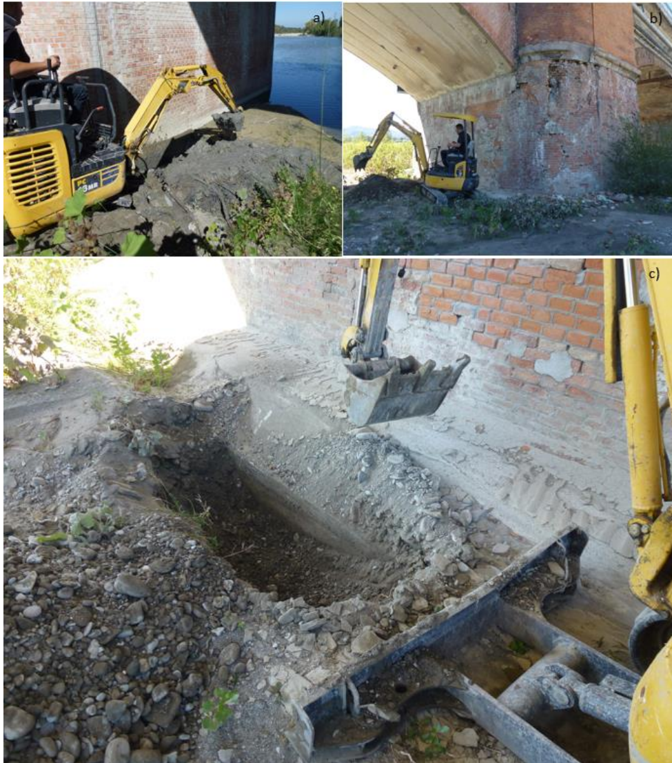
Figura 108 a) ispezione pila-zona archi in c.a.; b), c) ispezione pila spalla-zona archi in c.a..
