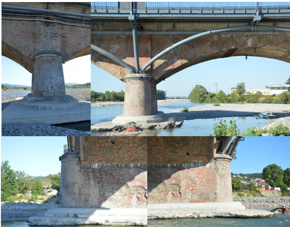
Figura 254 Rostro di fondazione delle pile di nuova costruzione.
