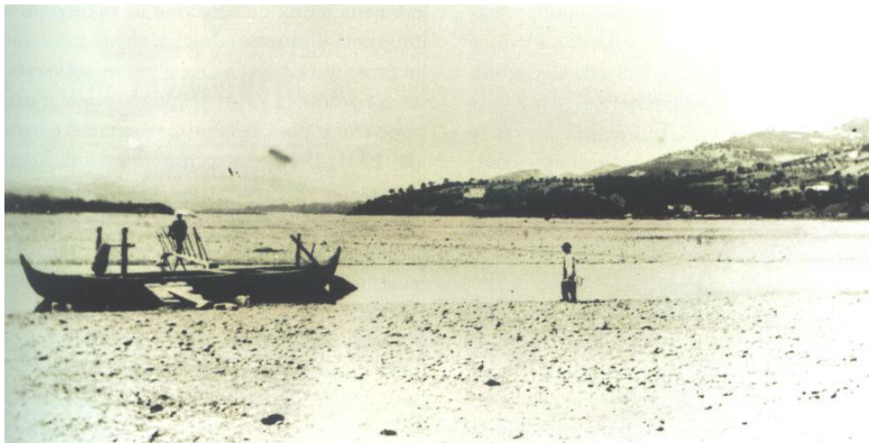
Figura 53 Foto d'epoca prima della costruzione del ponte.
