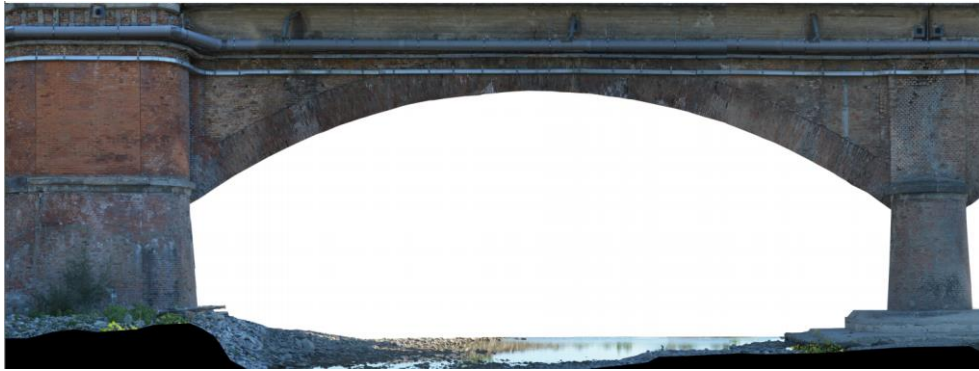
Figura 248 Vista lato valle campata N°16: rostri della pila N°15 e N°16.
