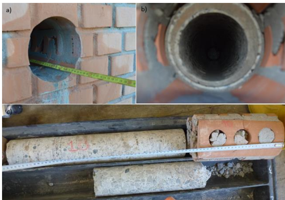
Figura 99 a) foro N°10; b) dettaglio del foro N°10; c) carota N°10.
