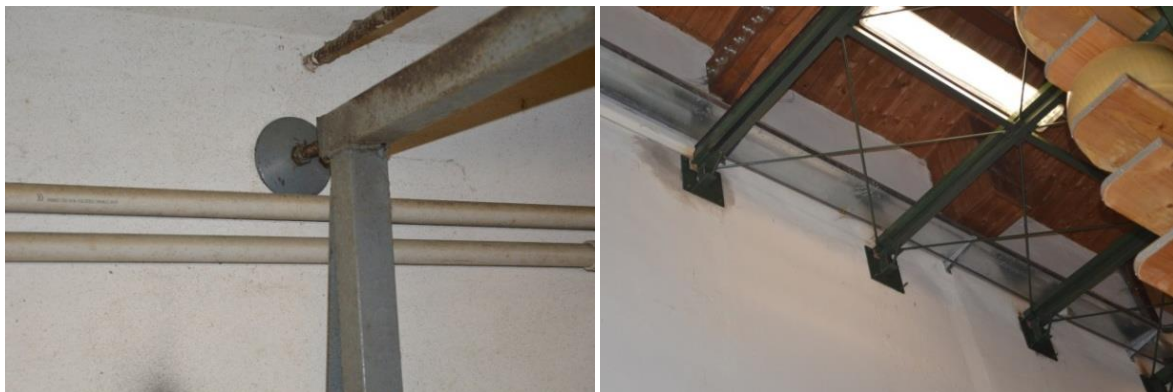
Figura 4 Sistema di ancoraggio alle pareti del magazzino.
