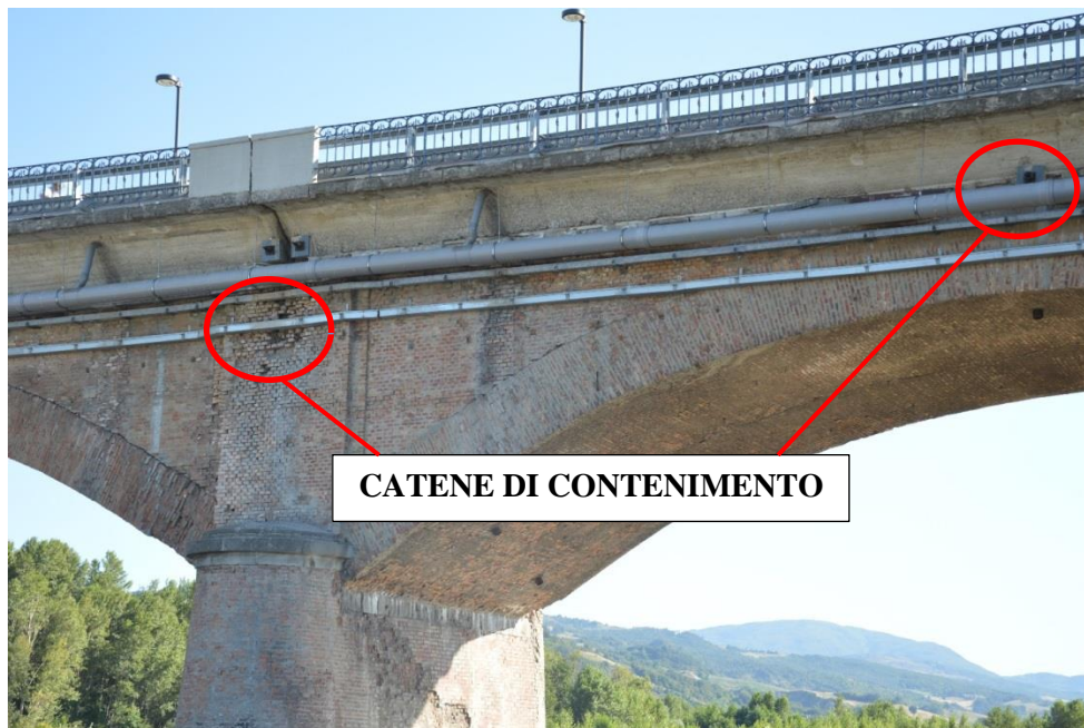
Figura 201 Catene di contenimento del timpano.
