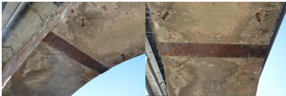
Figura 257 Piastra metallica nell'intradosso della volta-arcata N°16
