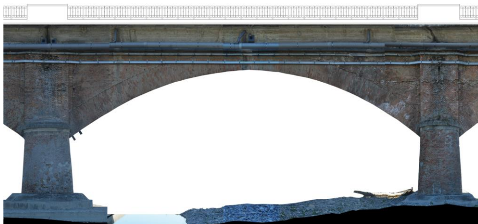
Figura 246 Vista lato valle campata N°14: rostri della pila N°13 e N°14.
