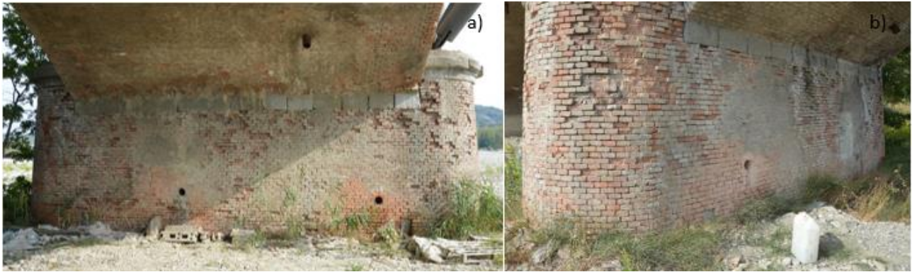
Figura 75 a) posizione dei fori N°12A e N°12B pila N°2 (lato arcata N°2); b) posizione del foro N°12C pila N°2 (lato arcata N°3).
