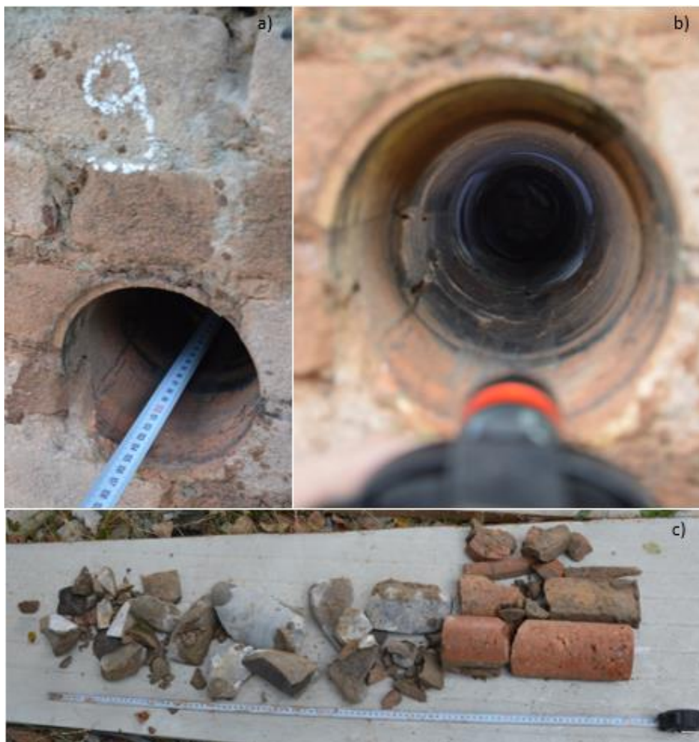
Figura 97 a) foro N°9; b) dettaglio del foro N°9; c) carota N°9.
