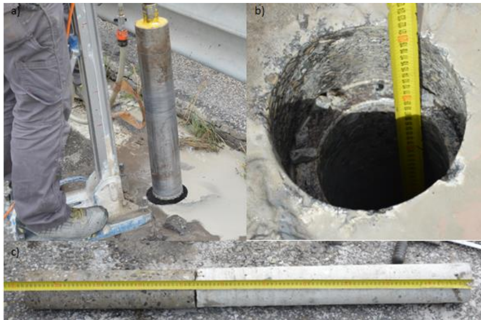
Figura 73 a) esecuzione del foro; b) foro N°4; c) carota N°4.
