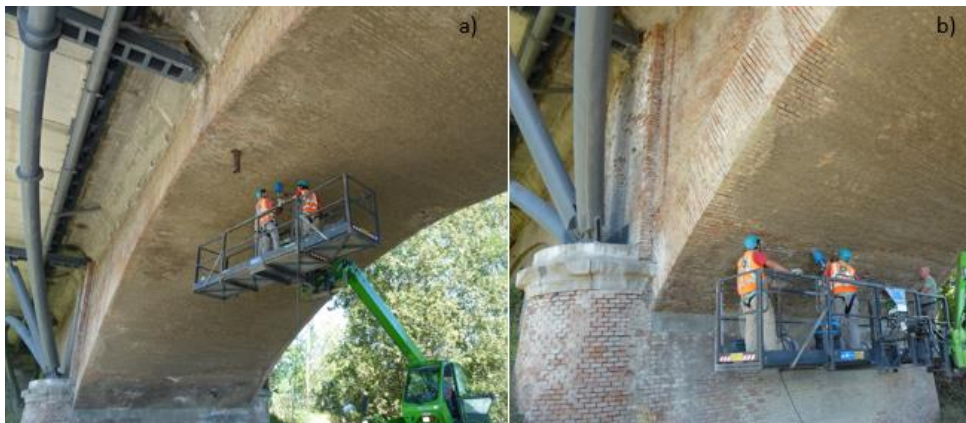
Figura 91 Posizione dei fori nell'arcata N°2: a) sezione di chiave; b) sezione di imposta.
