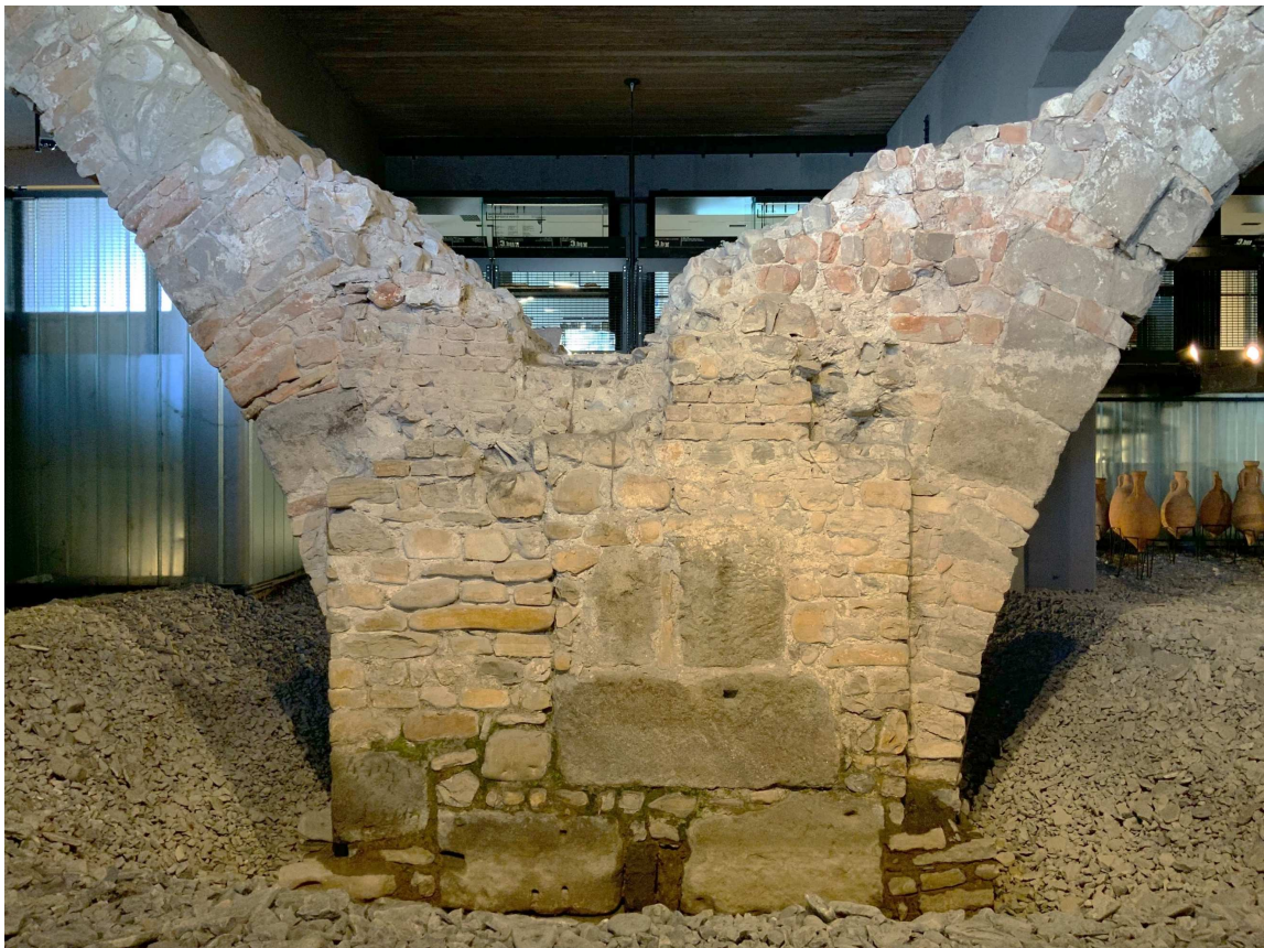
Fig. 48 – Strutture del ponte antico. In alto rostro della prima arcata (ora sommersa – foto SABAP), in basso tessitura muraria e reimpieghi nelle arcate esposte (foto SABAP).
