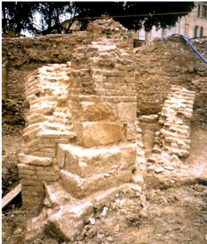
Fig. 11 – Uno dei piloni rostrati superstiti del ponte antico di Fidenza (Catarsi 1997).
