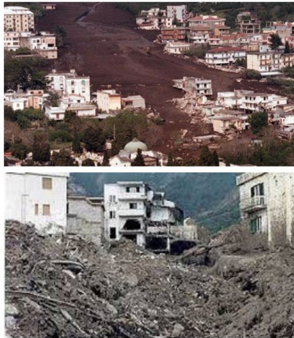
Figura 1.2-3: Soil slip tra il 5 e il 6 maggio del 1998 a Sarno (Napoli)
