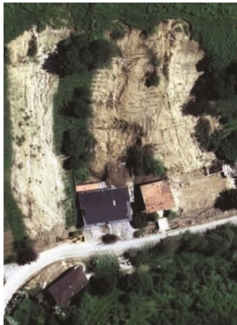
Figura 1.2-6 - Case gravemente danneggiate dalle frane sviluppatesi nel versante retrostante Via Recoaro a Broni: vi fu anche una vittima.
