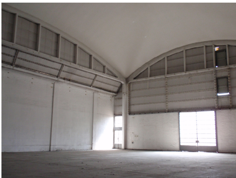
Fig 5.14. – Stato di fatto dell'interno del padiglione Nervi.
