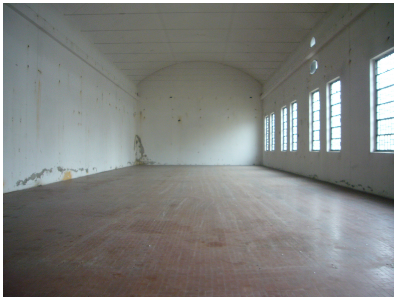
Fig.5.13. – Stato di fatto dell'interno dell'edificio ovest del comparto F.
