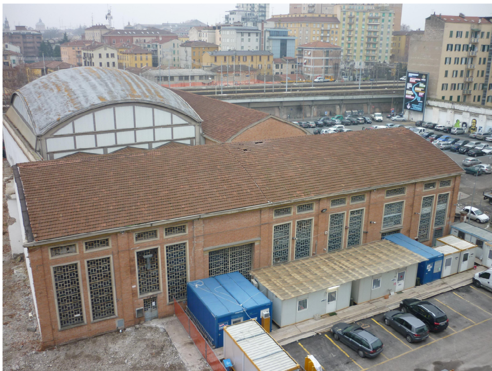
Fig. 5.5 - Stato di fatto della Casa della Cultura.
