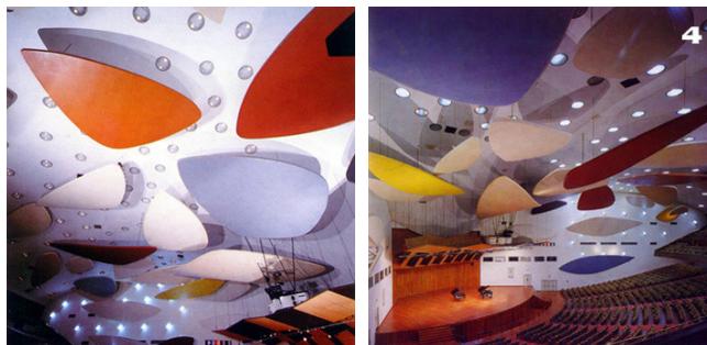
Fig. 6.12 – Particolari pannelli controsoffitto del Aula Magna, University of Caracas.
