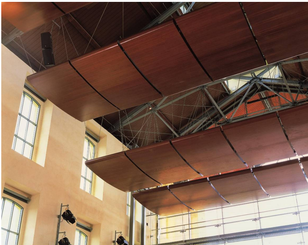
Figura 6.4 – Pannelli diffondenti sospesi.
