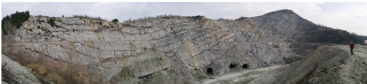
Figura 27 – Cava di Monte Tondo(Riolo Terme, RA). Veduta panoramica del fronte di cava.
