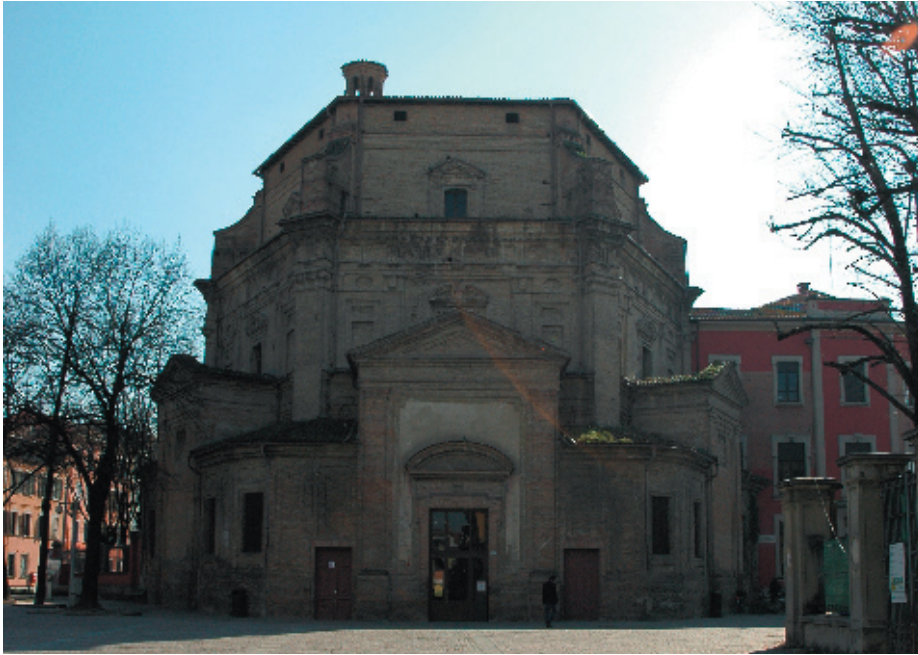
Facciata principale della Chiesa di Santa Maria del Quartiere in Parma.
