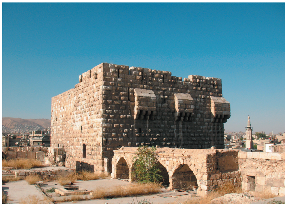
Vista lati sud-ovest della Torre 8, Cittadella di Damasco, Siria.
