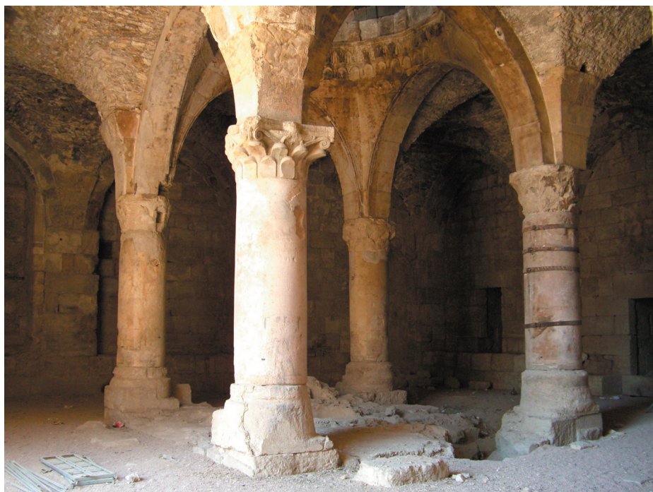
Le quattro colonne che sostengono la copertura voltata della Ayyubd Hall all'interno della Cittadella di Damasco, Siria.
