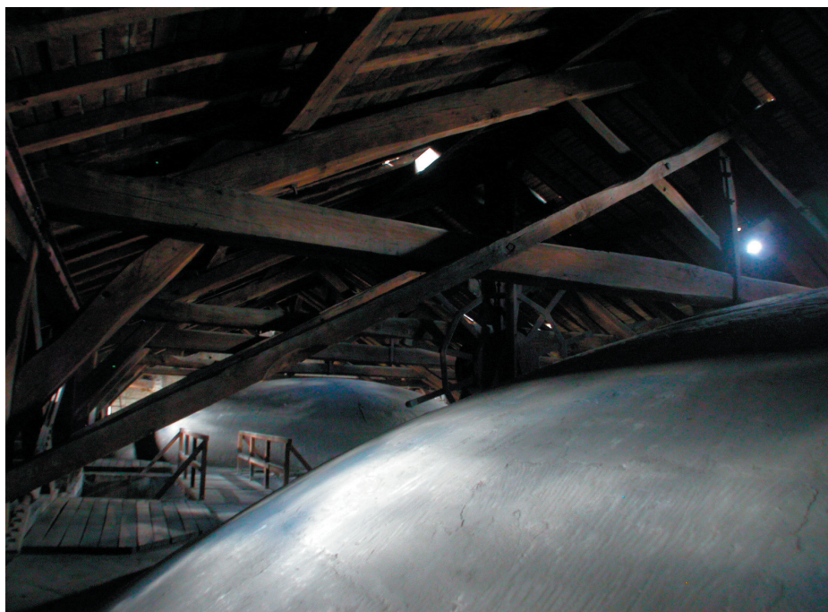
L'estradosso delle volte di copertura della navata centrale e le strutture lignee di copertura della chiesa di Sainte-Geneviève (Pantheon) a Parigi.
