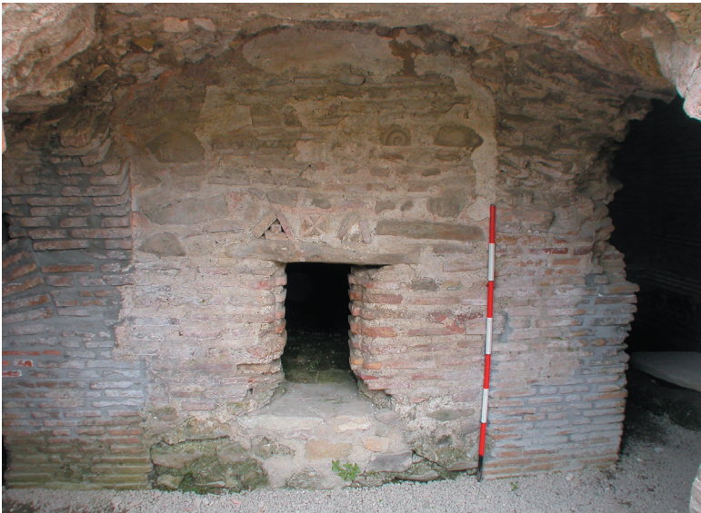
L'ossario realizzato chiudendo parte di un fornice e datato al XIII sec., è collocabile nella terza fase di interventi antichi.
