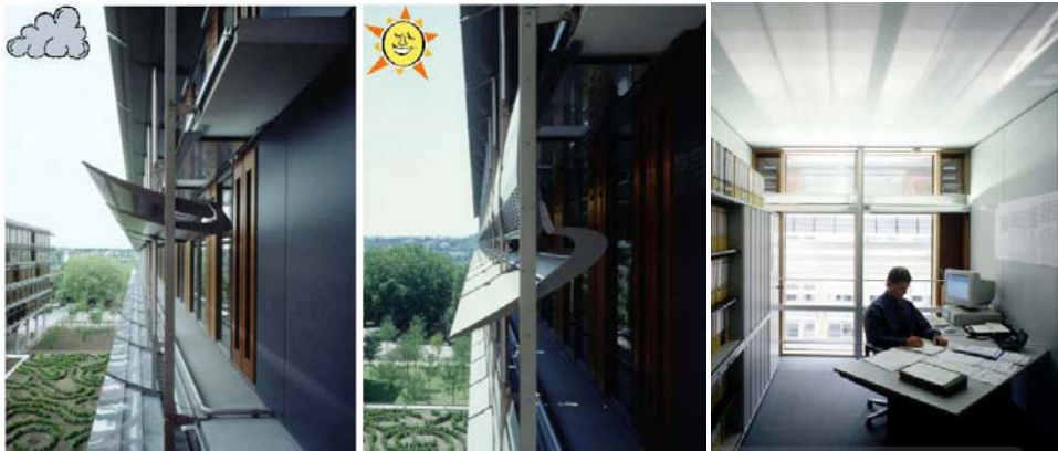
Figura 22: Herzog + Partner, ZVK Verwaltungsgebäude, Wiesbaden, esempio di light-guiding shade che si adatta alle condizioni meteo esterne.
