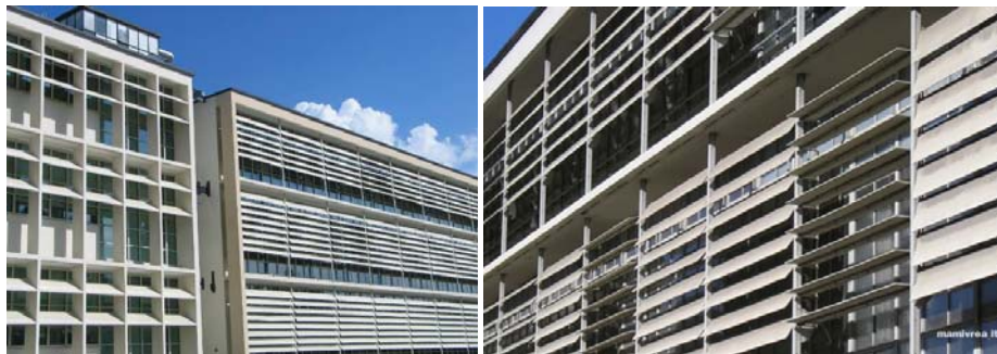
Figura 13: Figini e Pollini per gli stabilimento Olivetti, Ivrea. Esempi di applicazione di lightshelves esterni
