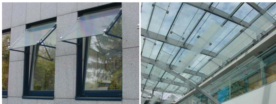
Figura 24: ADO Office, Cologne, esempio di lightguiding zenitale.
