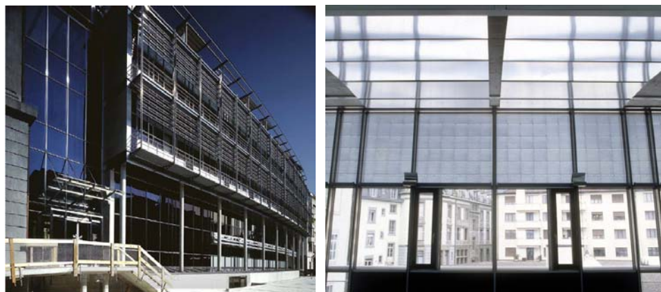
Figura 20: SBV building - Swiss Federation of the Blind and Visually Impaired -, Biel, Svizzera, esempio di impiego di pannelli prismatici mobili sulla facciata.
