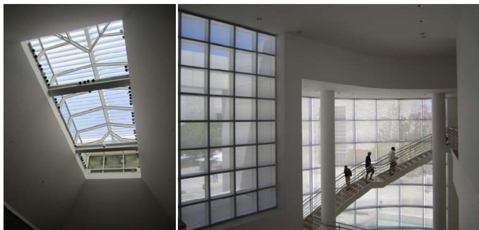
Figura 2: Soluzioni di toplighting e sidelighting realizzate per il Getty Center, Richard Meier, Los Angeles, 1970.
