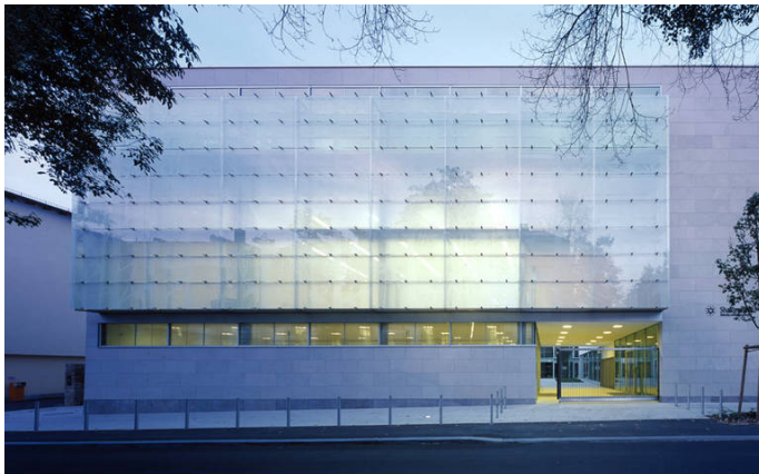
Figura 19: Grellmann Kriebel Teichmann, Shalom Europa Jewish Community and Culture Centre, Würzburg, esempio di impiego del sistema Okasolar.
