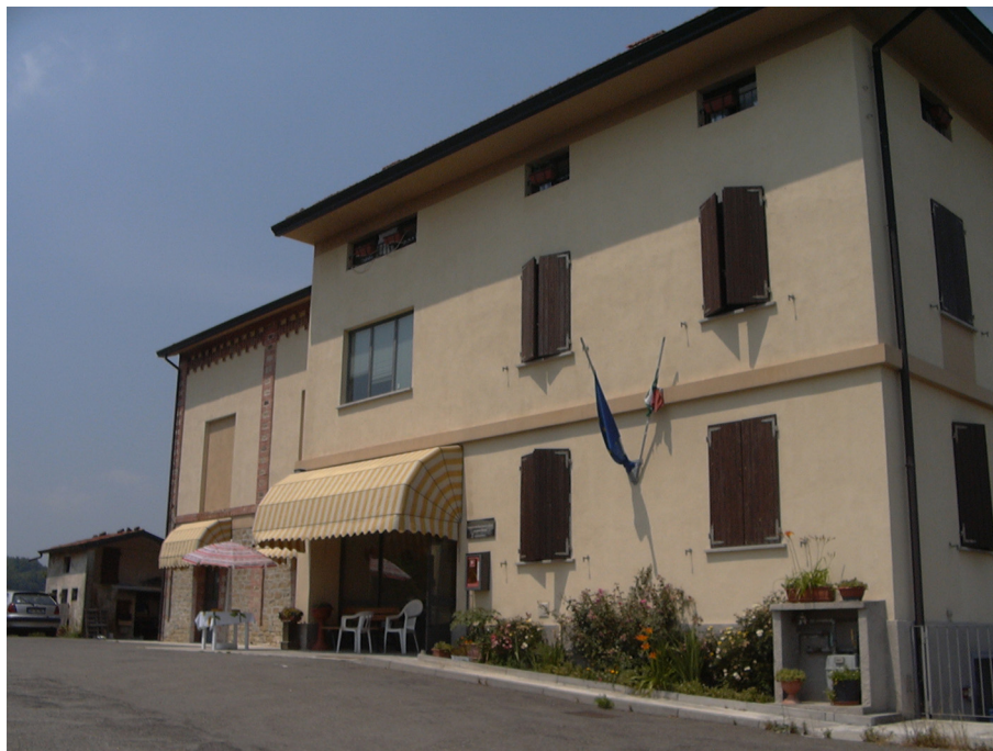
Figura 8.1: Foto della struttura oggetto del test.
