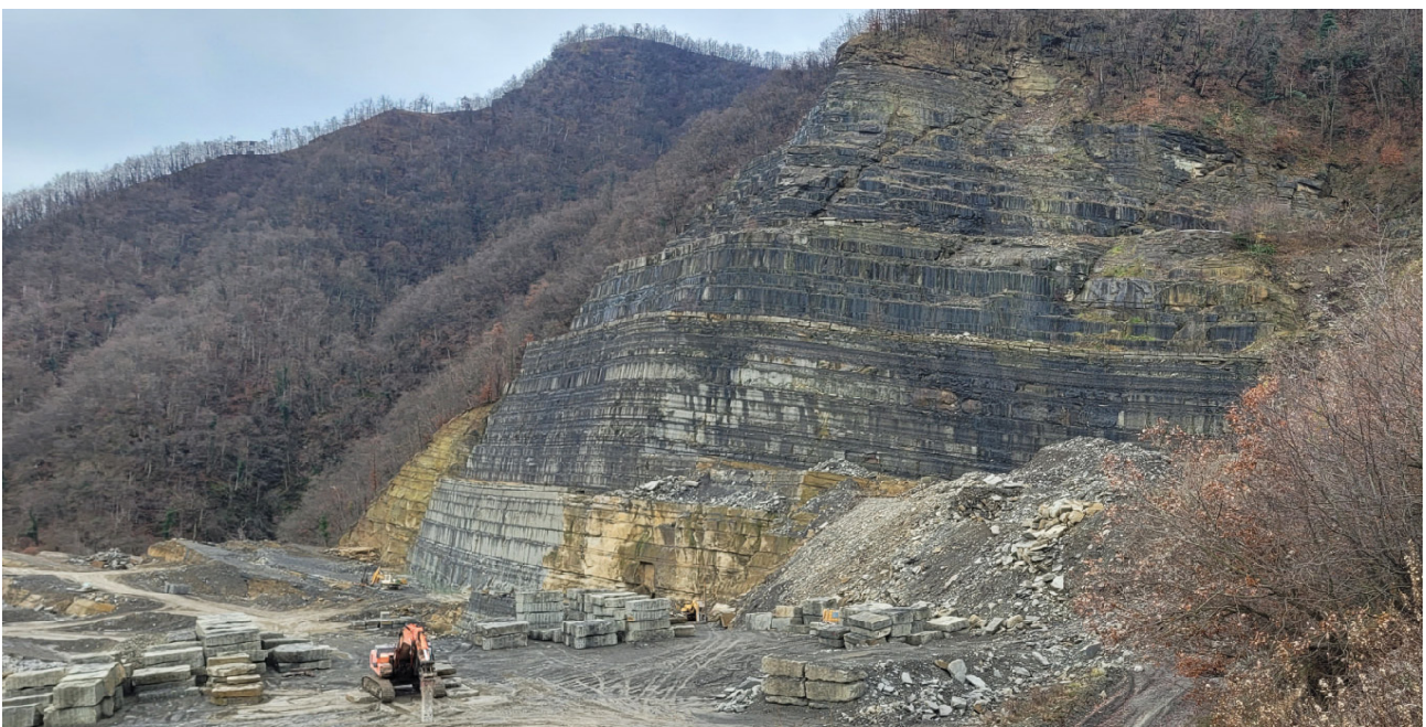
Figura 6.2.34: Parete ovest dalla cava Castellina, dove è stata misurata la sezione A11
