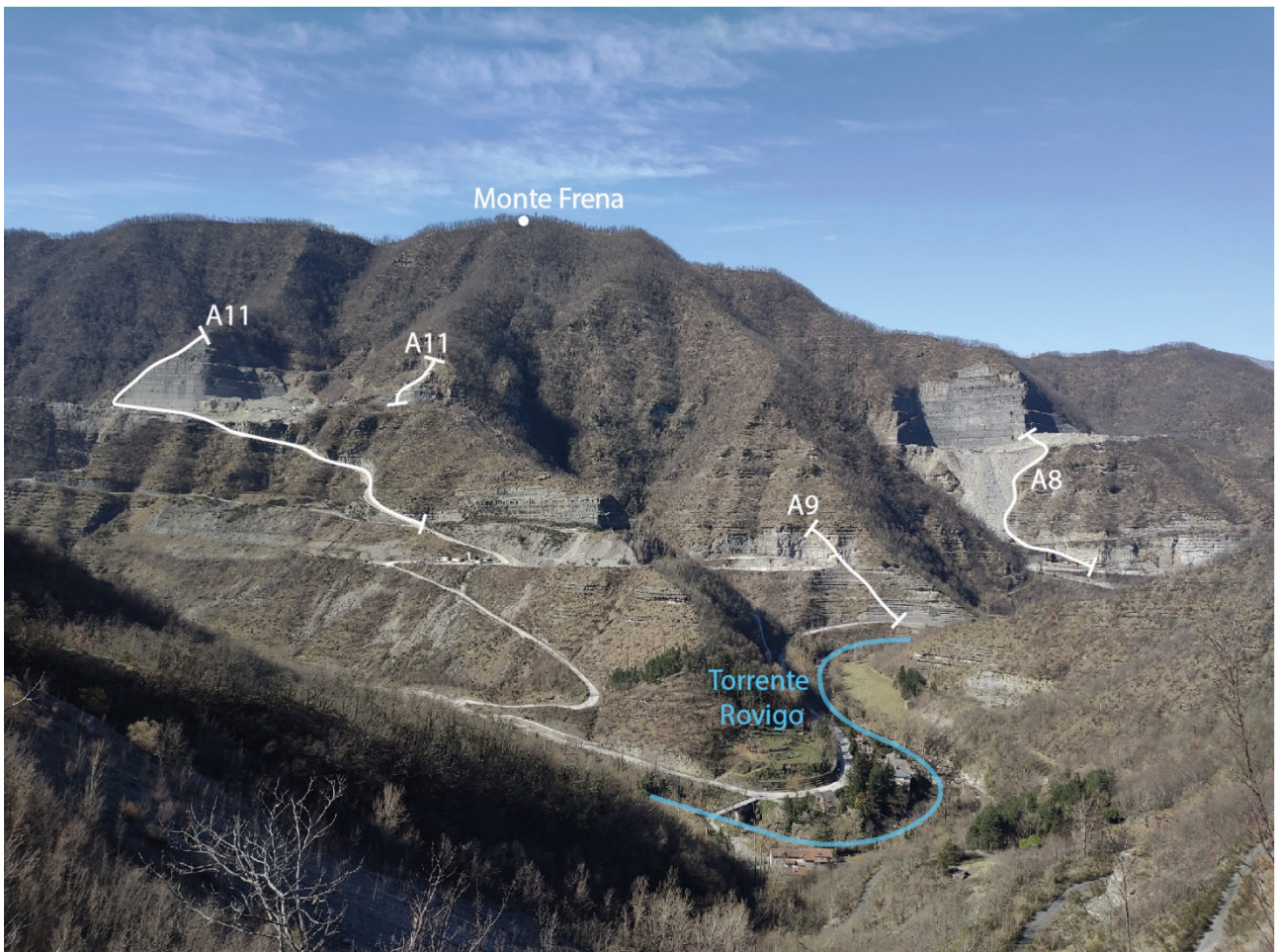
Figura 6.2.27: Foto panoramica, scattata dalla sezione A10, che mostra l'ubicazione delle sezioni A8, A9 e A11.
