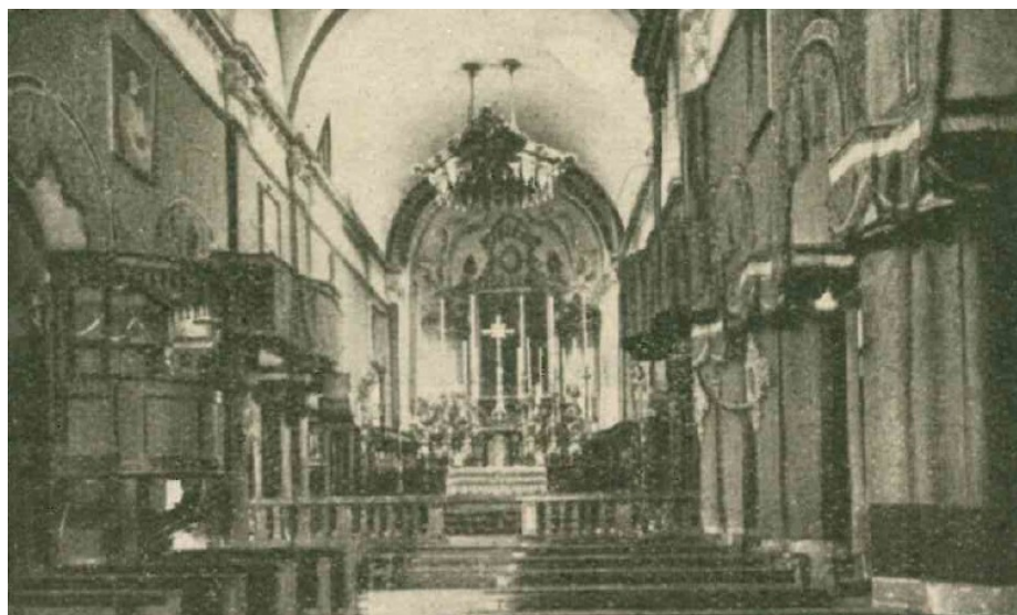
Fig. 318– Castell'Arquato (PC), collegiata di Santa Maria – stato interno prima dei restauri (da FAVA 1938, p. 207)
