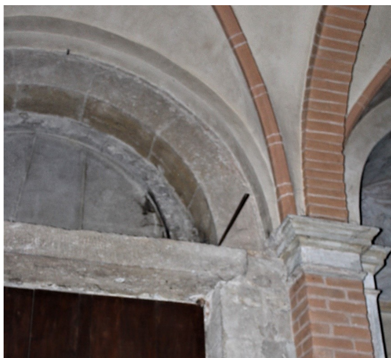
Fig. 340 – Castell'Arquato (PC), collegiata di Santa Maria interno portale settentrionale, dettaglio appoggio architrave
