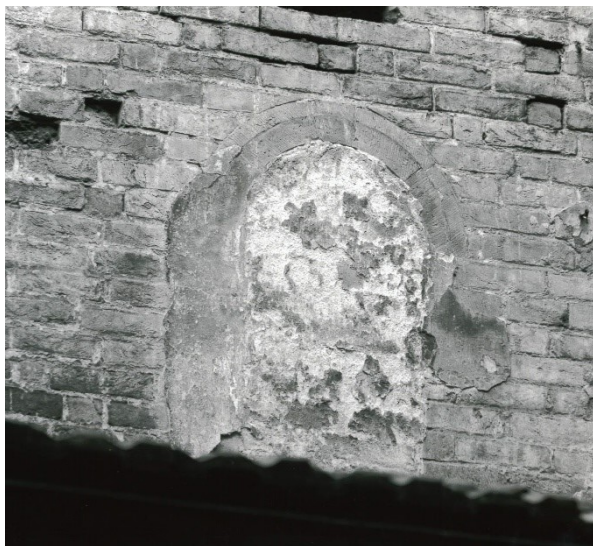
Fig. 206 – Piacenza, chiesa dei Santi Nazario e Celso – fianco nord, monofora tamponata (foto A. M. Segagni)
