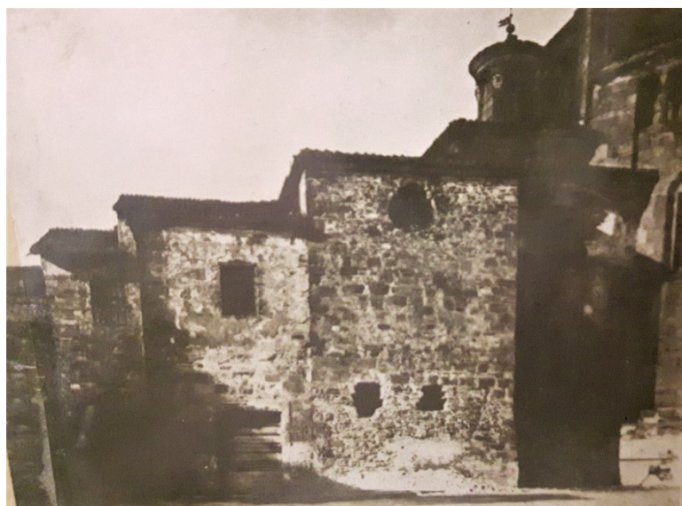
Fig. 315 – Castell'Arquato (PC), collegiata di Santa Maria - stato delle strutture a sud-est della chiesa prima dei restauri, ante 1913 Su gentile concessione della SABAP-Pr (cart. PC/M 8)
