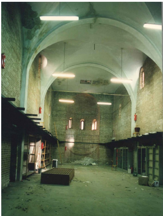
Fig. 219a – Piacenza, chiesa di Sant'Ilario – interno, stato antecedente i restauri Su gentile concessione della SABAP-Pc (cart. PC/M 72)
