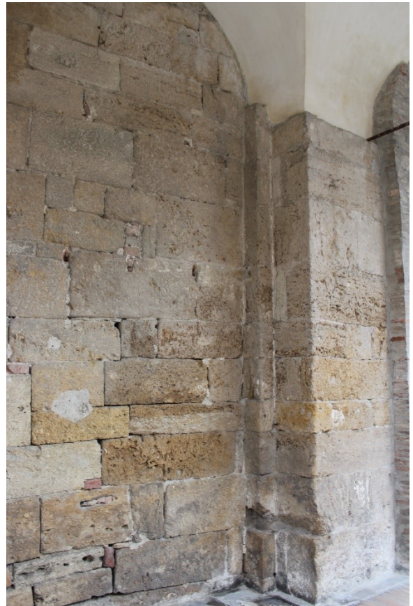
Fig. 337 – Castell'Arquato (PC), collegiata di Santa Maria – prima campata orientale porticato nord, particolare muratura)
