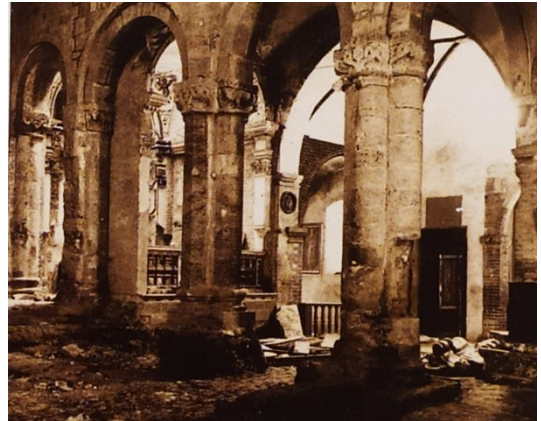
Fig. 321a – Castell'Arquato (PC), collegiata di Santa Maria – abbassamento livello pavimentale (da LE CANNU 1994, p. 95)
