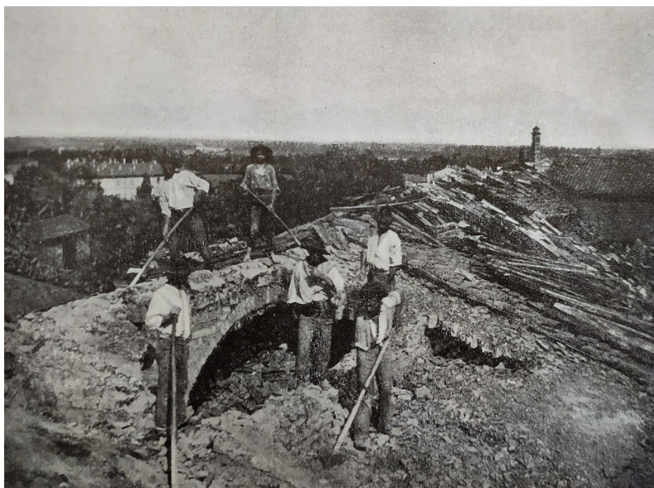
Fig. 67 – Piacenza, chiesa di San Savino – rimozione copertura, restauri inizio XX secolo (da La regia Basilica 1903, p. 63)
