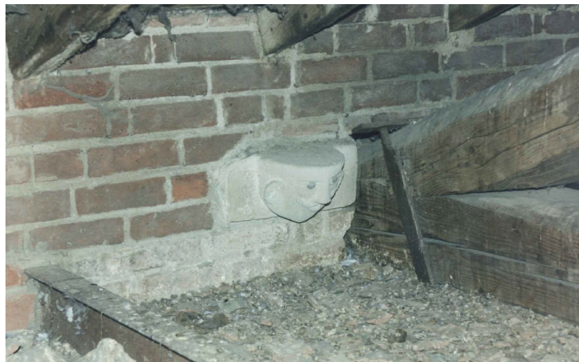
Fig. 220 – Piacenza, chiesa di Sant'Ilario – sottotetto, dettaglio sostegno coperture di restauro Su gentile concessione della SABAP-Pc (cart. PC/M 72)
