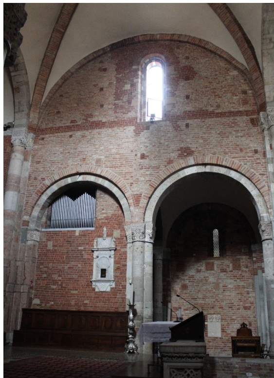
Fig. 86 – Piacenza, chiesa di San Savino – interno, area presbiteriale, parete meridionale (con organo e parete bassa campanile)
