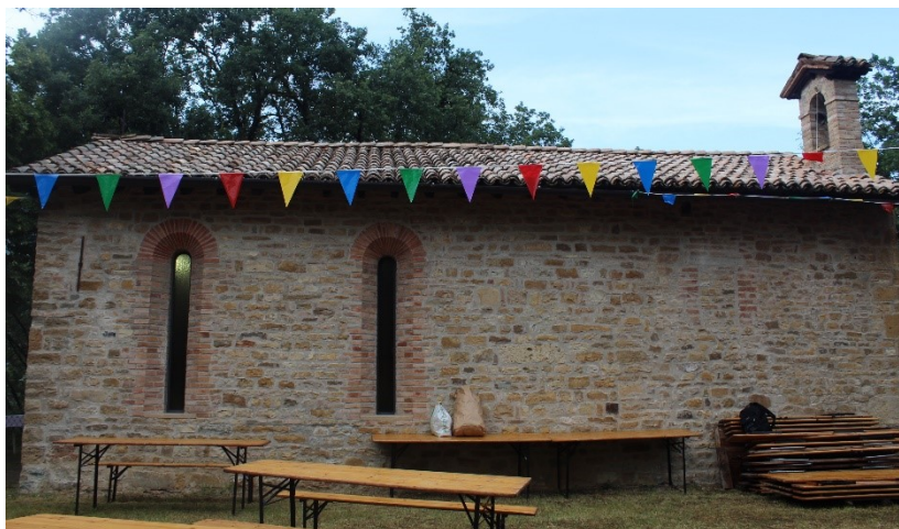
Fig. 392 – Panegano, loc. I Pallastrelli (Castell'Arquato, PC), oratorio di Santa Maria Maddalena – fianco sud
