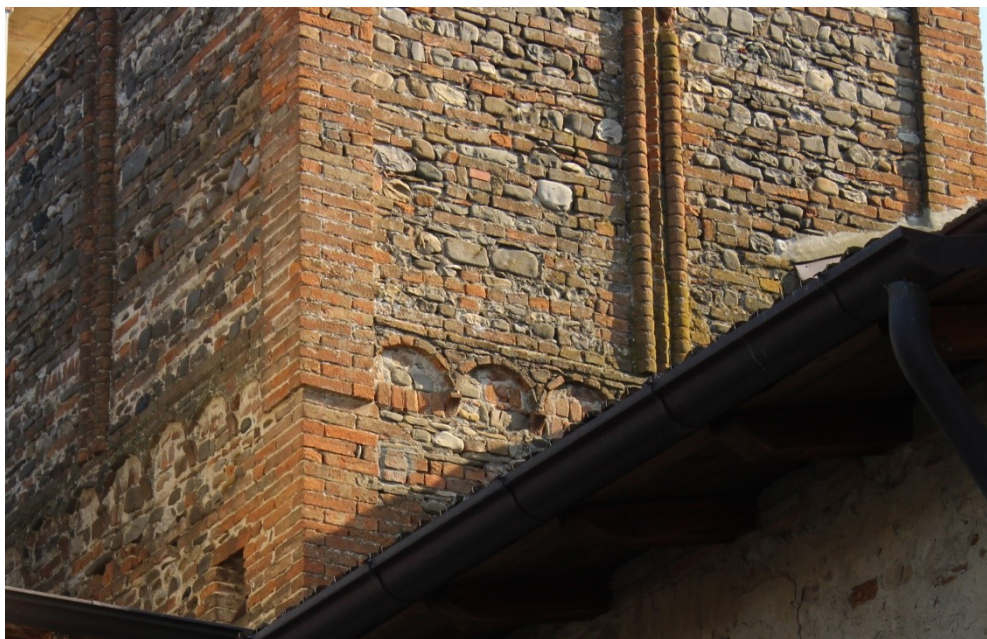
Fig. 2694 – San Giorgio P.no (PC), chiesa di San Giorgio – particolare murature e partiture, angolo nord-ovest
