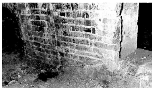
Fig. 42b – Piacenza, chiesa di Sant'Eufemia – sottotetto navatella sud prima dei rifacimenti, particolare muro di spina con traccia falda tetto primitiva (foto A. M. Segagni)
