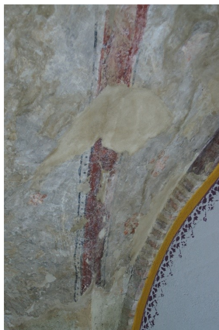
Fig. 47 – Piacenza, chiesa di Sant'Eufemia – sottotetto navatella sud, cappella alta orientale (particolare decorazione vele)
