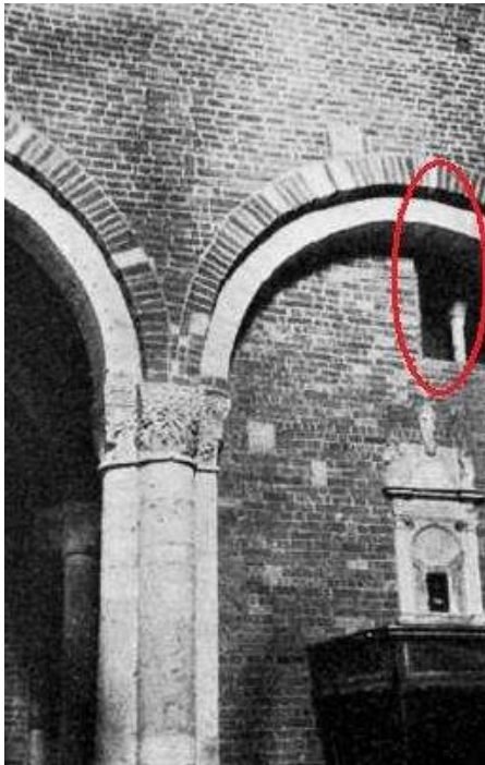
Fig. 70 – Piacenza, chiesa di San Savino – antica bifora del campanile (da PORTER 1917)
