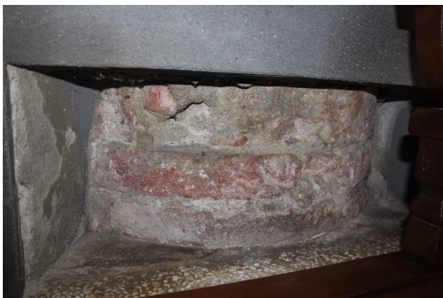
Fig. 251- Pontenure (PC), chiesa di San Pietro – particolare sag- gio con resto del pilastro circolare medievale (2° pilastro sud)
