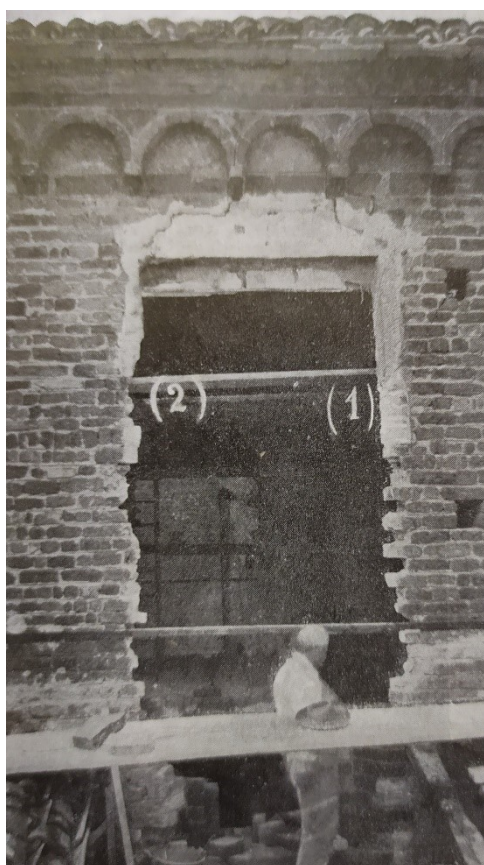
Fig. 68 – Piacenza, chiesa di San Savino – rinvenimento tracce monofore, restauri inizio XX secolo (da La regia Basilica 1903, p. 64)
