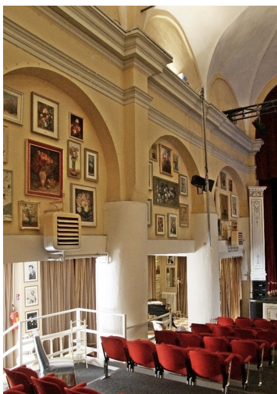
Fig. 176 – Piacenza, ex chiesa di San Matteo – interno (lato sud), stato attuale
