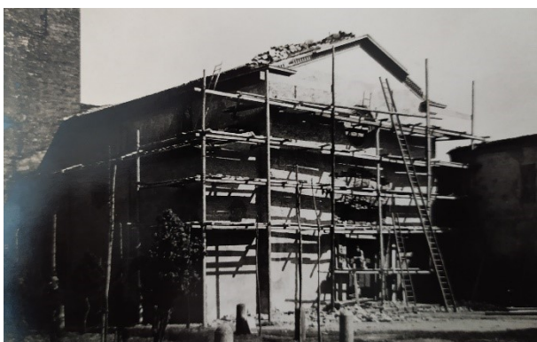
Fig. 237 – Cadeo (PC), chiesa di San Pietro – facciata, stato durante i lavori, 1953-54 Archivio Parrocchiale Cadeo
