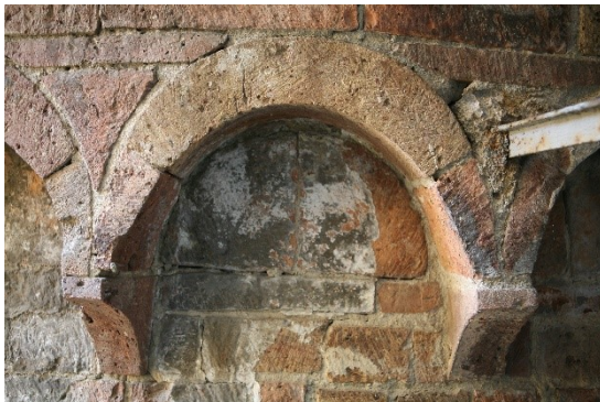
Fig. 126– Piacenza, chiesa di Santa Brigida – abside maggiore, dettaglio archetto pensile
