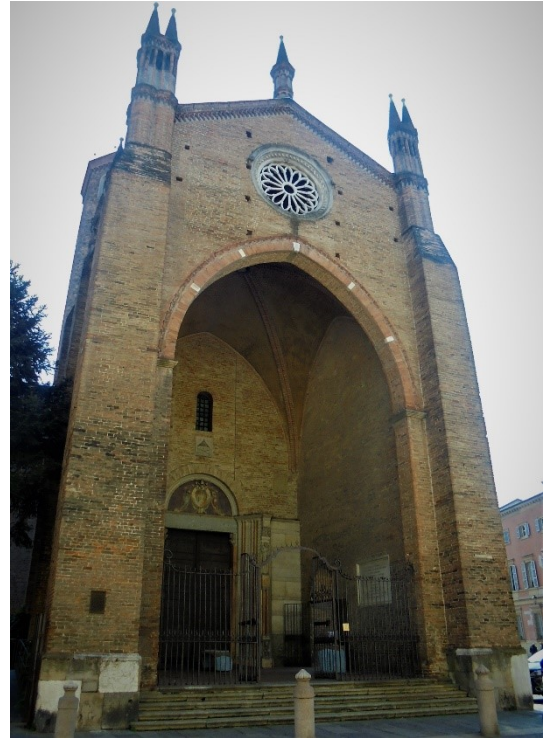
Fig. 141 – Piacenza, chiesa di Sant'Antonino – Paradiso e portale settentrionale
