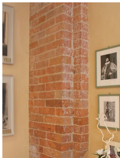
Fig. 181 – Piacenza, ex chiesa di San Matteo – interno, sostegno a muro, lato nord
