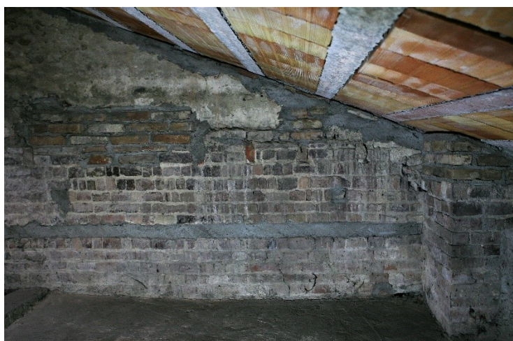
Fig. 45 – Piacenza, chiesa di Sant'Eufemia – sottotetto navatella sud, parete cleristorio (con tracce peducci primitivo livello di copertura)
