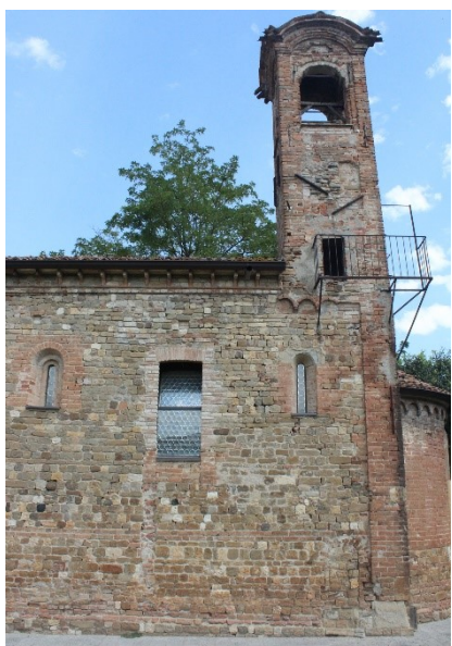
Fig. 258- Podenzano (PC), oratorio di San Giacomo di Caselle – angolo sud-est e campanile
