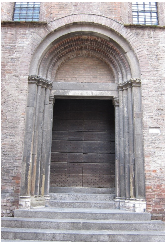
Fig. 198 – Piacenza, demolita chiesa di Sant’Andrea in Borgo – portale oggi murato a Piacenza, basilica di San Francesco, fianco nord
