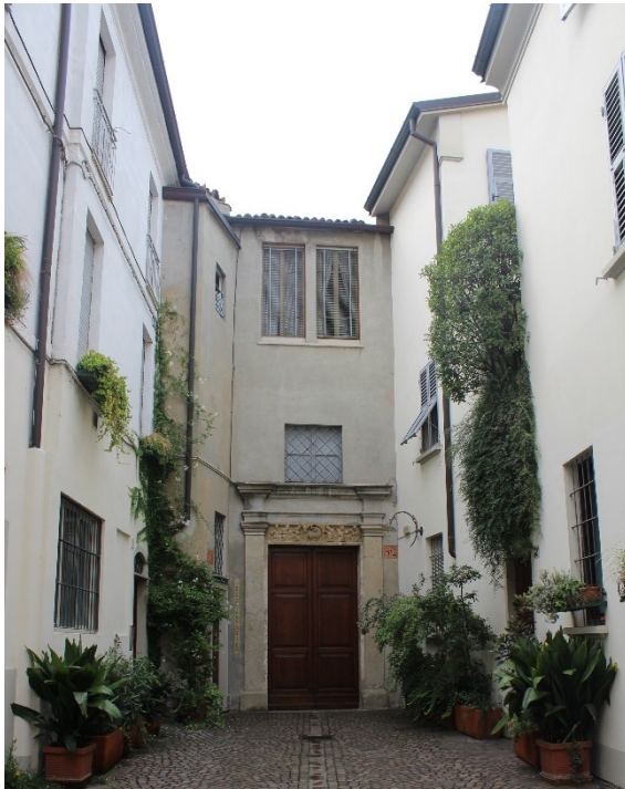
Fig. 184 – Piacenza, ex chiesa di San Matteo – accesso laterale nord
