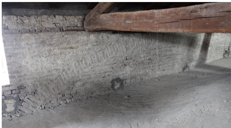
Fig. 43 – Piacenza, chiesa di Sant'Eufemia – sottotetto navata centrale, muro cleristorio (in evidenza arconi e tamponature travi)
