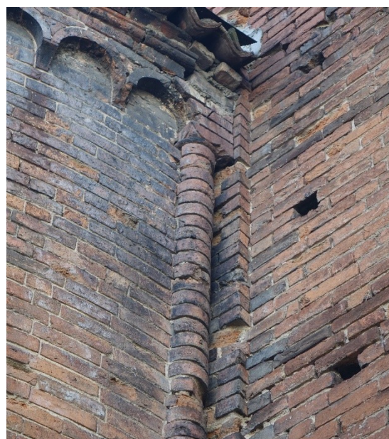
Fig. 174 – Piacenza, ex chiesa di San Matteo – abside, dettaglio innesto campanile
