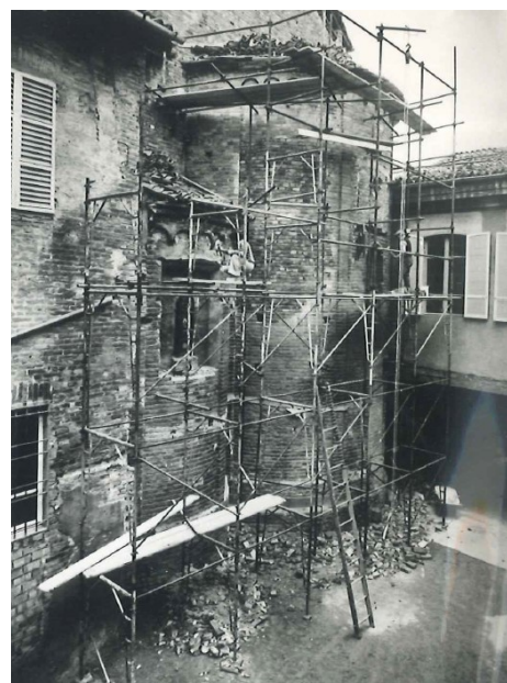
Fig. 33 – Piacenza, chiesa di Sant'Eufemia – absidi durante i restauri 1977 Su gentile concessione della SABAP-Pr (cart. PC/M 31)
