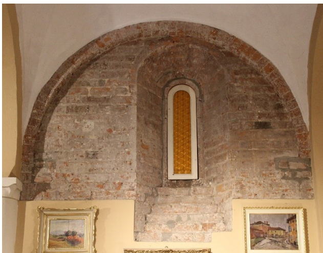
Fig. 178 – Piacenza, ex chiesa di San Matteo – interno, lacerto di parete d'ambito sud con monofora
