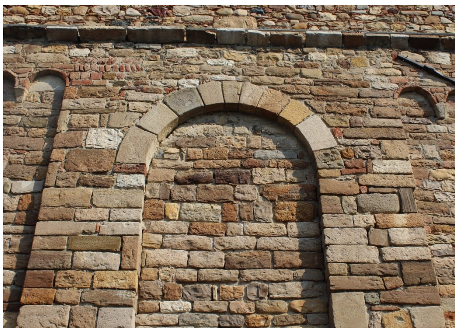
Fig. 291 – Rivergaro (PC), santuario di Santa Maria del Castello, fianco sud, dettaglio
