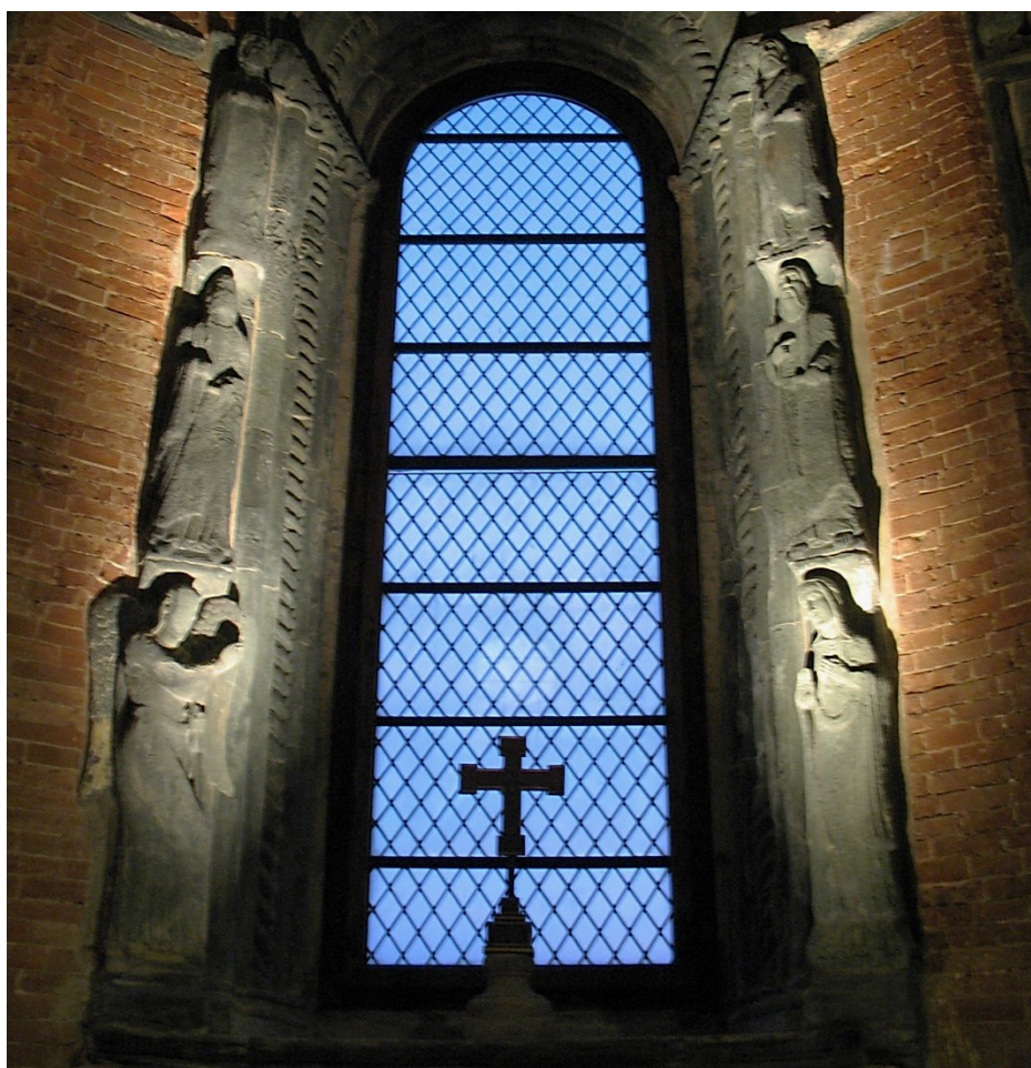
Fig. 23 – Sacra di San Michele della Chiusa (TO), chiesa abbaziale – finestra absidale
