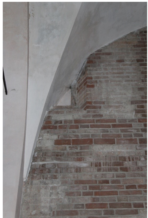
Fig. 219b – Piacenza, chiesa di Sant'Ilario – interno, particolare sovrapposizione volte-monofore
