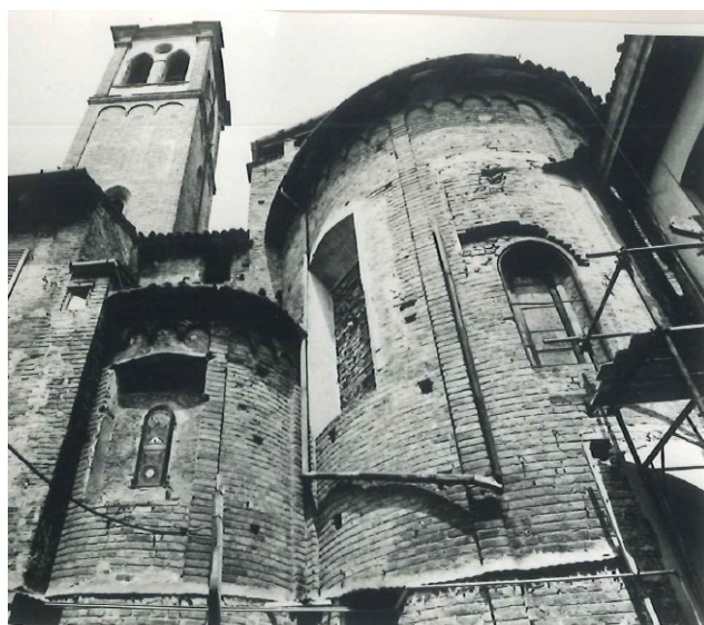
Fig. 32 – Piacenza, chiesa di Sant'Eufemia – absidi prima dei restauri 1977 Su gentile concessione della SABAP-Pr (cart. PC/M 31)
