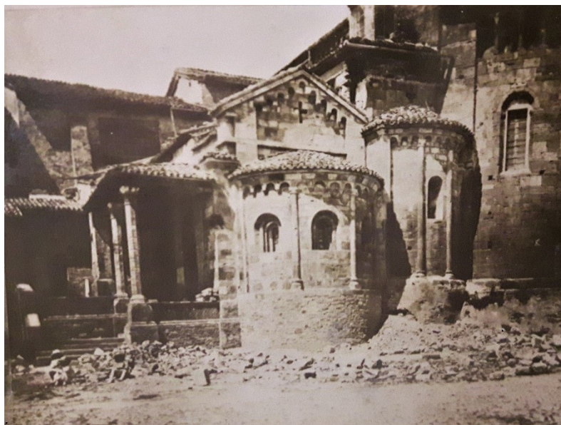
Fig. 317 – Castell'Arquato (PC), collegiata di Santa Maria - stato delle strutture a sud-est dopo i restauri, 1913 Su gentile concessione della SABAP-Pr (cart. PC/M 8)
