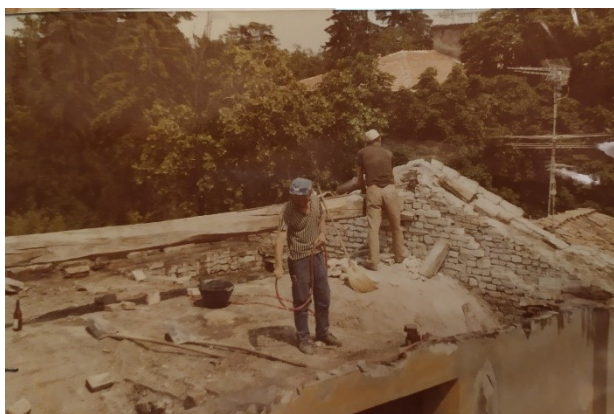
Fig. 249 - Pontenure (PC), chiesa di San Pietro – rifacimento coperture 1981
