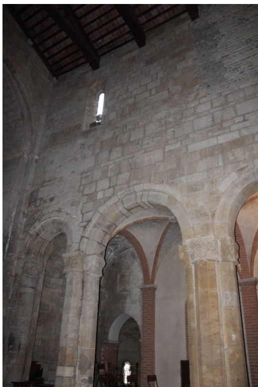
Fig. 330 – Castell'Arquato (PC), collegiata di Santa Maria – intercolumnni orientali lato sud (sulla destra pilastro e arcate di restauro)
