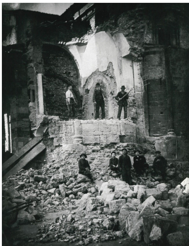
Fig. 316 – Castell'Arquato (PC), collegiata di Santa Maria - stato della struttura corrispondente al battistero durante i restauri, 1913 Foto @Archivio Mazzotti/Tip.Le.Co.)
