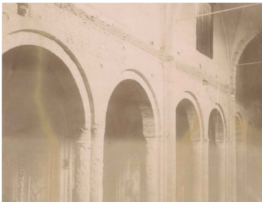
Fig. 30 - Piacenza, chiesa di Sant'Eufemia – scrostatura delle pareti, 1904. Su gentile concessione della SABAP-Pr (cart. PC/M 31)
