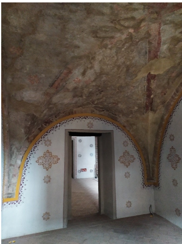
Fig. 46 – Piacenza, chiesa di Sant'Eufemia – sottotetto navatella sud, cappella alta orientale
