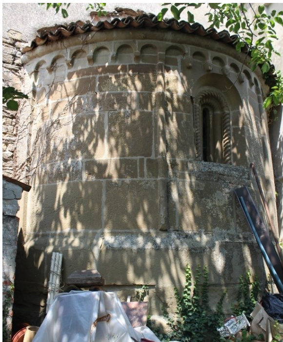
Fig. 299 – Vidiano (Piozzano, PC), chiesa di San Cristoforo – abside, stato attuale
