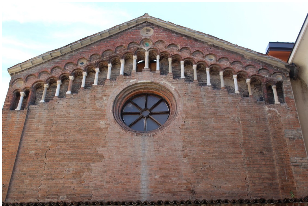
Fig. 230 – Piacenza, chiesa di Sant'Ilario – facciata, parte superiore
