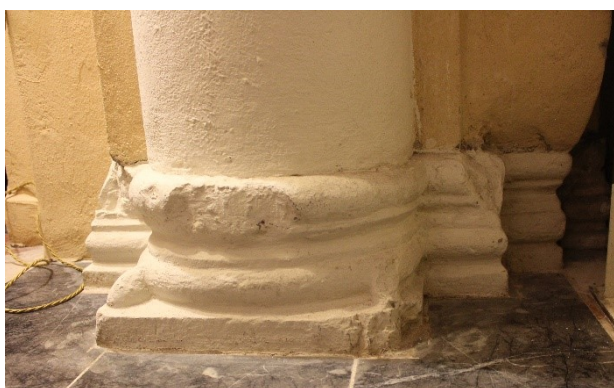
Fig. 182 – Piacenza, ex chiesa di San Matteo – interno, particolare base sostegno a muro
