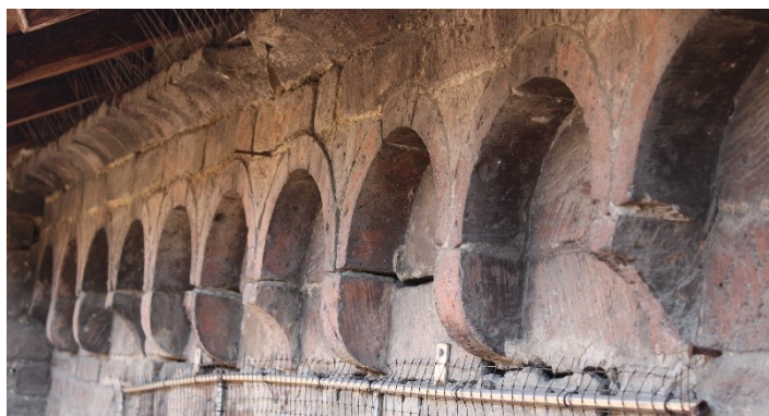
Fig. 130 – Piacenza, chiesa di Santa Brigida – cleristorio meridionale, dettaglio archetti pensili
