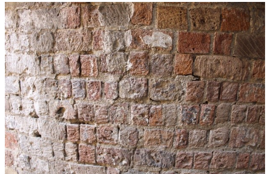
Fig. 127– Piacenza, chiesa di Santa Brigida – abside maggiore, dettaglio muratura
