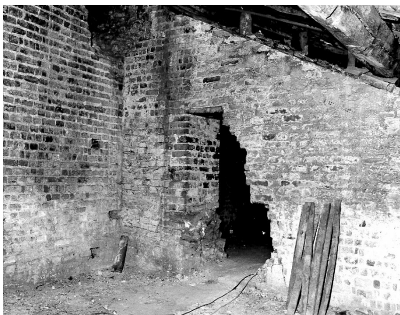
Fig. 42a – Piacenza, chiesa di Sant'Eufemia – sottotetto navatella sud prima dei rifacimenti, particolare innesto muro di spina (foto A. M. Segagni)
