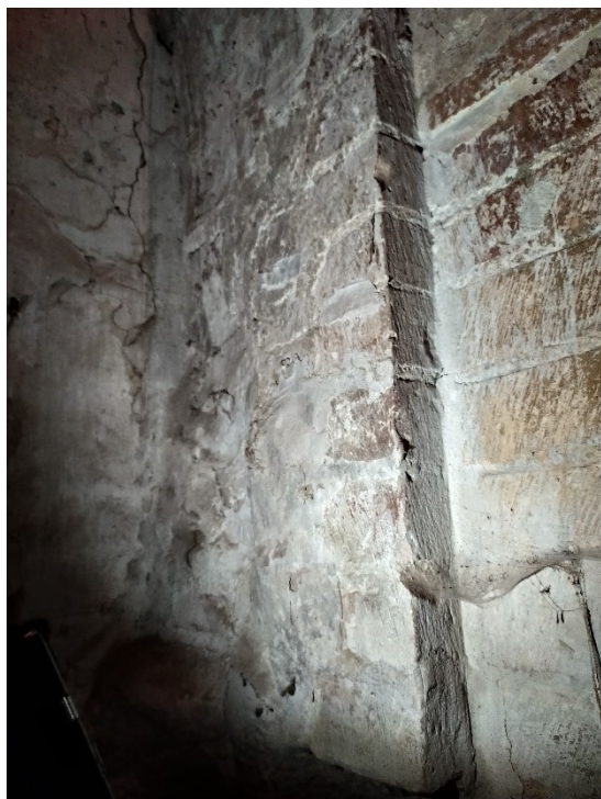
Fig. 265– Roncaglia (PC), chiesa di San Bartolomeo – particolare muratura medievale – lacerto antica abside
