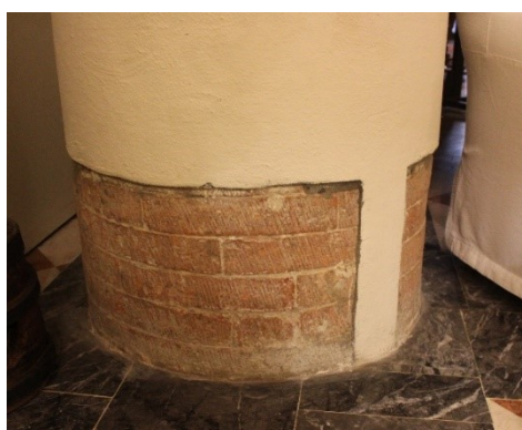
Fig. 183 – Piacenza, ex chiesa di San Matteo – interno, lacerto muratura pilastro circolare
