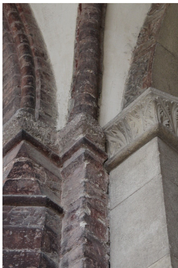
Fig. 339b – Castell'Arquato (PC), collegiata di Santa Maria – portico nord, sostegni a muro in coincidenza del portale, dettaglio sovrapposizione
