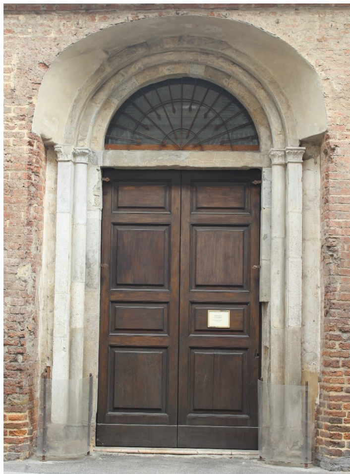
Fig. 213 – Piacenza, chiesa dei Santi Nazario e Celso – fianco sud, portale
