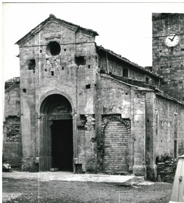
Fig. 361 – Vigoleno (PC), pieve di San Giorgio – edificio con restauri in corso (portico già rimosso), anni '60 (provenienza A. M. Segagni)
