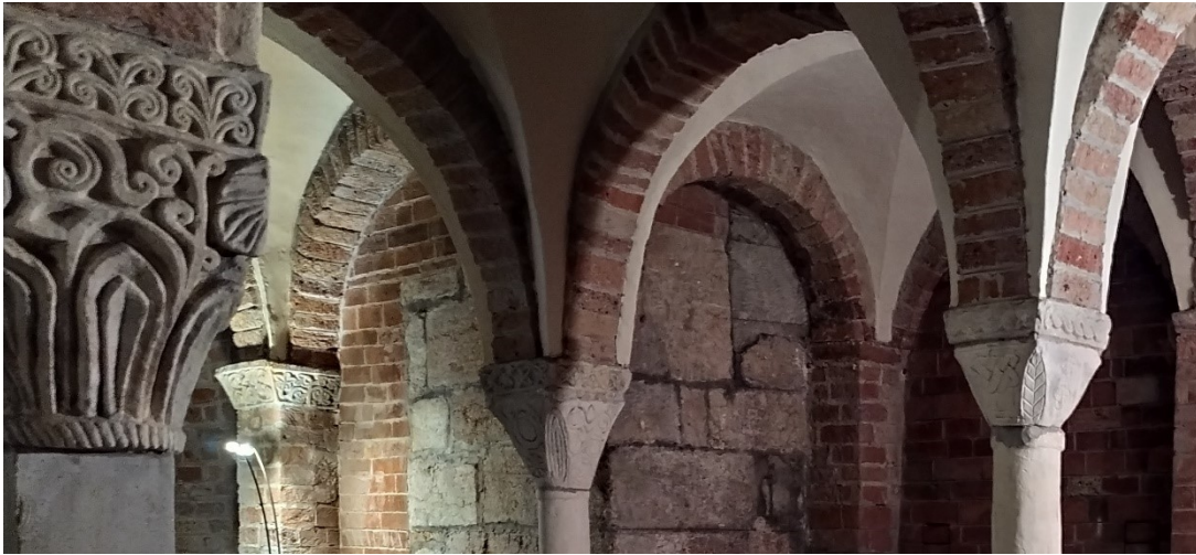
Fig. 97 – Piacenza, chiesa di San Savino – cripta, capitelli colonne sud
