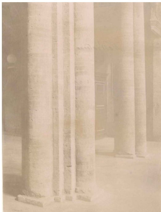
Fig. 35 – Piacenza, chiesa di Sant'Eufemia – pilastri appena liberati durante i restauri, 1904 Su gentile concessione della SABAP-Pr (cart. PC/M 31)
