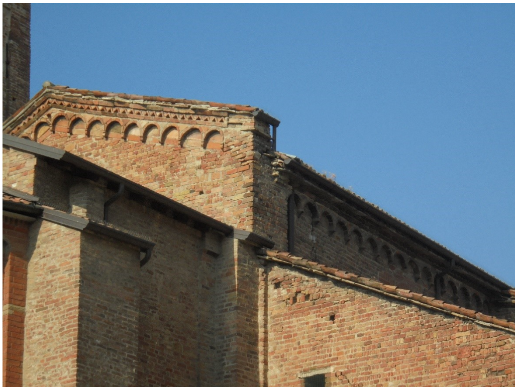
Fig. 77 – Piacenza, chiesa di San Savino – cleristorio settentrionale e murature superiori testata orientale
