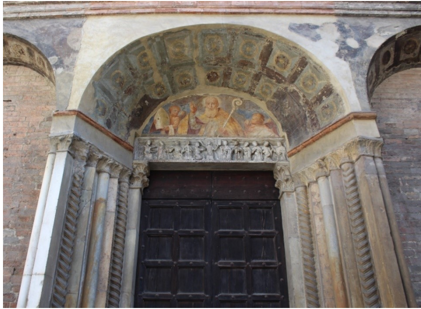
Fig. 231 – Piacenza, chiesa di Sant’Ilario – facciata, parte superiore
