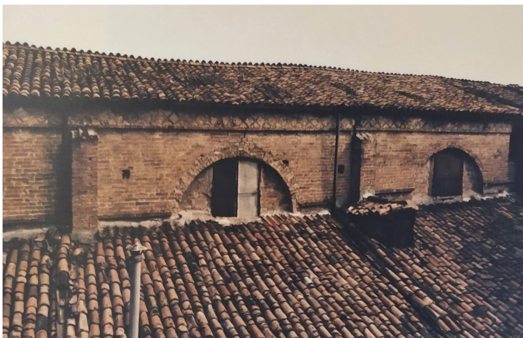
Fig. 161 – Piacenza, chiesa di Santo Stefano – cleristorio sud – foto durante il rifacimento della copertura, giugno 1990 Su gentile concessione della SABAP-Pr (cart. PC/M 217, foto arch. C. Ferrari)
