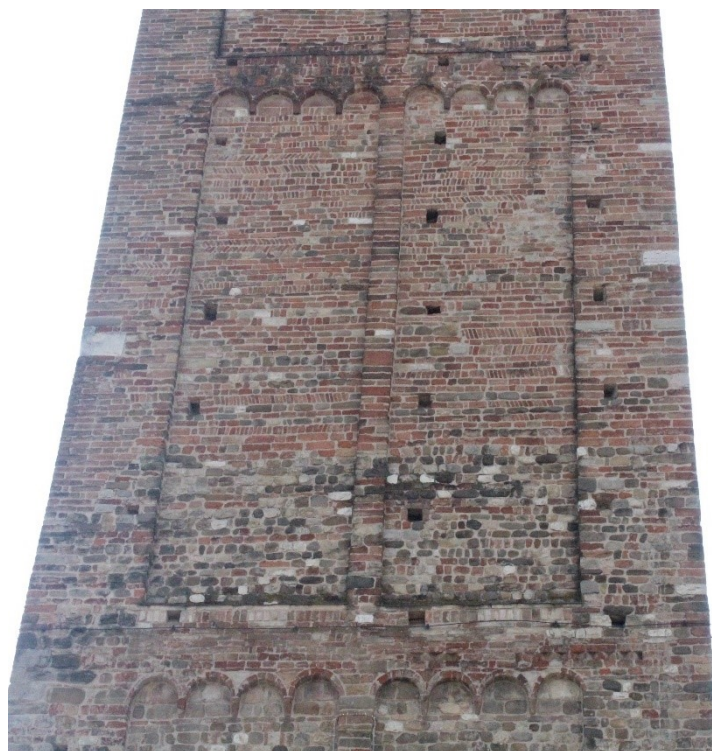
Fig. 253 - Pontenure (PC), chiesa di San Pietro – campanile, dettaglio muratura (lato ovest)
