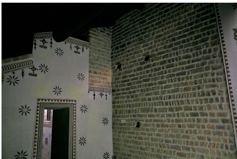
Fig. 41 – Piacenza, chiesa di Sant'Eufemia – sottotetto navatella sud, particolare murature e muro di spina
