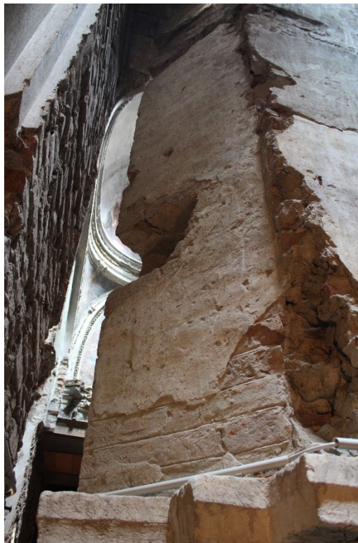
Fig. 90 – Piacenza, chiesa di San Savino – intercapedine sud, contrafforte a sperone sopra alla colonna-sepolcro
