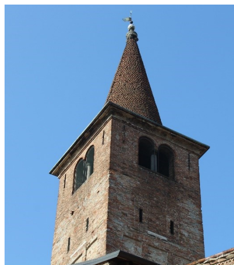
Fig. 79 – Piacenza, chiesa di San Savino – torre campanaria
