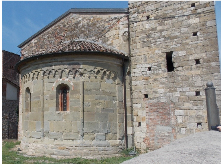
Fig. 281– Breno (Borgonovo Val Tidone, PC), chiesa di Sant'Ilario – abside e base della torre campanaria
