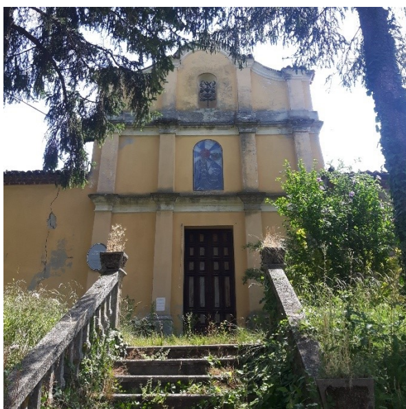
Fig. 298 – Vidiano (Piozzano, PC), chiesa di San Cristoforo – facciata, stato attuale
