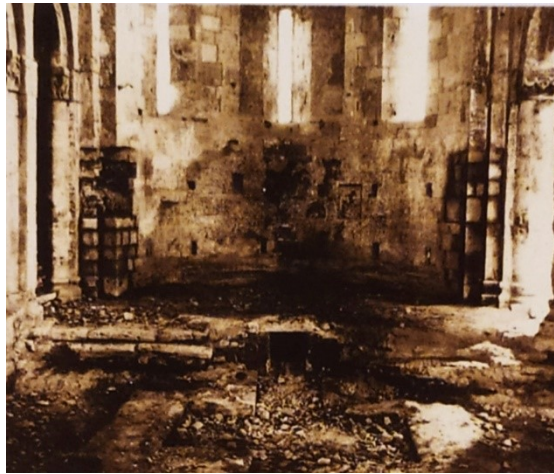
Fig. 321b – Castell'Arquato (PC), collegiata di Santa Maria – restauro abside maggiore (da LE CANNU 1994, p. 95)
