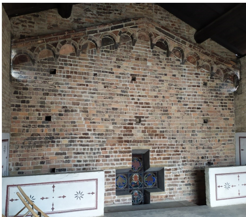
Fig. 55 – Piacenza, chiesa di Sant'Eufemia – sottotetto narteca, coronamento facciata primitiva
