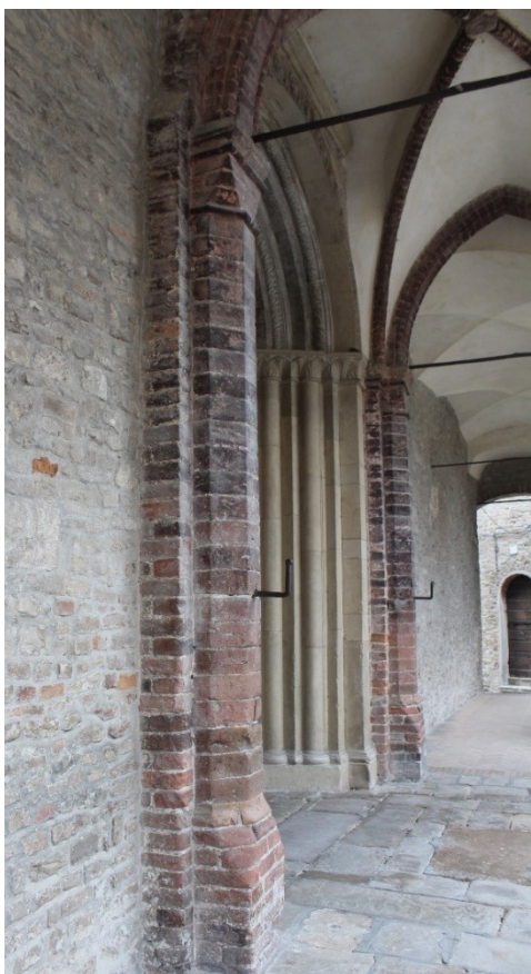
Fig. 339a – Castell'Arquato (PC), collegiata di Santa Maria – portico nord, sostegni a muro in coincidenza del portale
