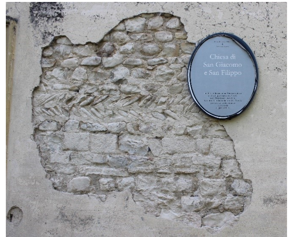
Fig. 271 – Bruso (Borgonovo Val Tidone, PC), chiesa dei Santi Filippo e Giacomo – facciata, particolare lacerto muratura con ciottoli in opus spicatum
