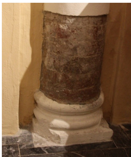
Fig. 180 – Piacenza, ex chiesa di San Matteo – interno, resto di sostegno a muro, lato sud
