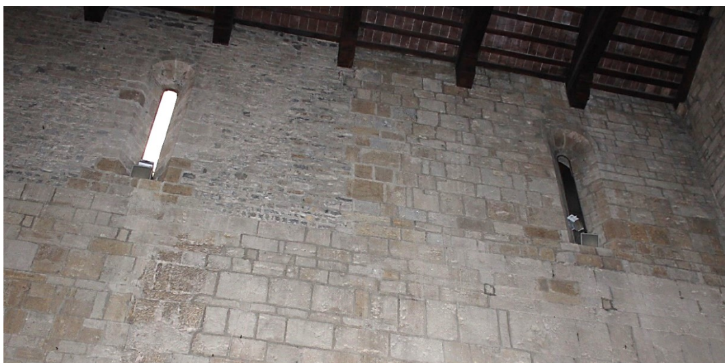
Fig. 332 – Castell'Arquato (PC), collegiata di Santa Maria – cleristorio nord, particolare cambio muratura
