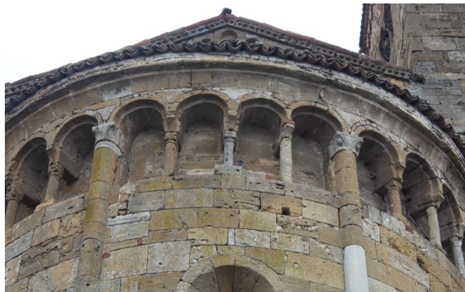
Fig. 334 – Castell'Arquato (PC), collegiata di Santa Maria – abside maggiore, galleria di coronamento
