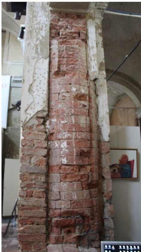
Fig. 212a – Piacenza, chiesa dei Santi Nazario e Celso – interno – sostegno della navata maggiore con antico pilastro circolare a vista
