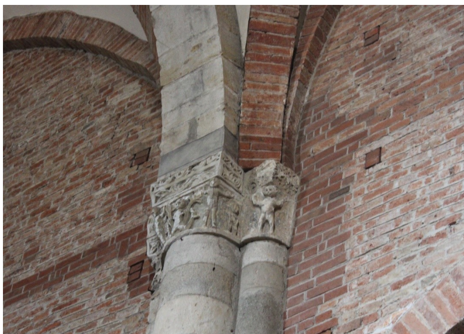
Fig. 88 – Piacenza, chiesa di San Savino – interno, particolare ricaduta costoloni sui salienti
