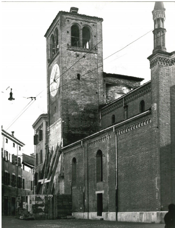
Fig. 121 – Piacenza, chiesa di Santa Brigida – fianco nord restaurato e torre campanaria pericolante (provenienza A.M. Segagni)
