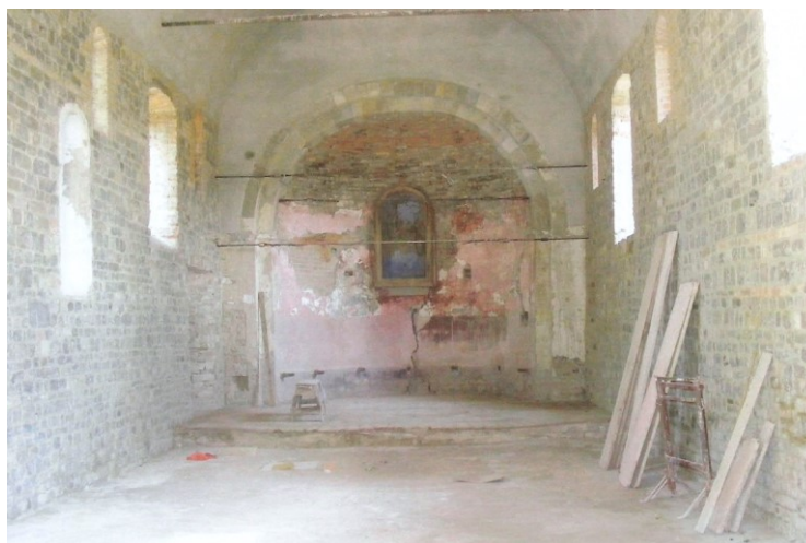
Fig. 260– Podenzano (PC), oratorio di San Giacomo di Caselle – interno durante i restauri Su gentile concessione del Comune di Podenzano
