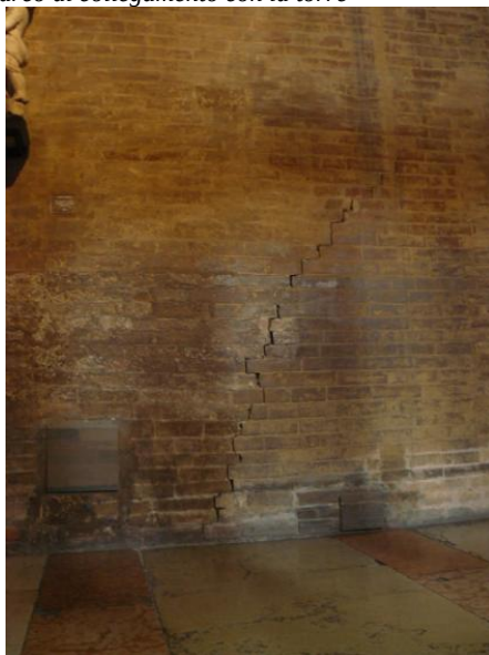
FIG. 12- Lesione dovuta alla spinta dell'arco di collegamento con la torre
