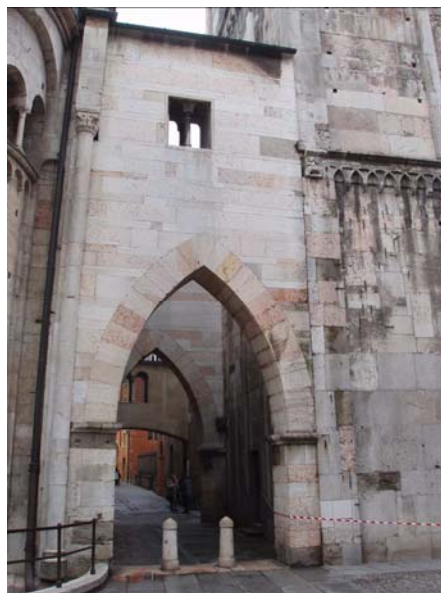
FIG.40- Immagine dei tre archi che collegano il Duomo agli edifici limitrofi
