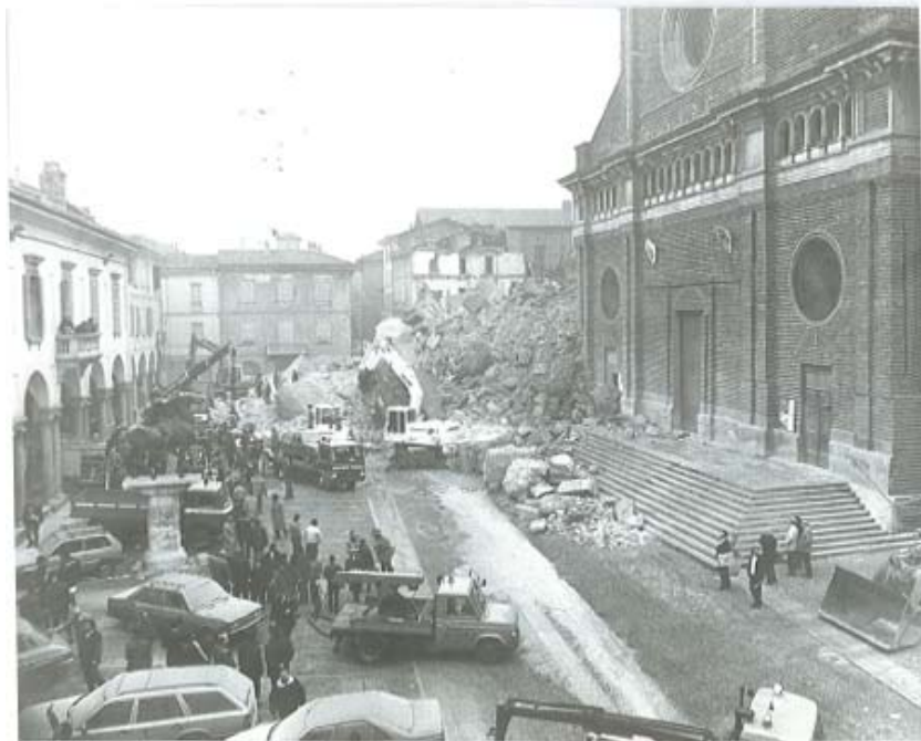
FIG. 21-Foto Chiesa Cattedrale di Pavia dopo il crollo della torre
