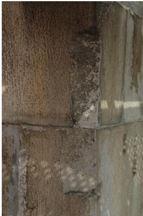
FIG. 51 Lesioni stuccate e riaperte dovute a movimenti della struttura.
