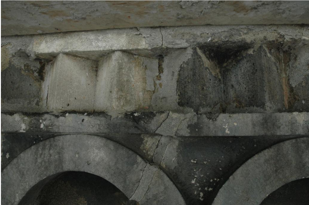
FIG. 51 Lesioni stuccate e riaperte dovute a movimenti della struttura.
