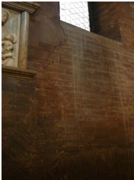
FIG. 12- Lesione dovuta alla spinta dell'arco di collegamento con la torre
