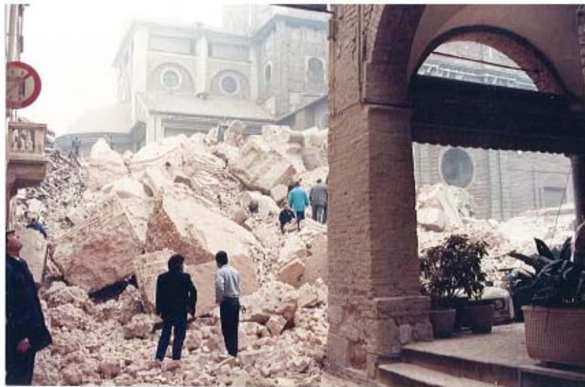
FIG. 22-Foto Chiesa Cattedrale di Pavia dopo il crollo della torre
