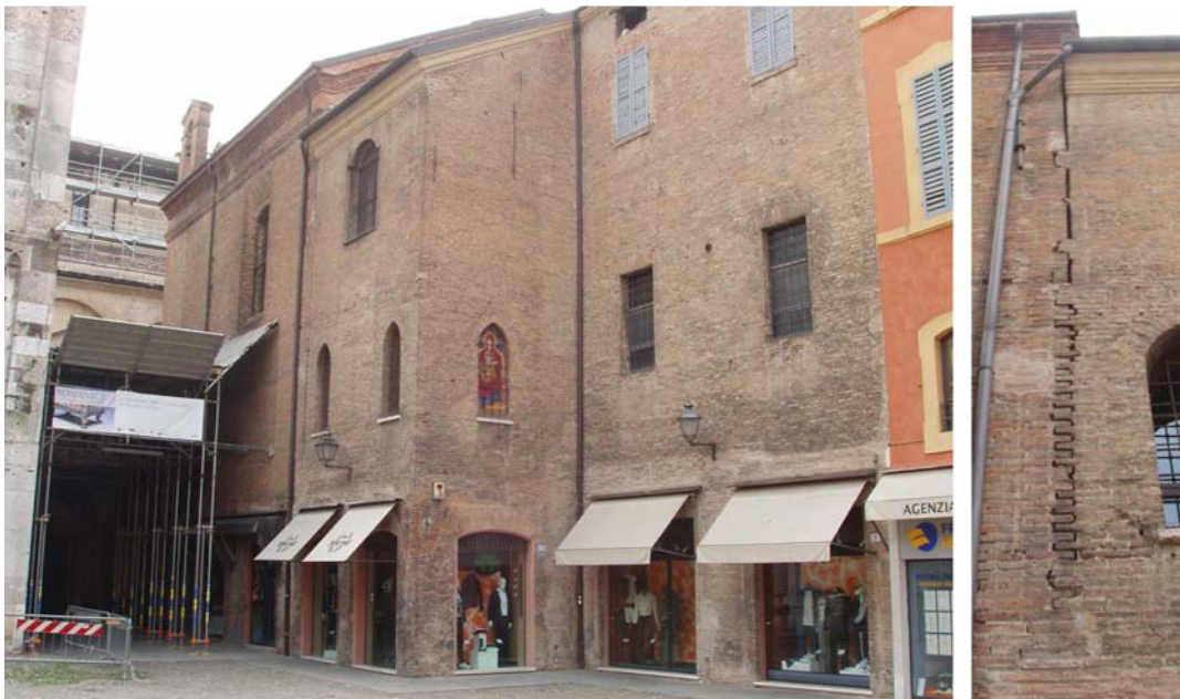
FIG. 14 - L'immagine mostra una lesione in prossimità della linea d'unione tra le canoniche e gli edifici retrostanti, caratterizzata da un'apertura divergente verso l'alto, indice di una rotazione complessiva verso il Duomo. Immagine a cura di architetti Silvia Tosini, Matteo Bonini.
