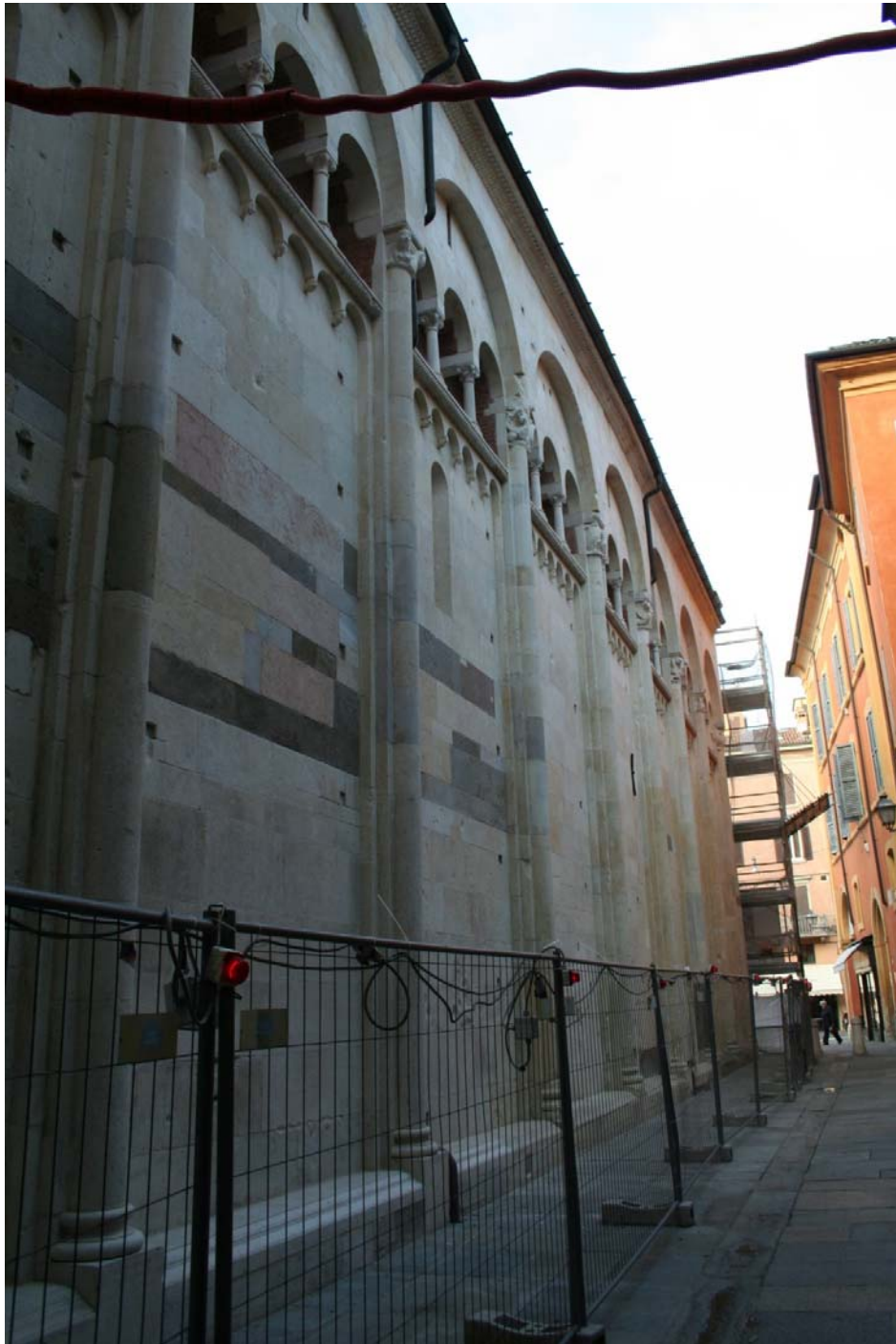
FIG. 47- Duomo, lato nord, vista dalla torre verso la facciata, liberata dai ponteggi dopo l'ultimo restauro.
