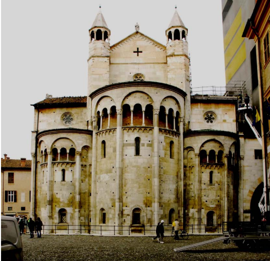
FIG. 29- Immagine del prospetto est del Duomo. Si nota come il sistema delle absidi sia più inclinato rispetto ai finti transetti realizzati epoca campionesse.
