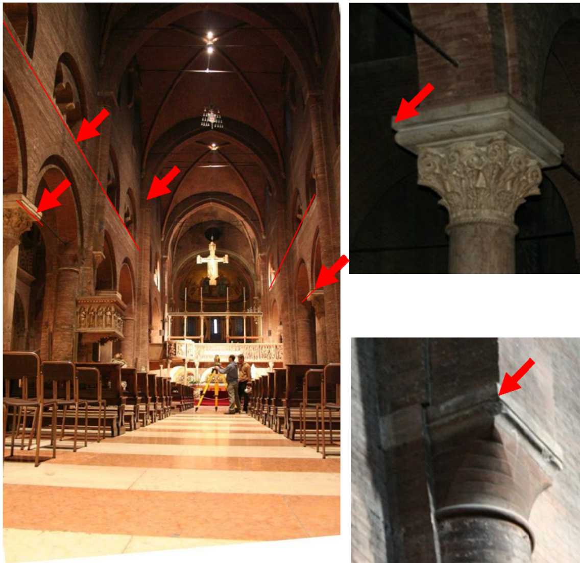
FIG. 23-Nell'immagine vengono evidenziati gli allineamenti oggetti del rilievo altimetrico all'interno della navata centrale.
