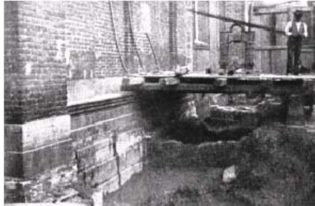
FIG.17 Immagine dell'intervento di consolidamento delle fondazioni del campanile del 1904
