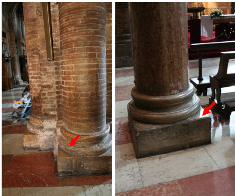
FIG. 22- Nelle immagini sono evidenziati I punti rilevati dei basamenti dei pilastri “forti e deboli”
