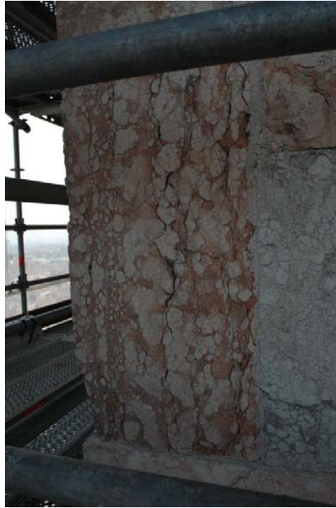
FIG. 49-Lesioni dovute all'azione combinata di gelo - disgelo e alla compressione delle pietre.
