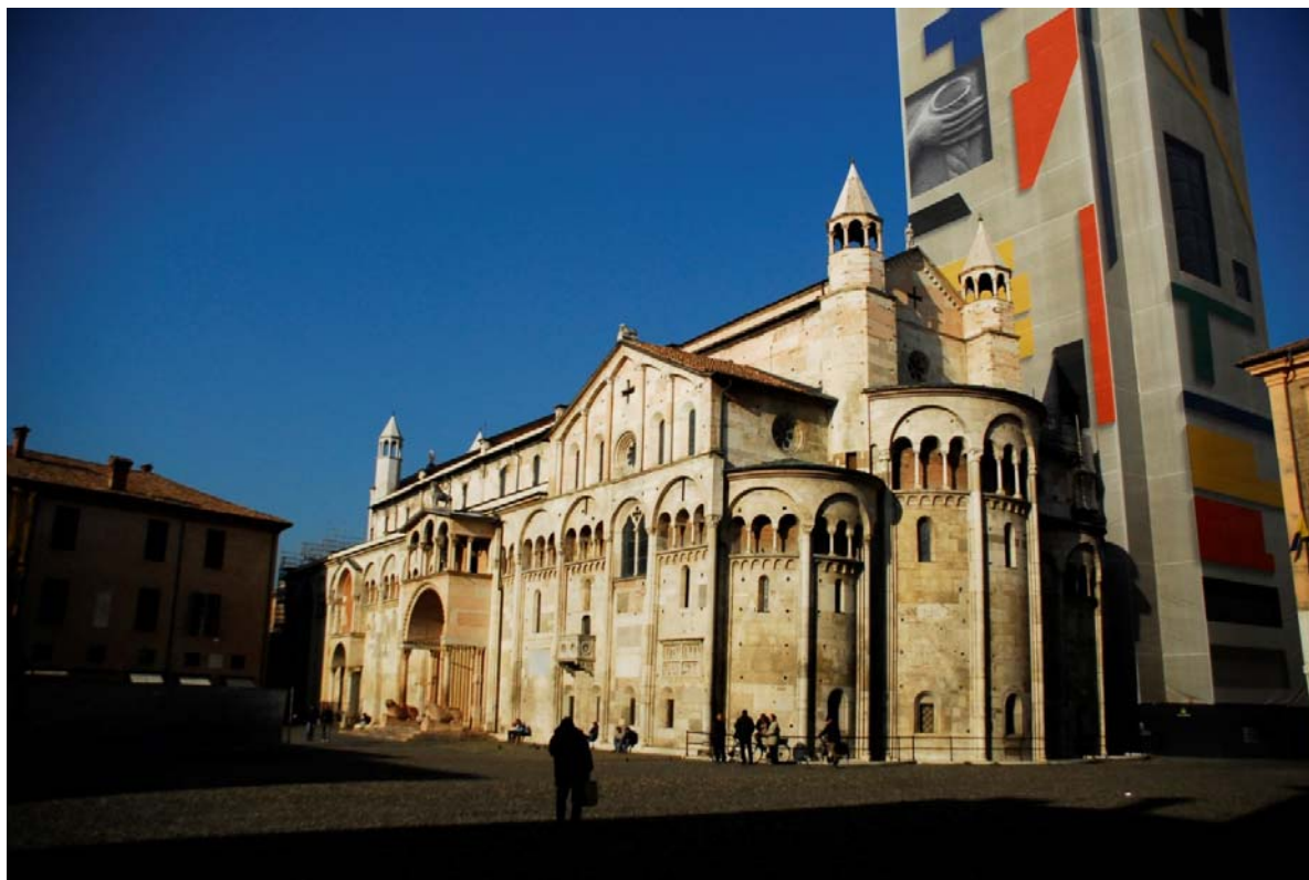
FIG. 45- Immagine del Duomo, lato sud, vista dai portici del Comune, si notano le modanature del paramento lapideo che partono dalle absidi e si ripetono lungo il perimetro, inoltre è evidente la modifica campionesse del finto transetto.
