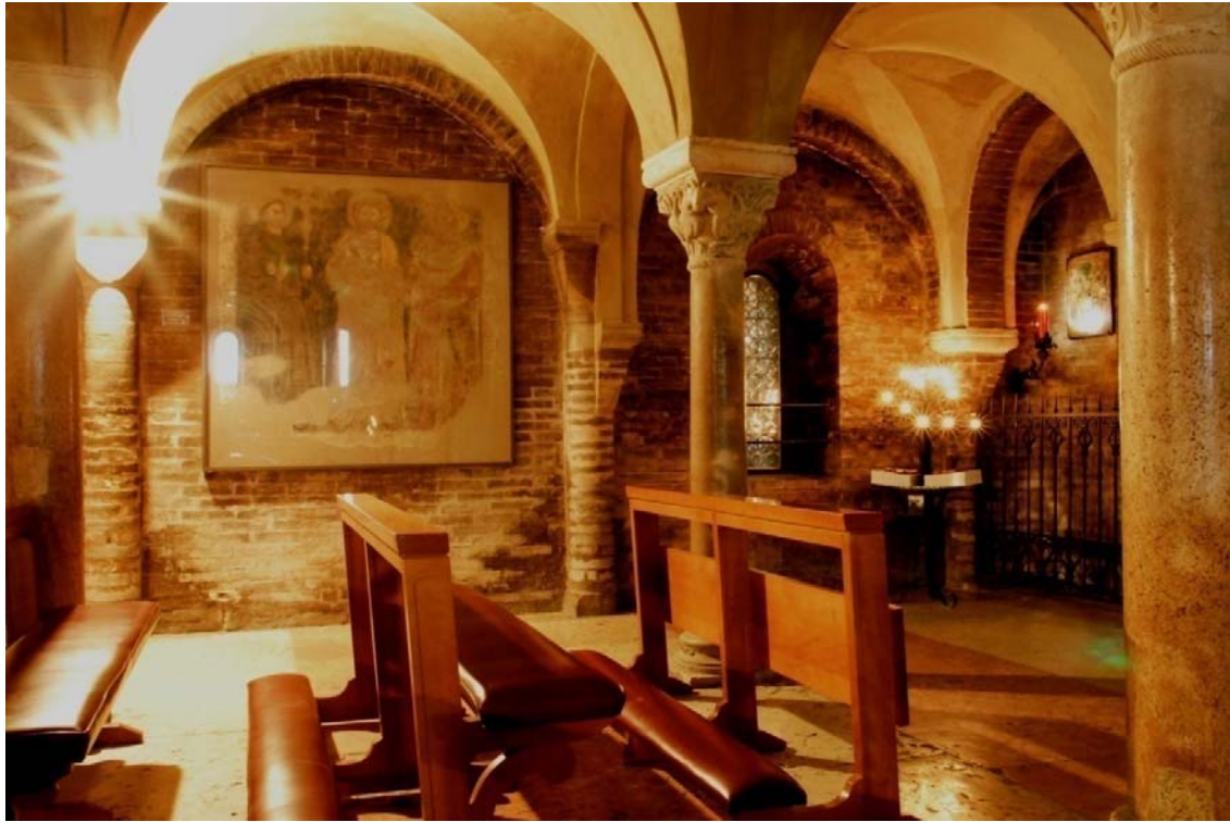
FIG 39 Immagine che riprende il sistema dei capitelli lungo il lato settentrionale della cripta. Le quote diverse d'imposta delle volte sono dovute al sopralzo avvenuto in epoca campionesa.
