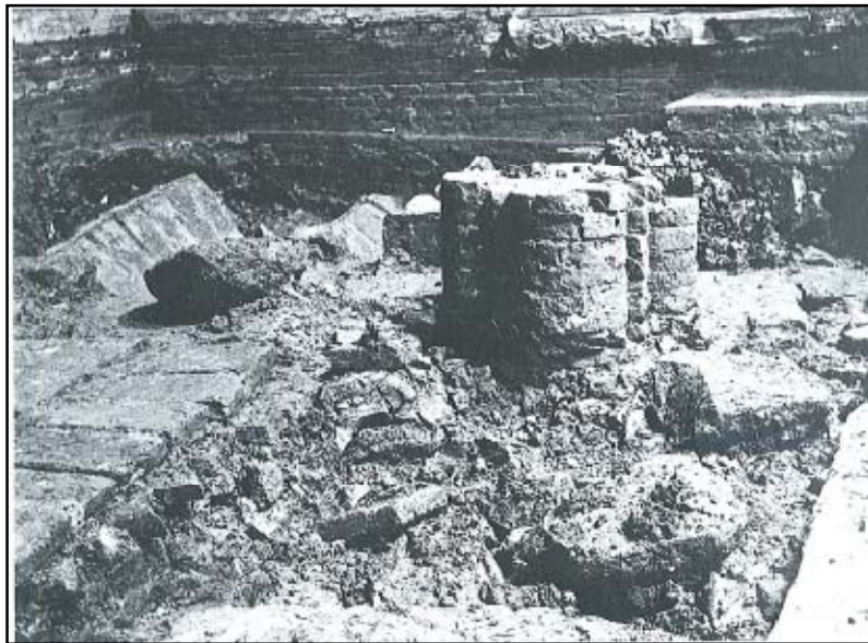
FIG. 10 Immagine degli scavi del 1913, si nota forma quadrilobata dei pilastri forti della precedente cattedrale
