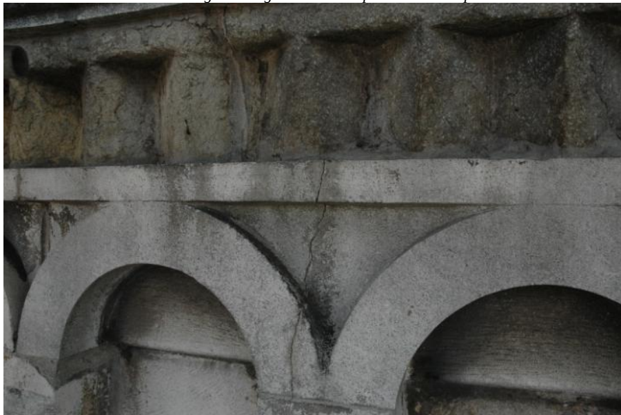
FIG. 49-Lesioni dovute all'azione combinata di gelo - disgelo e alla compressione delle pietre.
