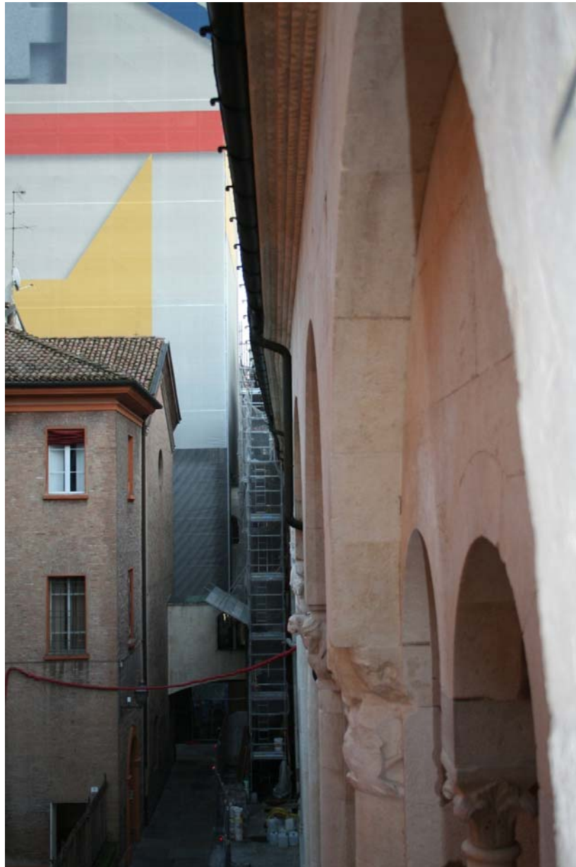
FIG. 46- Duomo, Lato nord, immagine da ponteggio, si notano il collegamento con canoniche. E' ben visibile anche una irregolarità nell'andamento lineare della cornice.
