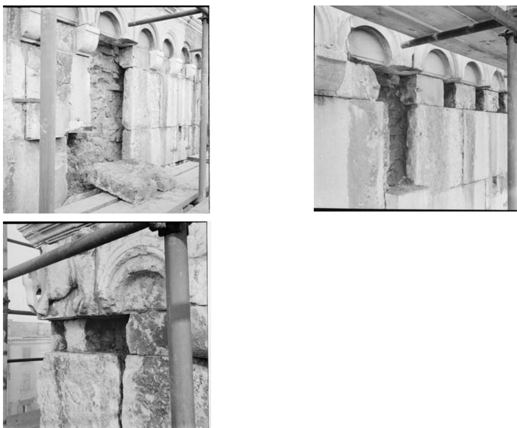
FIG. 63-Sequenza di immagini dei restauri del 1970. Si può notare come il paramento lapideo sia staccato dalla muratura
