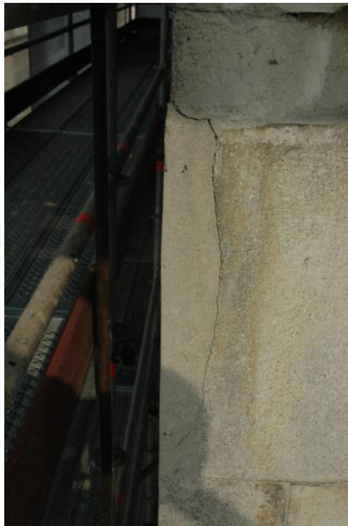
FIG. 53-Lesione a clessidra con distacco antico stuccato e riaperto.
