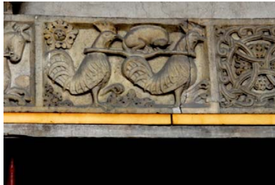
FIG. 45 Ingrandimento dell'architrave della Porta della Pescheria. Si nota la rottura dovuta ai fenomeni di cedimento in atto del Duomo
