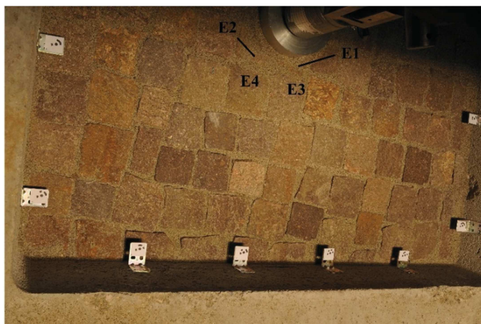
Figura 4.72 – Elementi direttamente caricati dalla piastra E1 ed E2 ed elementi adiacenti E3 ed E4 durante la prova realizzata con pressa dinamica sulla pavimentazione dello Schema 3
