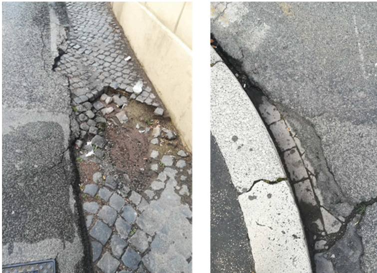
Figura 3.2 – Overlay di manti bituminosi.
