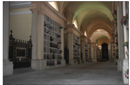
Fig. 5.2.2 – Interno Galleria Nord.
