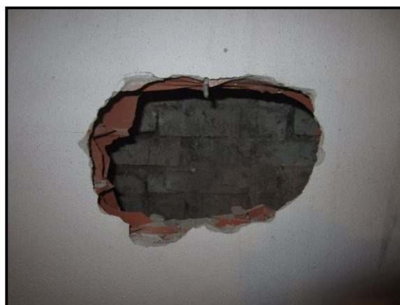
Figura 21_Saggi sui solai volti all'identificazione della tipologia dei paramenti murari resistenti svolta presso l'Ospedale di Mirandola, Corpo 02
