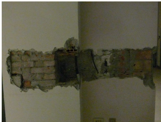
Figura 22_Saggi sui solai volti all'identificazione della tipologia dei paramenti murari resistenti svolta presso ex sede Banca d'Italia, Parma
