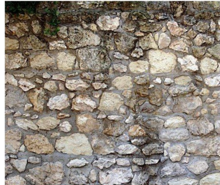
Figura 3-4_ Muratura in pietra a spacco: elementi arrotondati.
