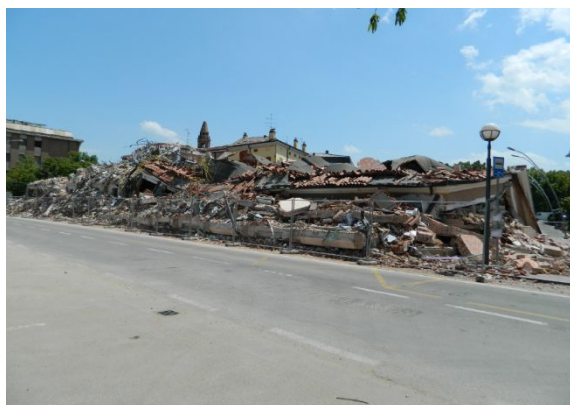
Figura 26_Edificio residenziale, Cavezzo, MO
