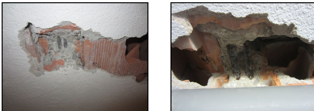
Figura 20_Saggi sui solai volti all'identificazione della tipologia del solaio e delle armature presenti ottenuti durante la campagna di indagini svolta presso l'Ospedale di Mirandola, Corpo 02
