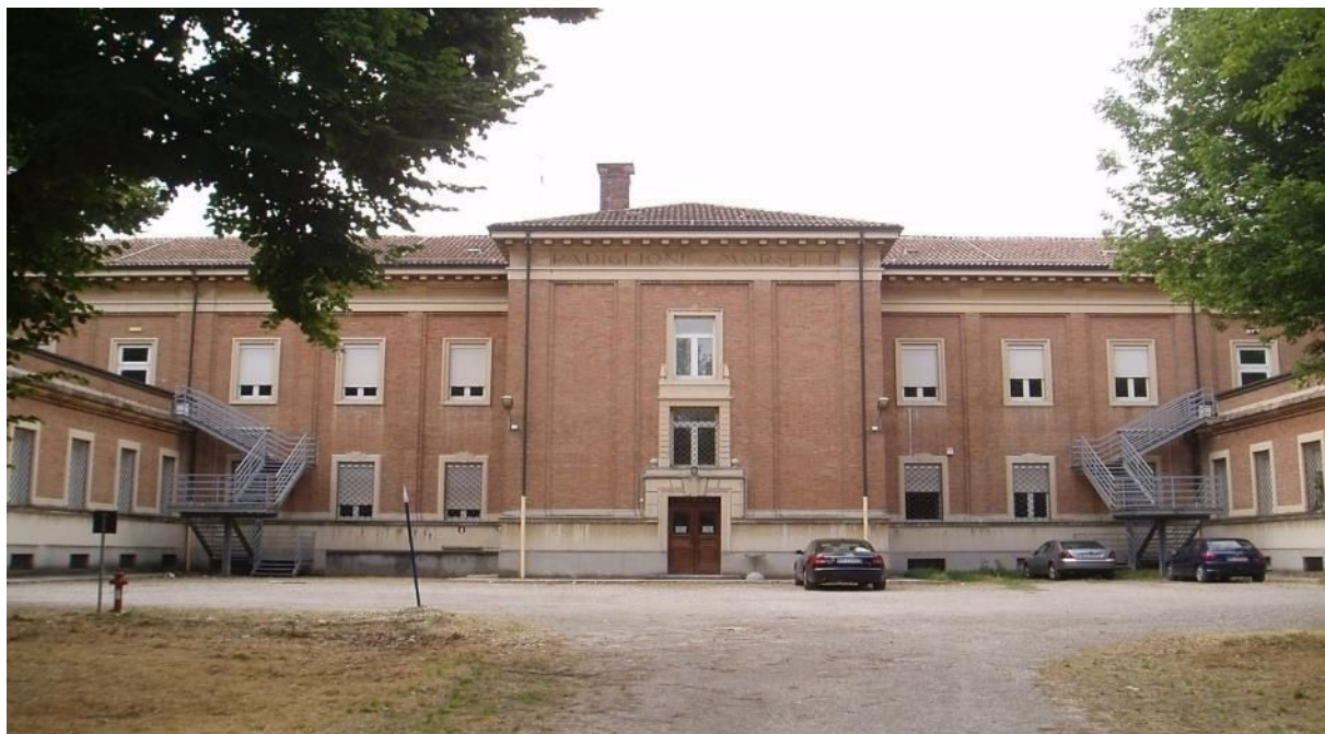
Figura 6-13. Prospetto nord Padiglione Morselli
