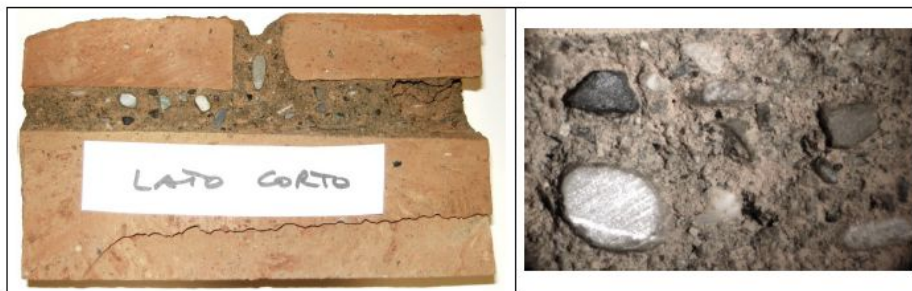
Figura 19_Saggio di muratura in mattoni pieni e malta di calce ed ingrandimento della malta con clasti interclusi ottenuto durante la campagna di indagini svolte presso il Padiglione Morselli, Reggio Emilia
