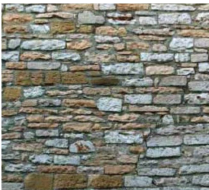
Figura 3-5_ Muratura in pietrame sbizzato con ricorsi di altezze differenti
