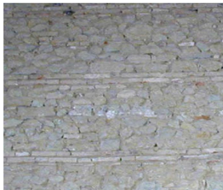
Figura 3-8_ Muratura mista listata
