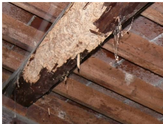
6-27_Elementi lignei di copertura.
