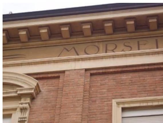
6-28_Lesioni della parte sommitale della muratura in corrispondenza delle capriate lignee.
