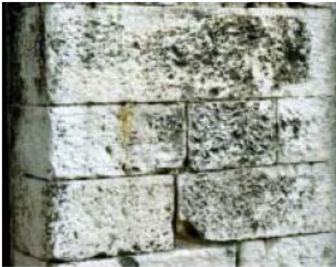
Figura 3-1_ Murature in pietrame con elementi lavorati e perfettamente squadriati.
