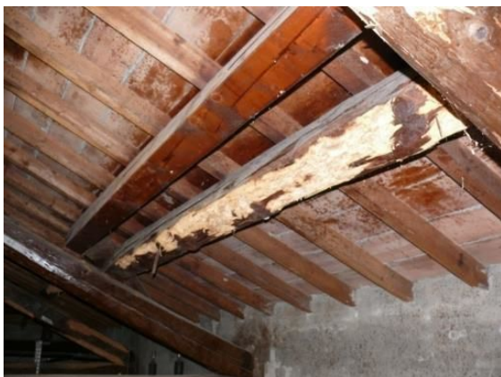
6-26_Elementi lignei di copertura.
