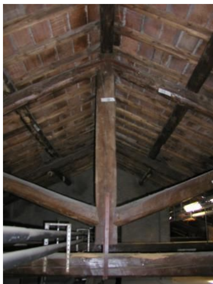
6-24_Elementi lignei di copertura, identificazione degli elementi.
