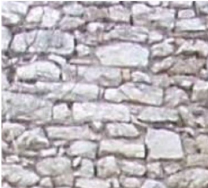
Figura 3-3_ Muratura in pietra a spacco: elementi pseudo rettangolari e cuneiformi organizzati in ricorsi sub-orizzontali.
