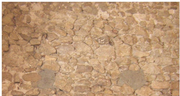
Figura 3-6_ Pietrame irregolare, ciottoli e pietre erratiche
