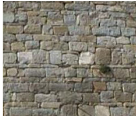
Figura 3-2_ Murature in pietrame con elementi lavorati.
