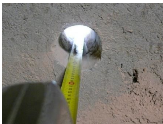
6-17_Murature, carotaggi, foro
