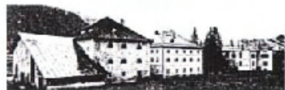
Sils Cuncas ...hier sind die Häuser in einer Reihe angeordnet, die einen Blick auf die Landschaft freigibt...
