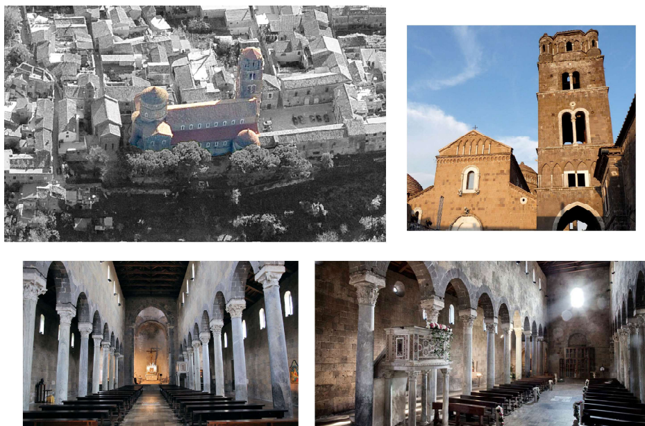
Figura 6.6: Viste esterne ed interne del Duomo di Casertavecchia, Caserta, Campania (Italia).
