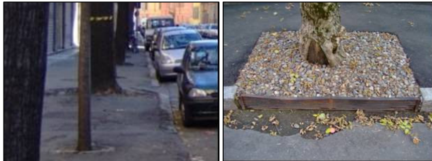
Figura 5.7 – Borgo San Giuseppe: rialzamento del cordolo di confinamento (sinistra) e via Bucci: confinamento in acciaio corten (destra)
