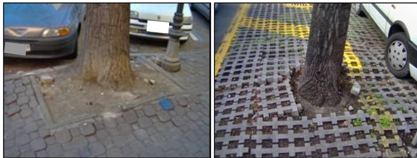
Figura 5.8 – via Costituente: pavimentazione in autobloccanti (sinistra) e viale Duca Alessandro: parcheggio in autobloccanti drenanti tipo garden (destra)
