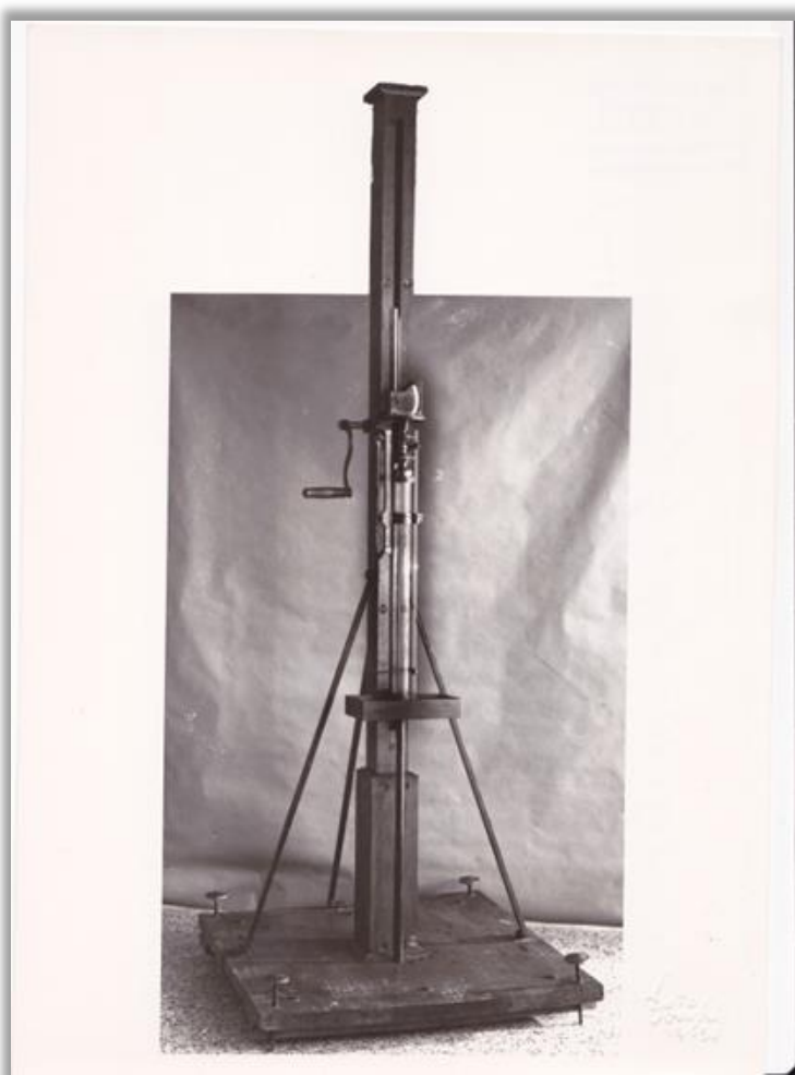
Figura 3.1. Igrometro originale fatto costruire dal Melloni per il Gabinetto di Fisica della Ducale Università di Parma. Attualmente è conservato nell'atrio del Plesso Fisico della Università; sono state sostituite le parti in ottone disperse durante l'ultima guerra (Foto Vaghi del 1954).
