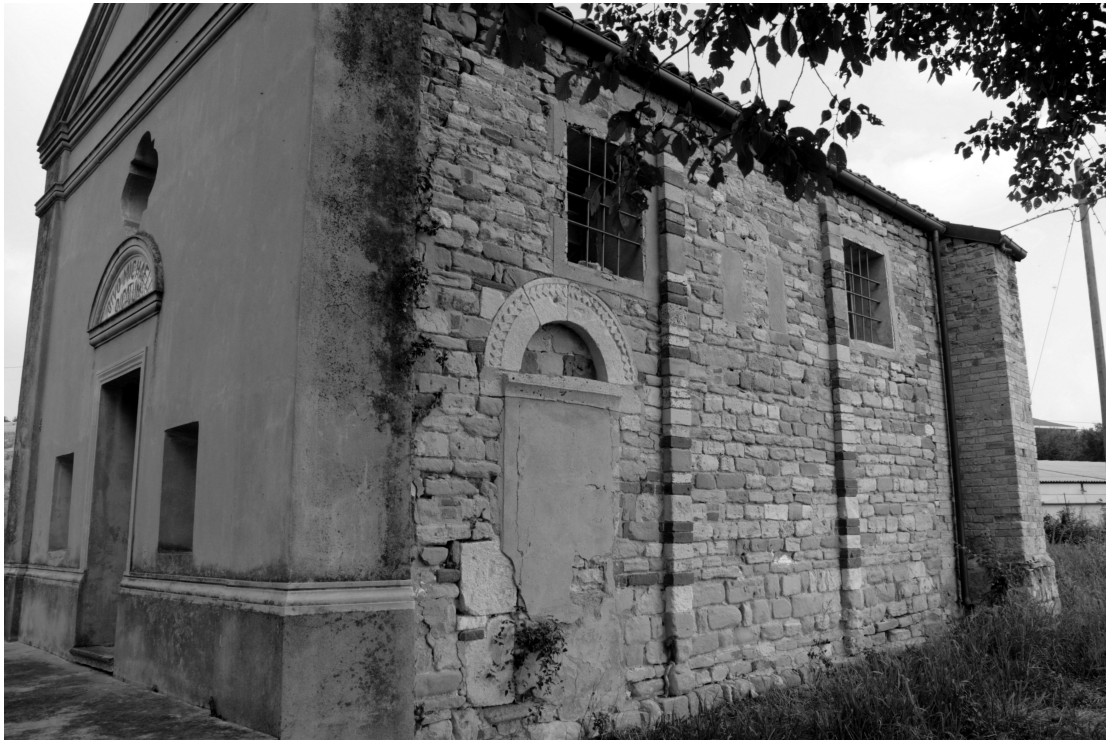
Fianco meridionale e facciata
