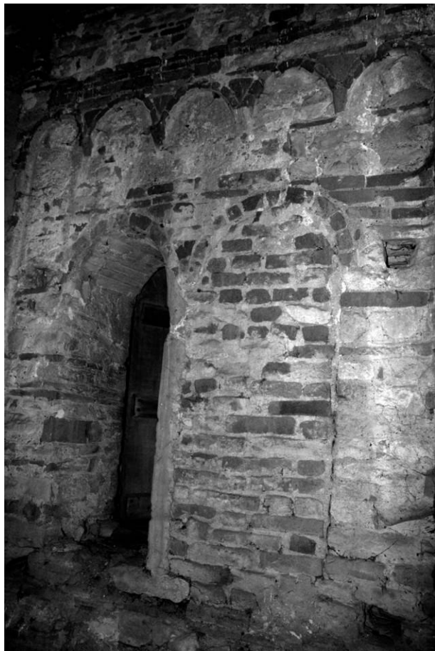
III livello del campanile, fianco nord (dai sottotetti della adiacente chiesa)
