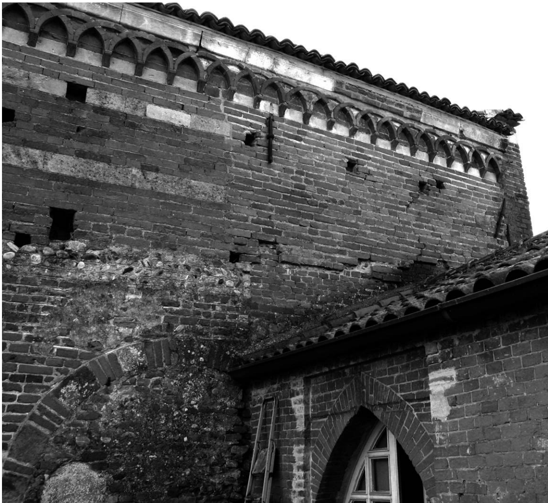
Fianco settentrionale: si notino le tre fasi di edificazione nella muratura di raccordo tra gli archi longitudinali (I), in quella della porzione orientale della fabbrica (II) e nella parte occidentale (III)
