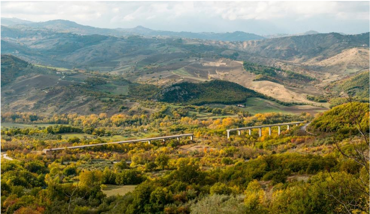
Fig. 5.27: Le Barche viaduct
