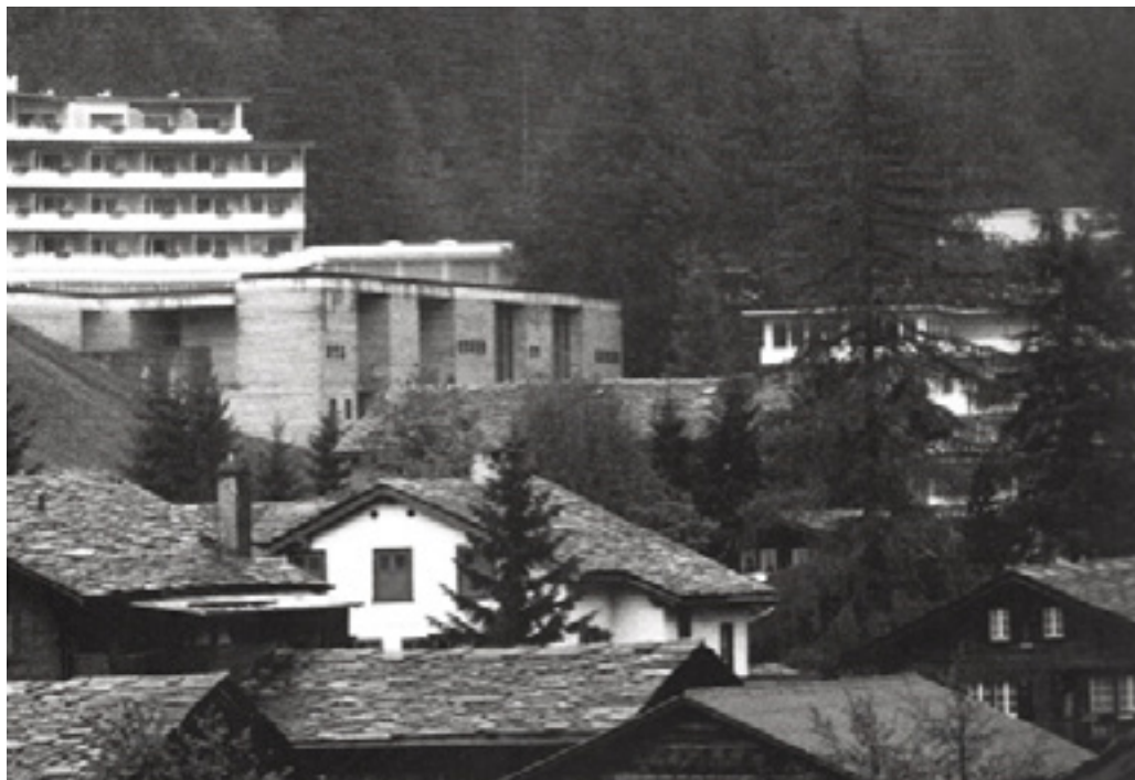
FIG. 25 - Vista delle terme come parte del paesaggio costruito. [da FONTE PRIVATA]
