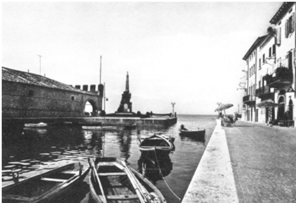
FIG. 12 - Il porto di Lazise in una fotografia dei primi del novecento. [da BORELLI p. 127]
