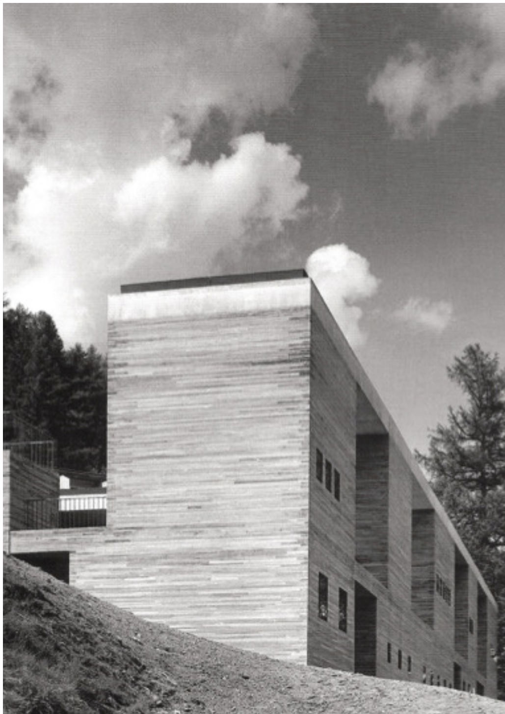
FIG. 24 - Vista laterale del complesso inserito nel pendio. [da FONTE PRIVATA]
